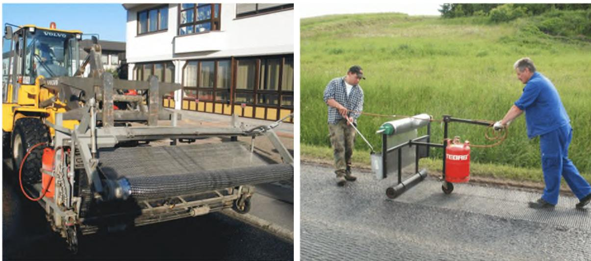
Abbildung 2-9 Links die maschinelle Abrollvorrichtung; rechts die händische Variante, [40]
