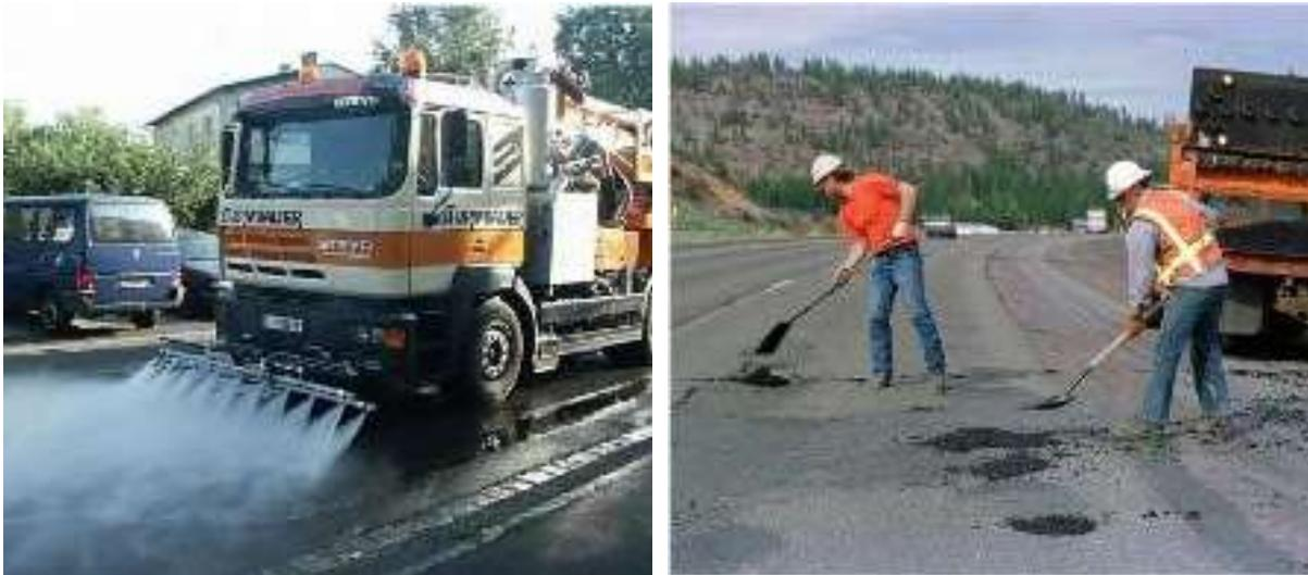
Abbildung 2-5 links Waschen der Oberfläche, rechts das Verfüllen von Schlaglöchern und Risse, [41]
