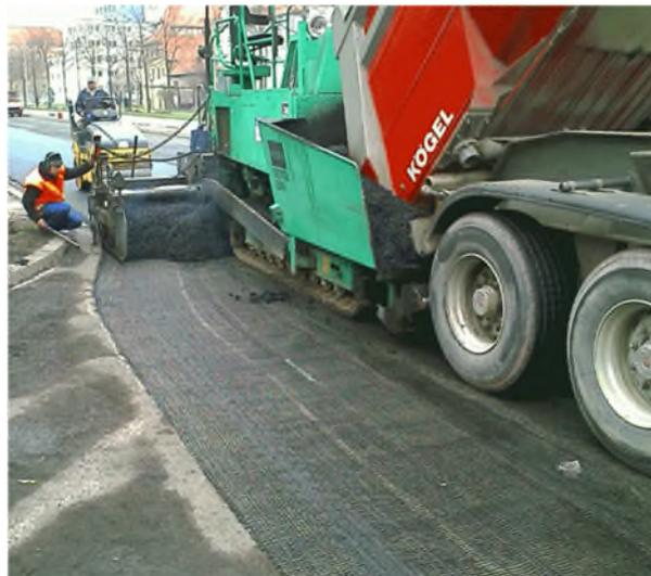
Abbildung 2-11 Überbau des Asphaltgitters mithilfe eines Fertigers, [40]
