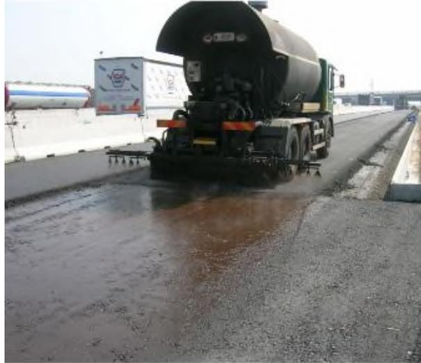
Abbildung 2-6 Vorspritzen der Bitumenemulsion, [41]
