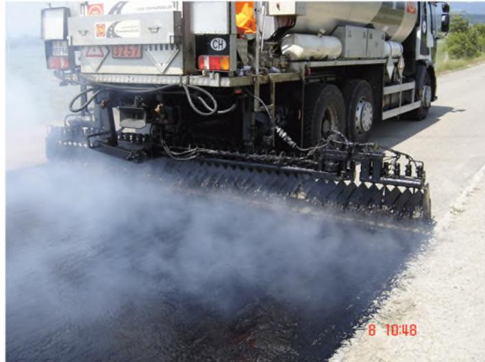
Abbildung 2-8 Vorspritzen mit Bitumenemulsion, [40]
