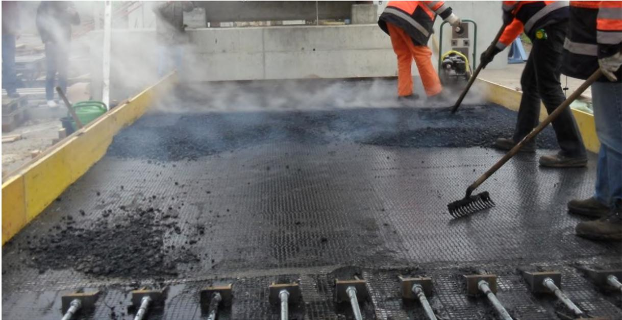
Abbildung 4-9 Herstellung der Platte „Heiß auf Kalt“ mit Asphaltbewehrung, [33].
