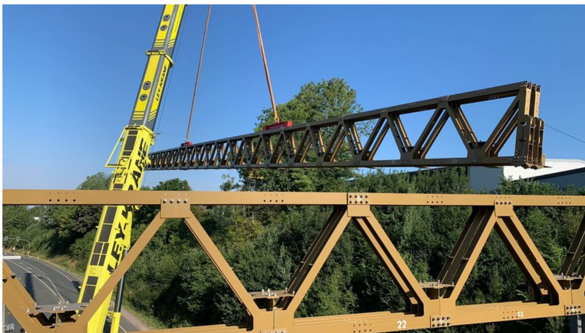
Abb. 3.7: D-Brückenträger mit 60 m Länge [78]
