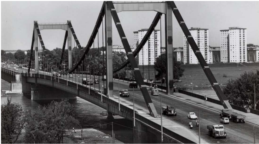
Abb. 2.12: Alte Reichsbrücke über die Donau, Wien [94]
