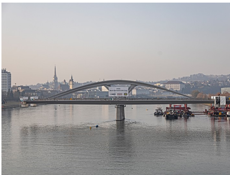
Abb. 2.4: Mittleres Tragwerk der neuen Eisenbahnbrücke über die Donau in Linz mit einer Länge von 120 m [84]
