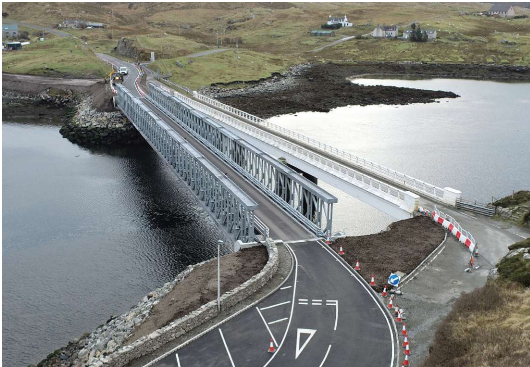
Abb. 3.6: 99 m lange Mabey Delta Brücke auf den Isles of Lewis [44]
