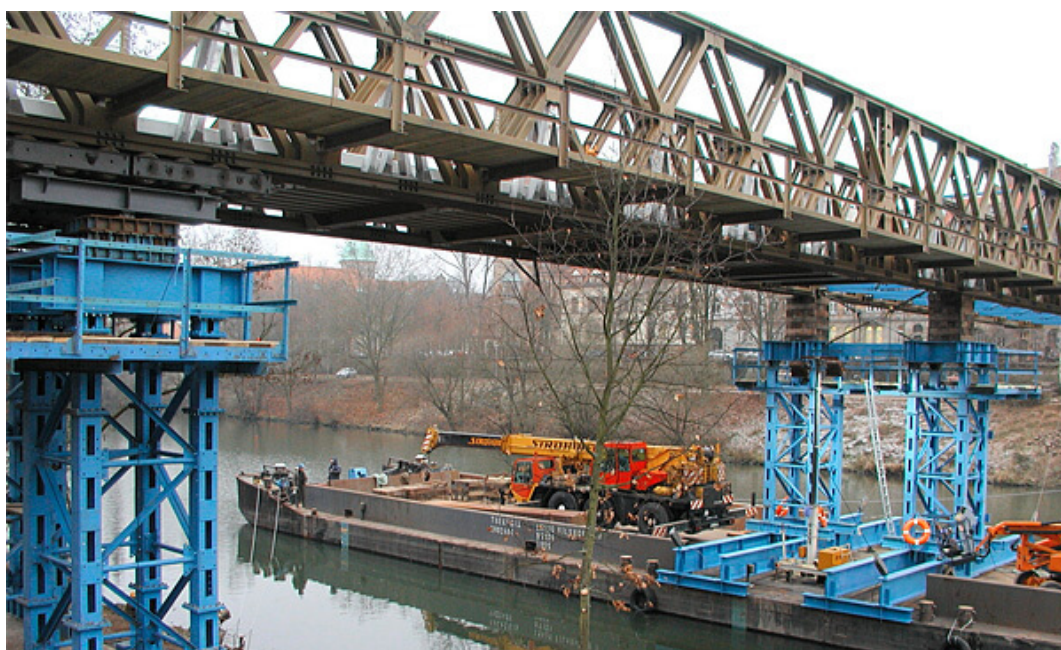
Abb. 2.23: D-Brücke auf temporären Stützen der Firma SEH Engineering GmbH [79]
