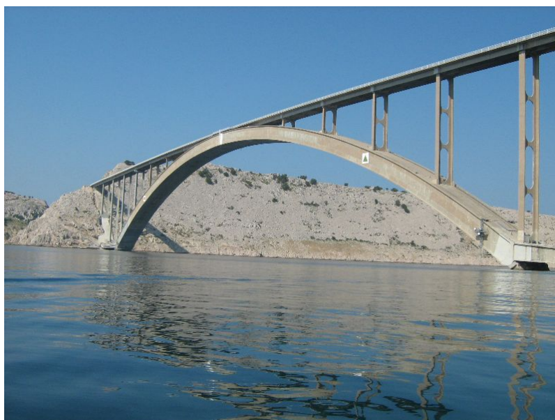
Abb. 2.9: Krk-Brücke, Kroatien, Größter Bogen [90]
