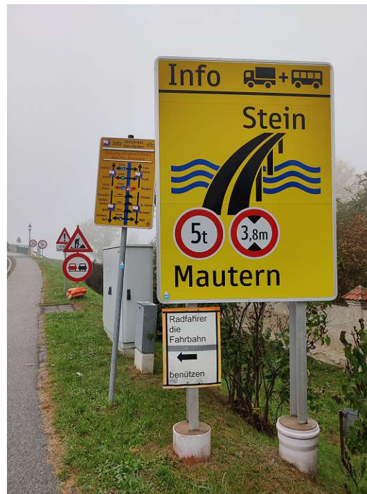
Abb. 6.2: Lasteinschränkung auf der Brücke Stein-Mautern [25]
