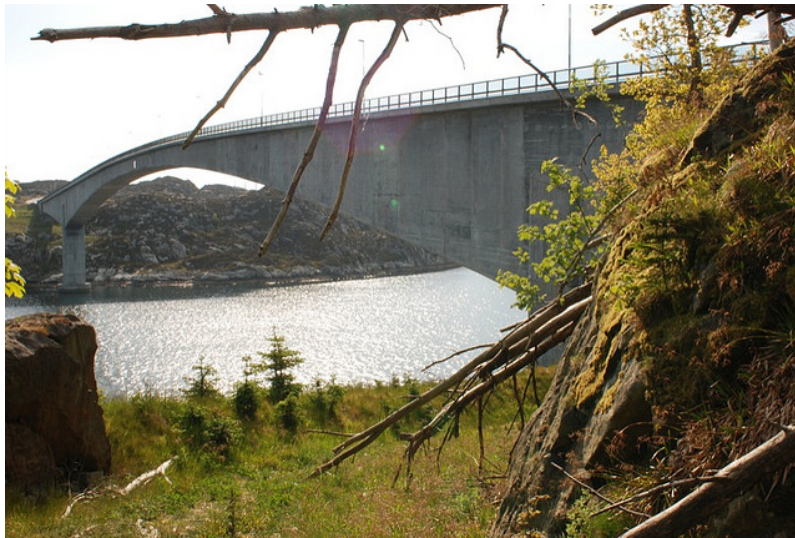
Abb. 2.3: Stolma-Brücke über die Stolmen zwischen den Inseln Stolmen und Selbjørn [54]
