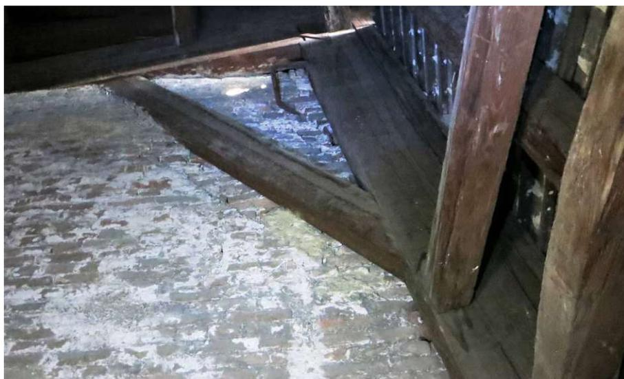
**Abb. 3.24:** „Abdrücke“ der alten Holzkonstruktion im Mauerwerk
