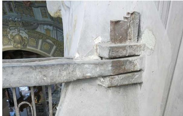
Abb. 3.16: Ringanker – Schließe mit Keil
