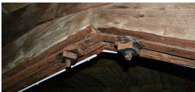
Abb. 2.7: Geknicktes Flacheisen
