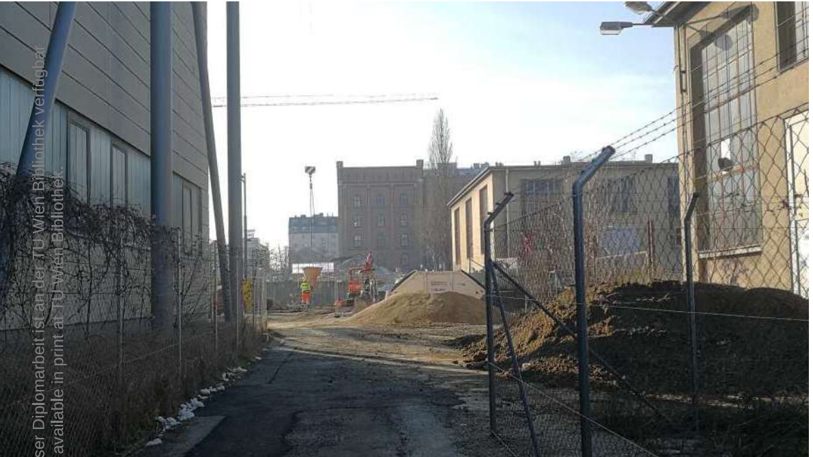
Abb. 045 Arsenal: Aushubarbeiten für die Wasserbauhalle am ehemaligen Standort des Objekt 219, Januar 2019 © Anne Altmeyer
