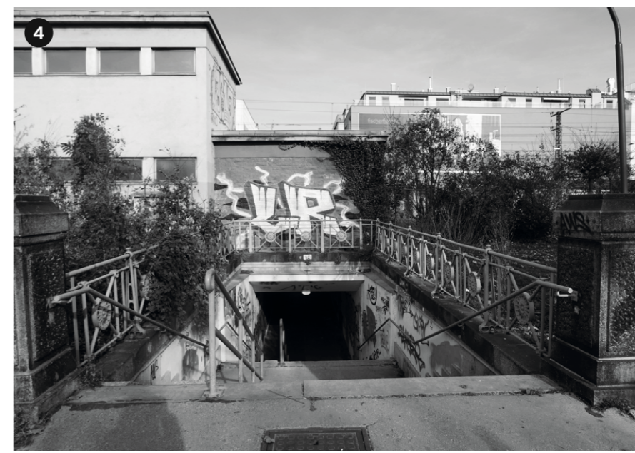
Abb.45: Zugang Unterführung Süd
