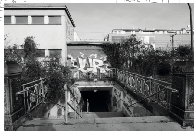
Abb.25: Eingang im Süden der Unterführung in Verlängerung der Einwanggasse
