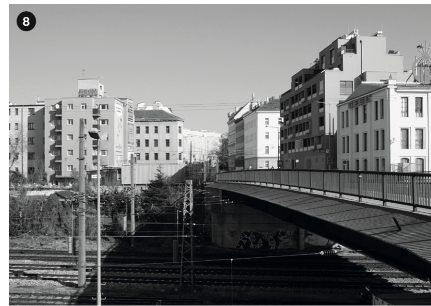
Abb.40: Ameisbrücke Blickrichtung Norden
