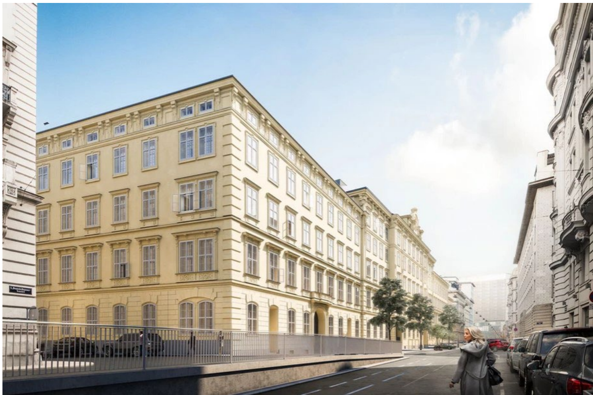
Abbildung 53: Alte Post Wien; Quelle: hochform Architekten ZT GmbH, 2022
