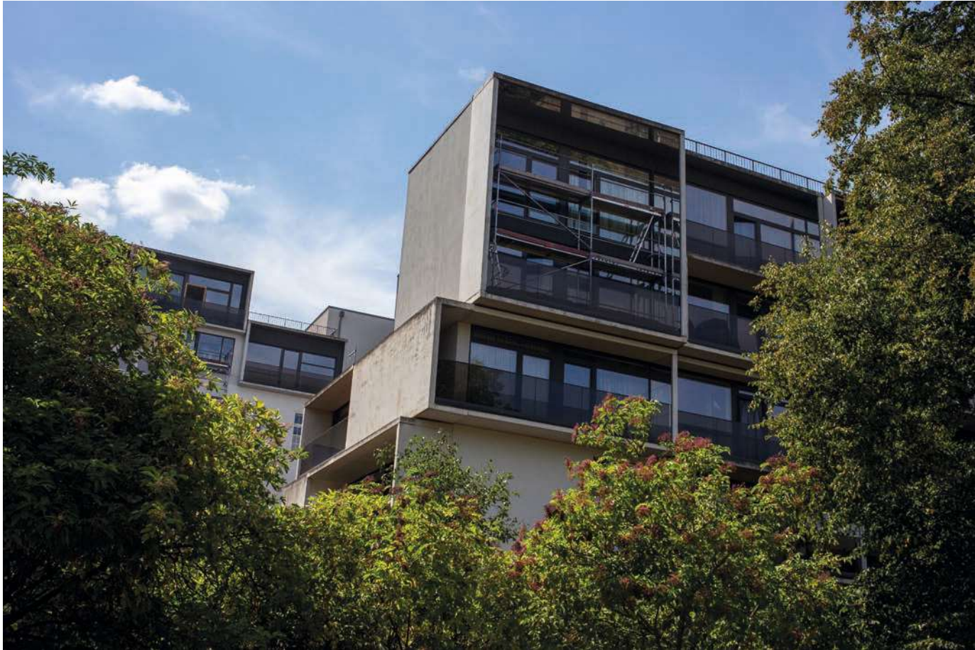
Abb.54: Neue Wohnbebauung an der Danziger Straße. Die Freiflächen sind privat.
