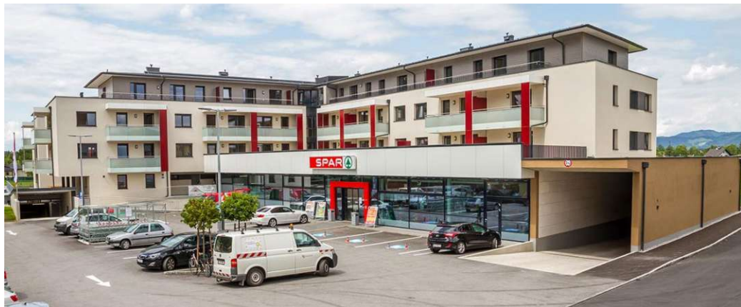
Abb. 33: Spar Grödig mit Wohnbau
