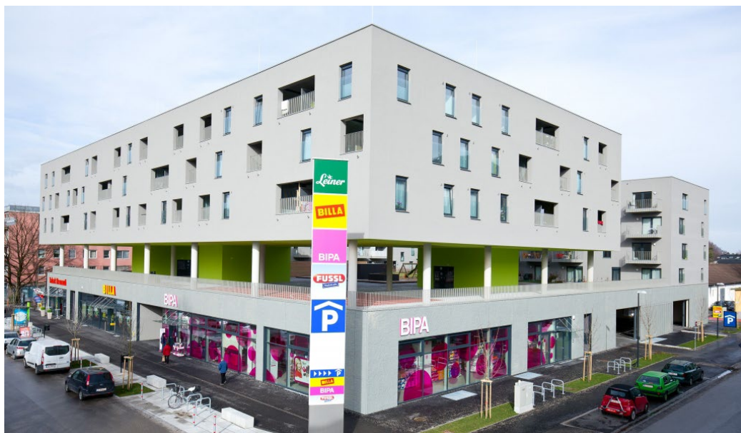
Abb. 32: Ginzkey Carré Wohn- und Geschäftsanlage
