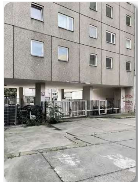
Durchgang Bauteil B. Hofseitig (4.00)
