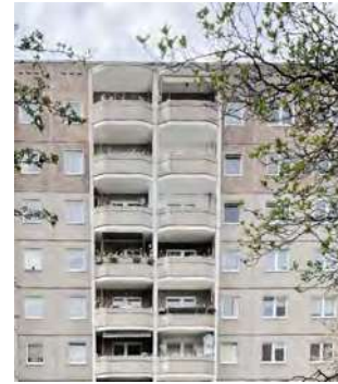
Waschbetonplatten gefärbt Klinkersteinen eingefasst Erkerbalkone
