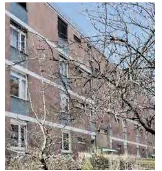
Betonplatten mit Mosaiken Platten verputzt
