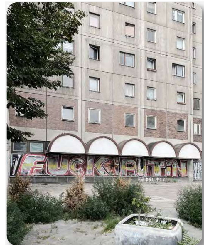
Abb. 114 Bauteil D. Erdgeschosszone straßenseitig
