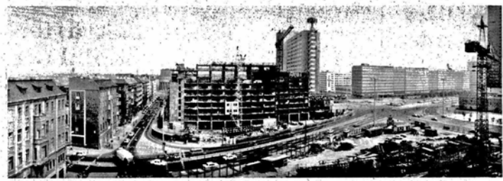
Blick auf die Baustelle an der Memhardstraße. Foto: BZ—Stark, Krausstocke
