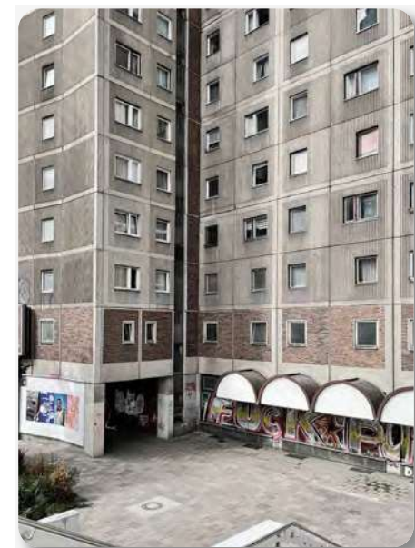
Vorplatz Bauteil D (5.00)
