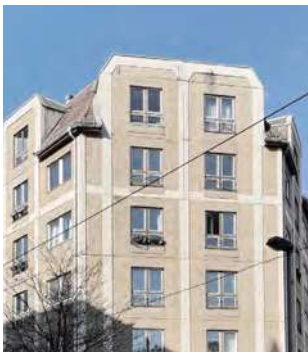
Waschbetonplatten Erker mit Ornamenten
