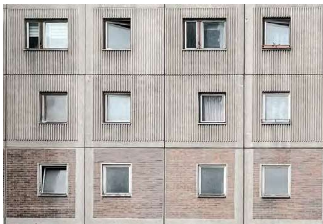
Abb. 97 Platten der Hauptfassade
