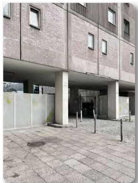
Durchgang Bauteil B. Straßenseitig (4.00)
