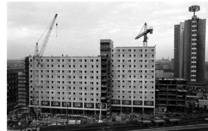
Abb. 46 Baustelle in der Memhardstraße. Berlin-Mitte
