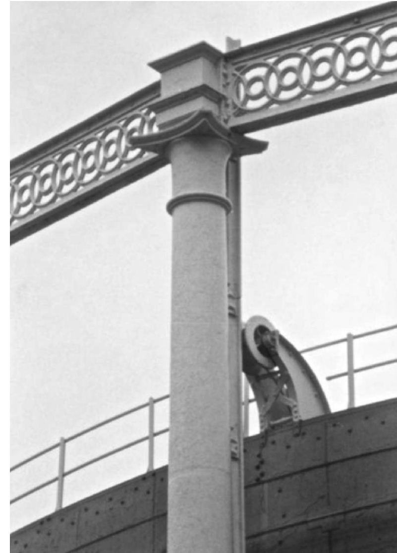
Abb. 15: Rahmenstruktur des Gasspeicher No. 2
