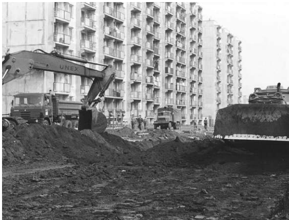
Abb. 36: Straßenarbeiten (KrMuz 1992d)
