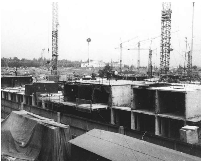
Abb. 50: Beginn der Arbeiten in Tunnelschalbauweise (KrMuz 1991c)
