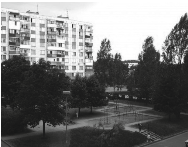
Abb. 42: Innenhof mit Lampe (id9945475 2008)
