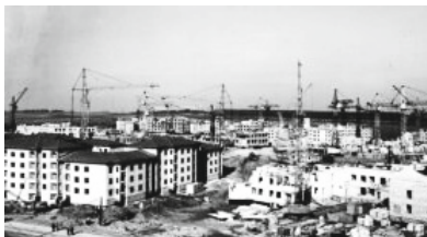
Abb. 56: Einziges Foto von Bauarbeiten der Siedlung Ross' (Mölsä 2016)
