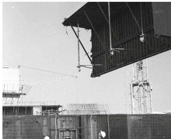
Abb. 53: Tunnelschalung von Pozemné Stavby Nitra (TASR 2015)
