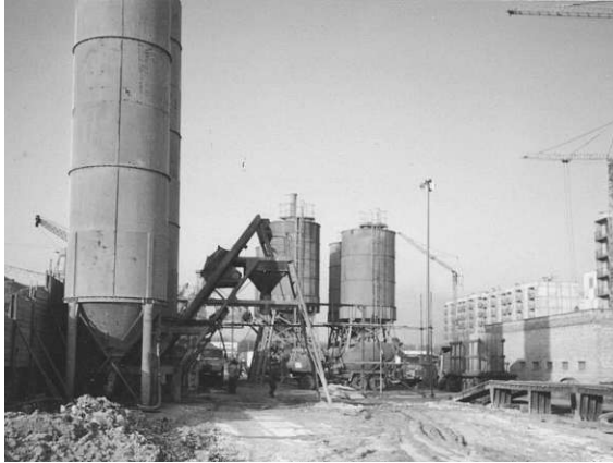
Abb. 34: Betonfabrik (KrMuz 1992a)
