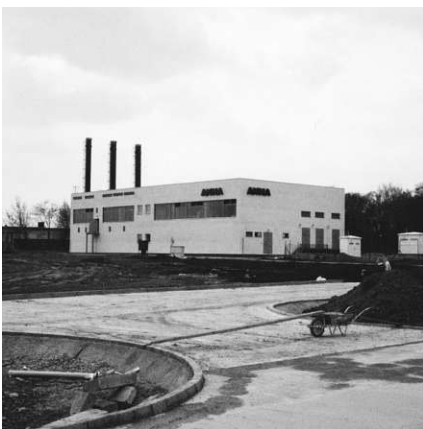
Abb. 49: Digital gesteuertes Heizkraftwerk (KrMuz 1992d)
