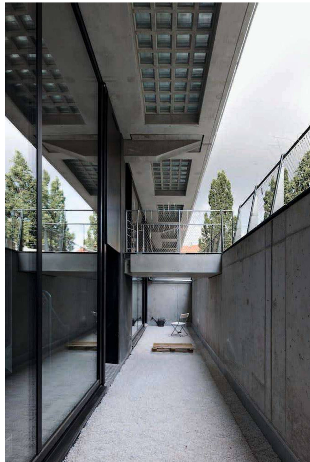
Abb. 87 Alberts: Souterrain und Steg
