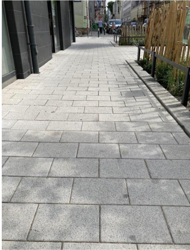
**Abbildung 37:** Neues Pflaster mit hohem Albedowert und Baumschatten in der “Kühlen Meile Zieglergasse” im Juni 2022 (Eigene Aufnahme).
