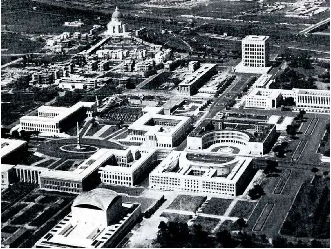
Abb. 71:Luftbild gebauter Strukturen, 1956 , Wikimedia Commons
