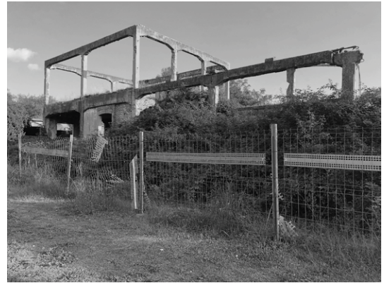
Abb. 143: Skelett Fabrikgebäude Prenestino, Eigenes Foto 2022
