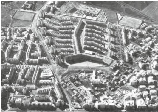
Abb. 25: Luftbild Quartiere II während Bauzeit
