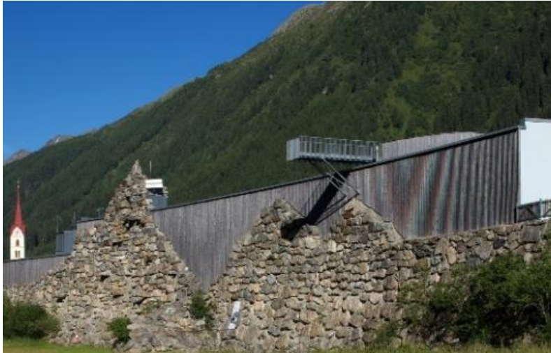
Abb. 39 Schutzmauer des Alpinerium Galtür, (Alpinerium Galtür 2014)
