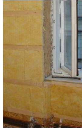
Abbildung 29: Ausführungssimulation und Rohbau für Wiener Komfortfenster mit Innendämmung, (IBO Magazin 1/14; 2023 / Themenworkshop Architekt DI Georg Lux )
