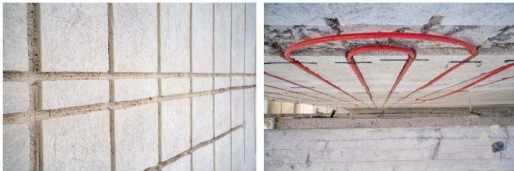
Abbildung 26: Links: Nut-Fräsungen in der Außenwand, rechts: Heizungsrohre in der Außenwand, vor Herstellung der Wärmedämmung (BMK, Große Neugasse, Sanierung und Heizungsumstellung mit fassadenintegrierter Bauteilaktivierung, 2022, 9).
