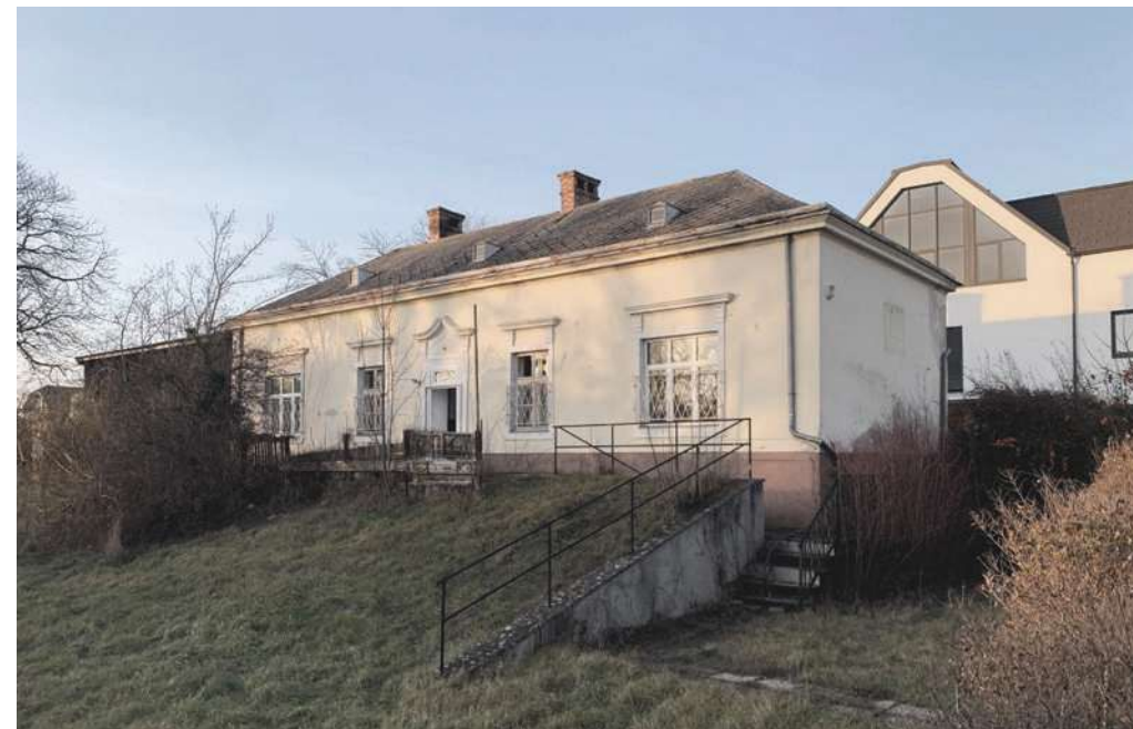
Abbildung 24: Blick von Gartenseite auf das Albertihaus 2023
