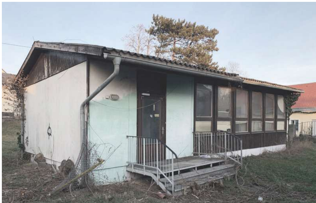
Abbildung 23: Blick auf ehemaliges Klassenzimmer (Hintergrund Perlashof) 2023
