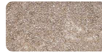
Wassergebundene Decke (Splitt/ Kies/Schotter) - Nebenwege
