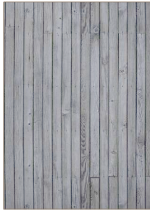
Abb. 80 Dach: Terrassendielen (Holz)
