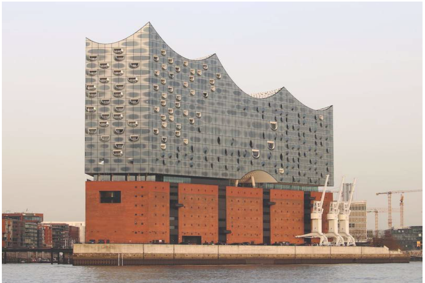
Abb. 31 Speicherstadt in Hamburg mit Ausblick nach Elbphilharmonie von Herzog and de Meuron
