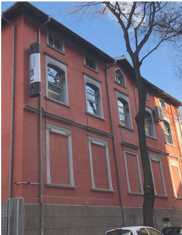
Abb. 27 Tabaklager auf der „Exarch Yosif“ Straße 13
