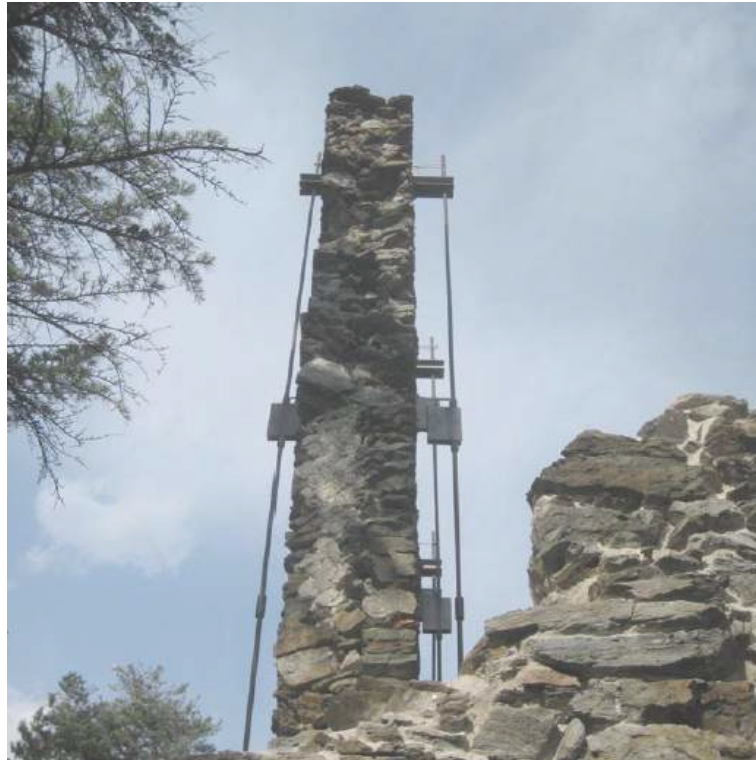
Abb. 65 Verstärkungsstruktur Forte di Fuentes, Italien
