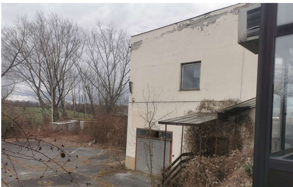
Abb.22 : Zustand des Bestandsgebäudes
