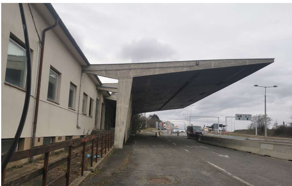
Abb.19 : Die Beziehung zwischen dem Dach und dem Bestandsgebäude
