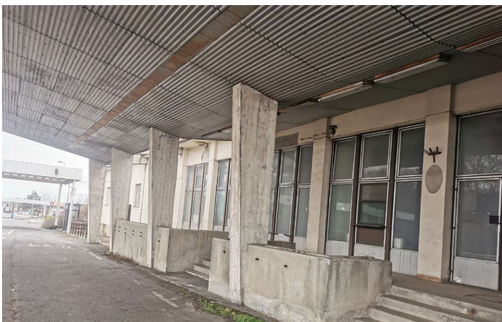
Abb.18: Zustand des Bestandsgebäudes unter dem Dach
