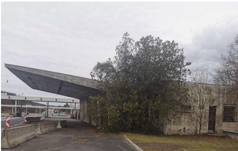
Abb.17 : Zustand des Bestandsgebäudes an der Grenze
