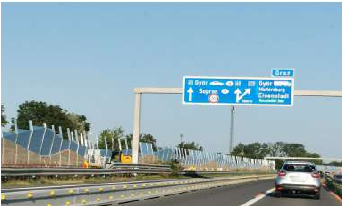
Abb.14 : A3 - Bau der Lärmschutzwand
