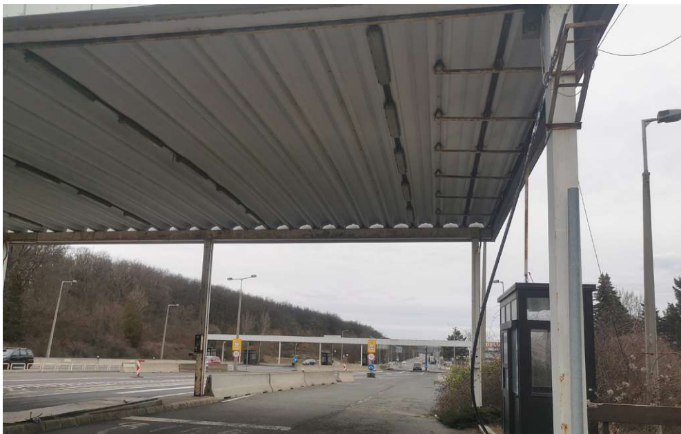
Abb.20: Verrostung von Strukturen
