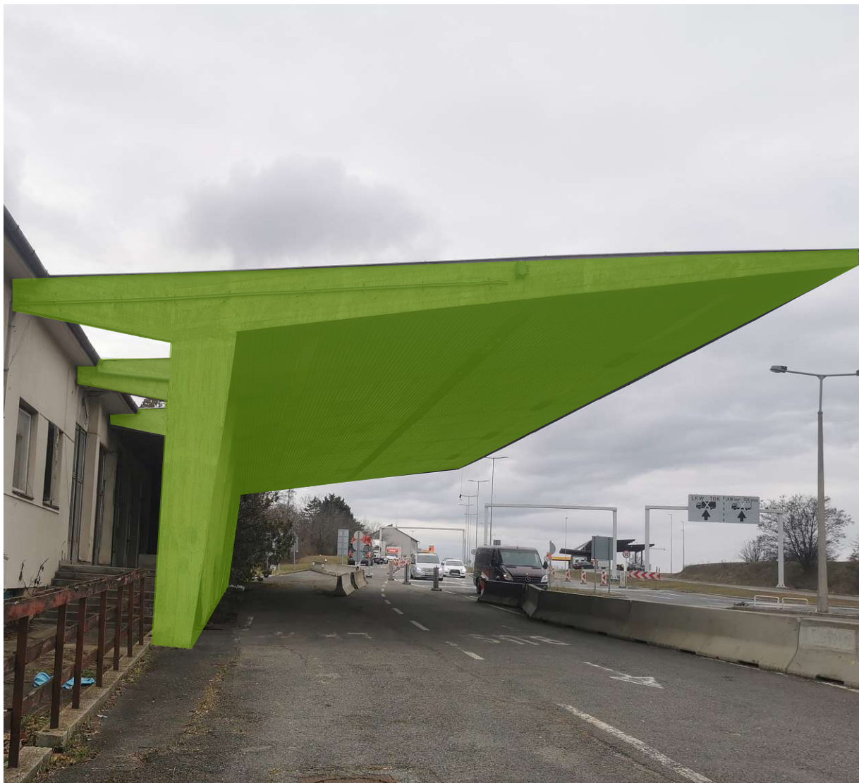
Abb.23 : Das verbleibende Dach
