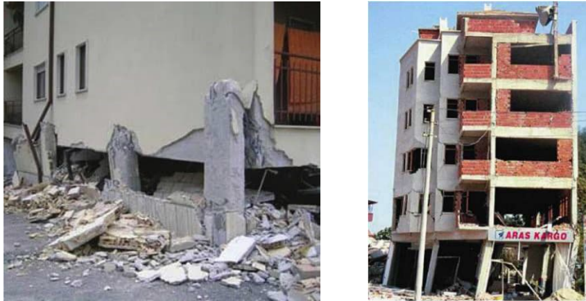
Abb. 12: Versagen wegen des „Soft Storey“ Mechanismus nach L’Aquila Erdbeben 2009 [13] (links); Izmit-Erdbeben 1999 [38] (rechts)
