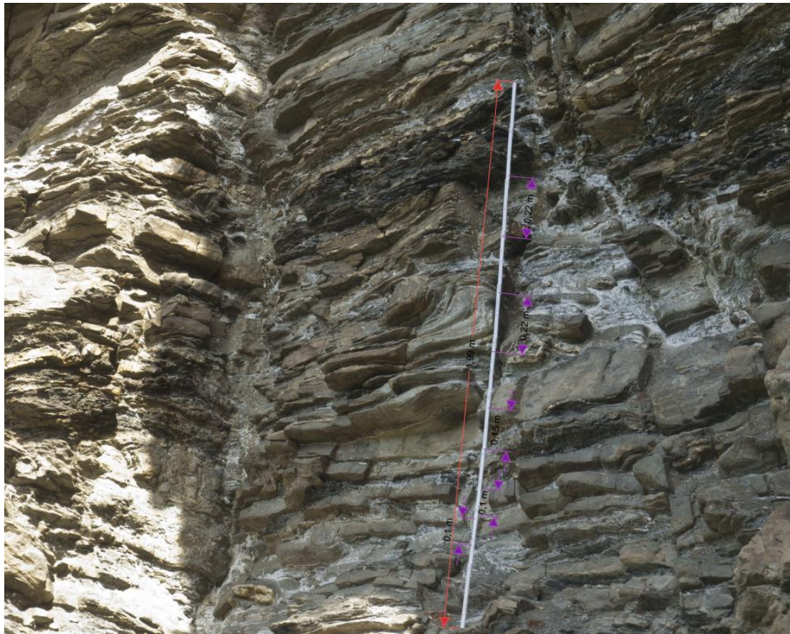
Abbildung 5-11: Ermittlung des RQD-Werts von Vals_003 (Foto bereitgestellt von Sausgruber)
