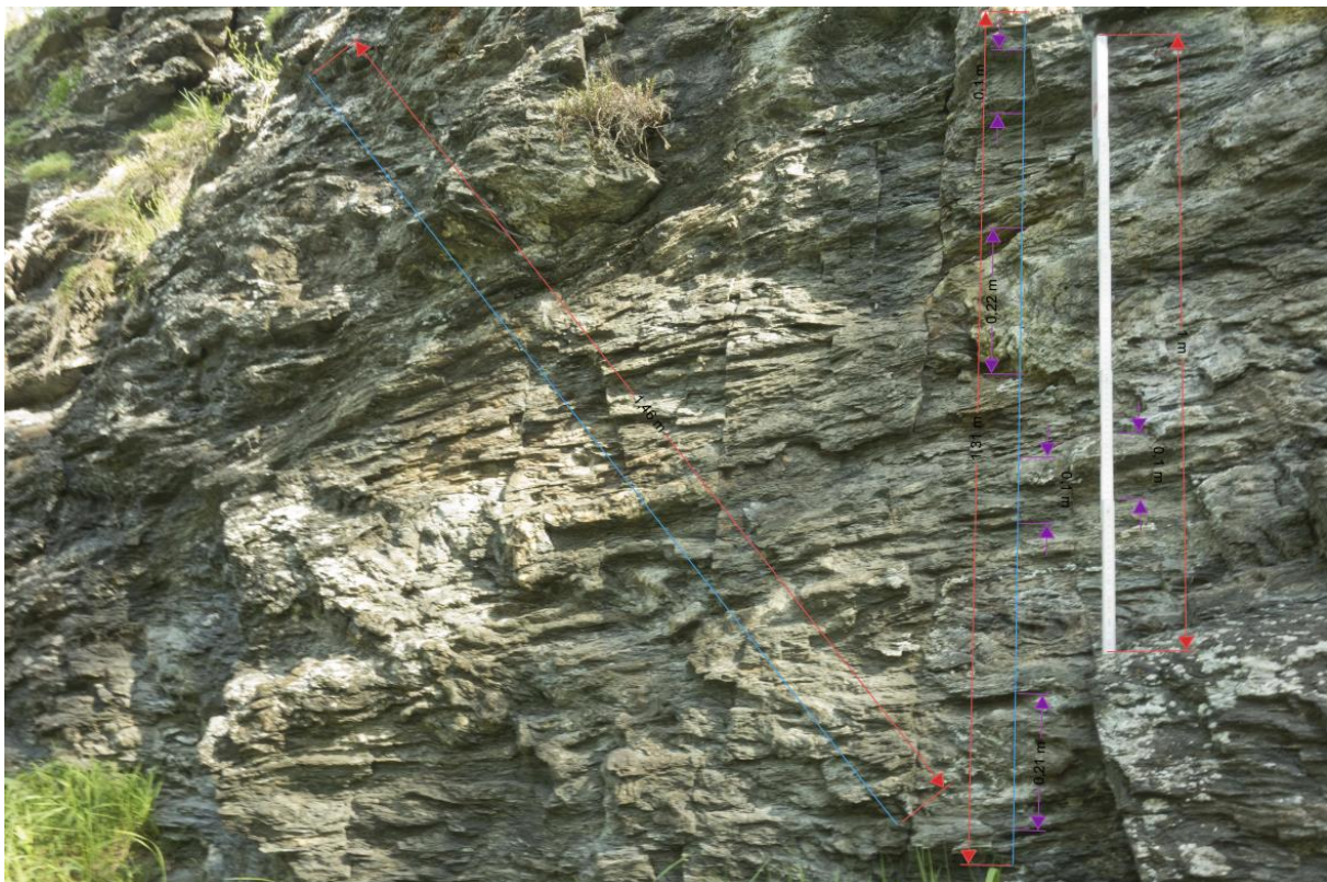
Abbildung 5-12: Ermittlung des RQD-Werts von Vals_042 (Foto bereitgestellt von Sausgruber)
