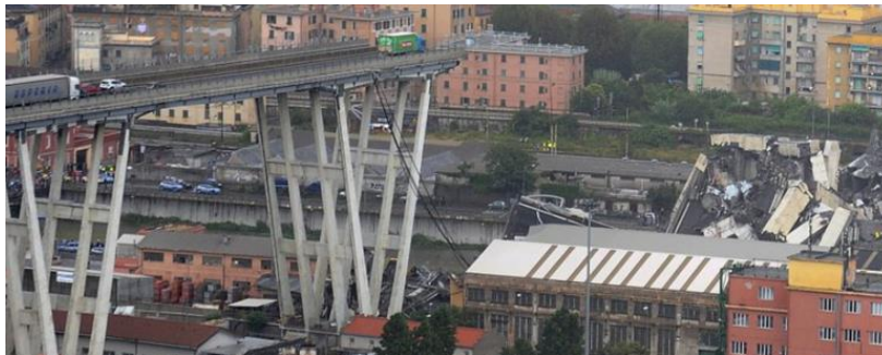
Abb. 2.1: Brückeneinsturz in Genua, Italien (August 2018) [22]
