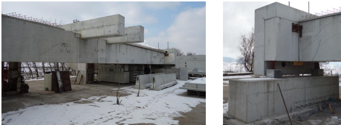
Abb. 3.5: Links: Bestandssituation, Rechts: Blick auf linkes Widerlager
