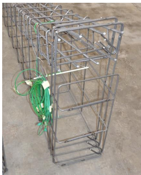
Abb. 3.15: Darstellung der am Bewehrungskorb angebrachten Temperatursensoren des zweiten Bogens
