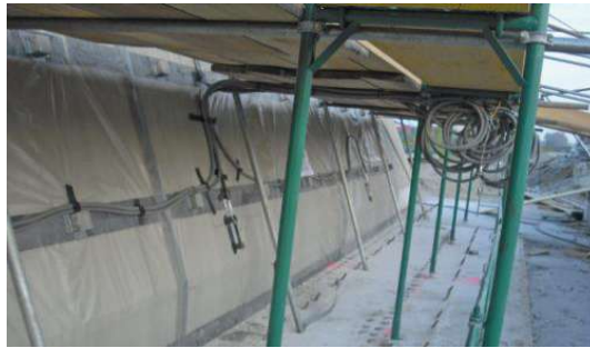
Abb. 2.10: Erddruckmessung über Druckkissen (Seitenhafenbrücke) [1]
