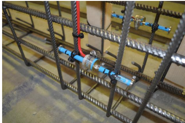
Abb. 3.18: Darstellung der angebrachten Schwingsaitensensoren im noch seitlich liegenden Bewehrungskorb
