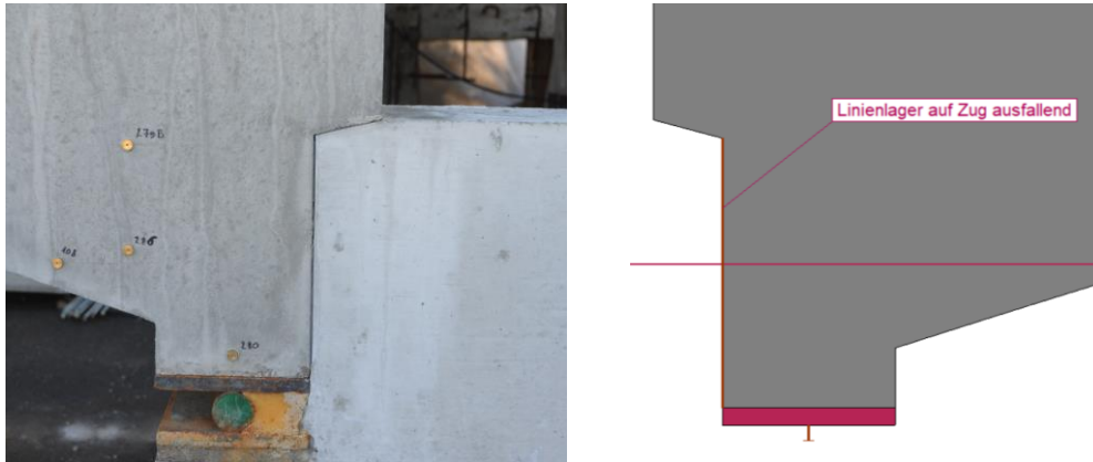
Abb. 3.49: Links: Anschluss „Widerlager-Bogen“, Rechts: Darstellung des dazugehörigen Berechnungsmodells
