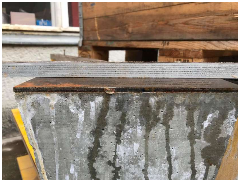
Abb. 49: Aufschüsseln der Stahlplatte, a) Stumpfstoß ohne Aufweitung, b) Stumpfstoß mit Aufweitung
