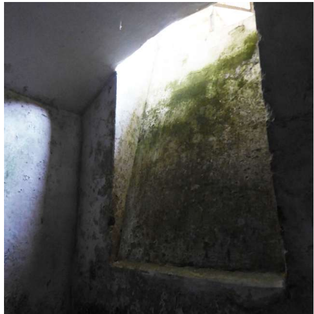
Abb. 51: Nahaufnahme Schimmelbildung
