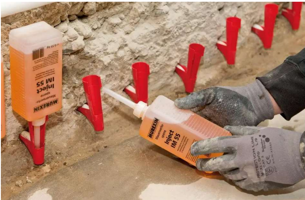
Abb. 15: Injektionsverfahren
