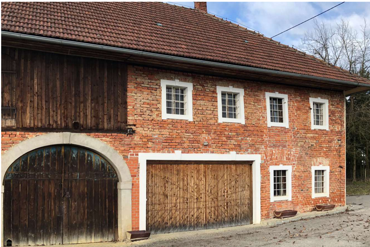
Abb. 30: Fassade Ost (Nord)
