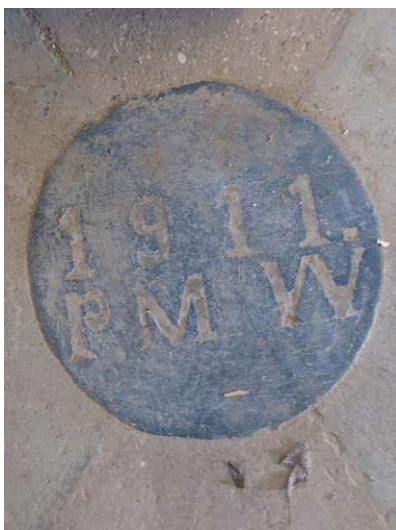
Abb. 44: Datierung in Beton
