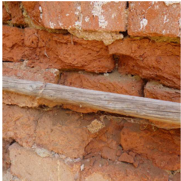
Abb. 53: Nahaufnahme Absanden
