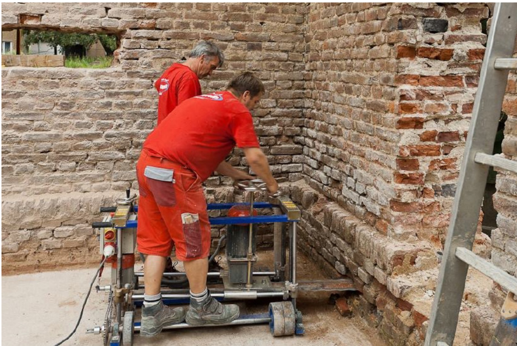
Abb. 14: Mechanisches Verfahren
