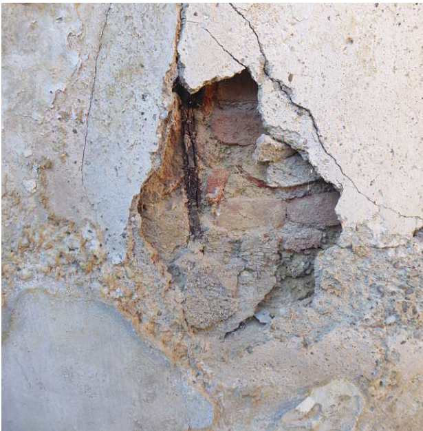
Abb. 50: Nahaufnahme Abplatzung
