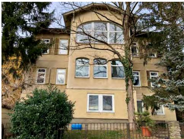
Abb. 214: Tullnerbach-Lawies, Egererstraße 26, Südsansicht
