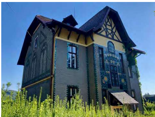
Abb. 118: Tullnerbach-Lawies, Franz-Schubert-Straße 19, Villa Elfi, Nord-/Ostansicht
