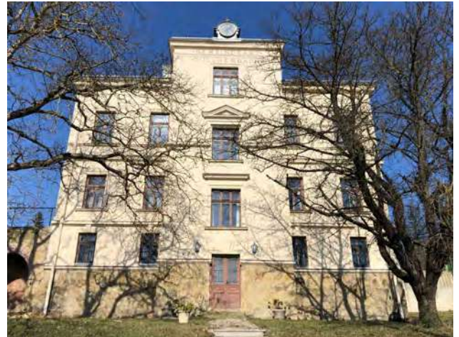
Abb. 419: Tullnerbach-Lawies, Knabstraße 7, Südansicht
