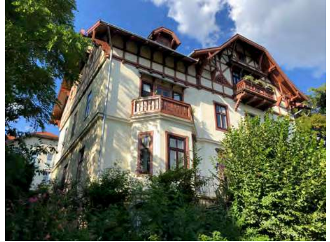
Abb. 407: Tullnerbach-Lawies, Knabstraße 5, Südansicht
