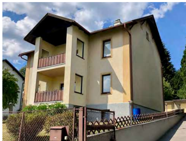
Abb. 231: Tullnerbach-Lawies, Egererstraße 34, Süd-/Ostansicht
