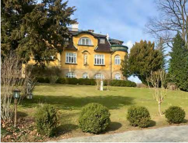
Abb. 193: Tullnerbach-Lawies, Egererstraße 10, Südsansicht
