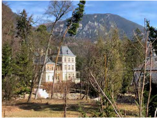
Abb. 147: Reichenau, Villa Wartholz, Süd-/ Westfassade
