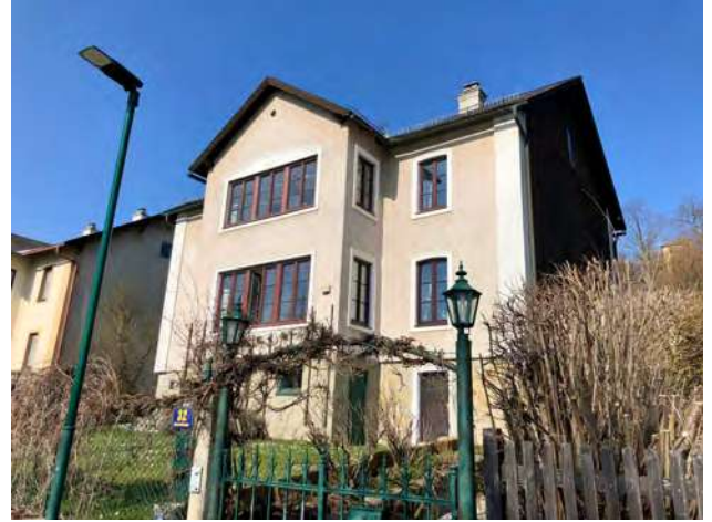
Abb. 225: Tullnerbach-Lawies, Egererstraße 32, Süd-/Ostansicht
