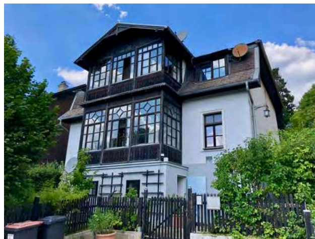
Abb. 222: Tullnerbach-Lawies, Egererstraße 30, Südsicht
