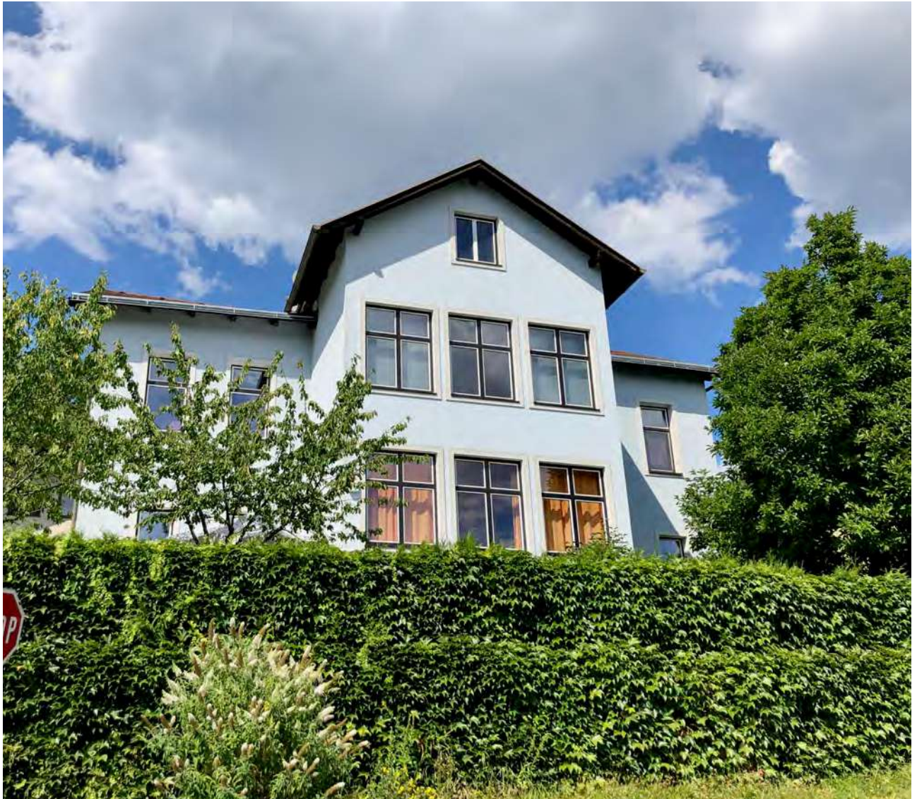
Abb. 233: Tullnerbach-Lawies, Egererstraße 36, Südansicht
