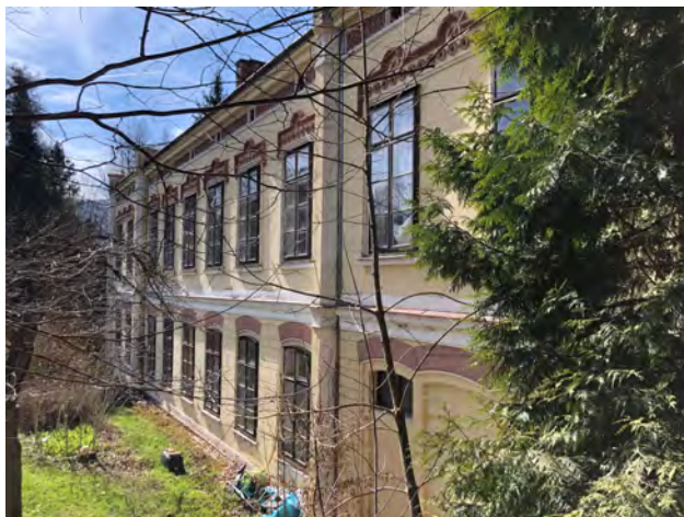
Abb. 142: Reichenau, Rudolfsvilla, Gartenfassade
