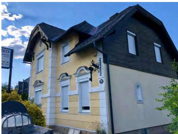
Abb. 387: Tullnerbach-Lawies, Hauptstraße 40, Süd-/Ostansicht
