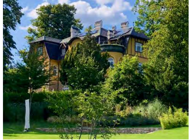
Abb. 194: Tullnerbach-Lawies, Egererstraße 10, Süd-/Ostansicht
