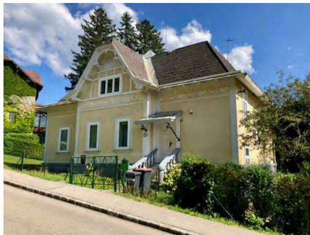
Abb. 111: Tullnerbach-Lawies, Genéestraße 8, Villa von „Honus & Lang“, Nord-/Westansicht
