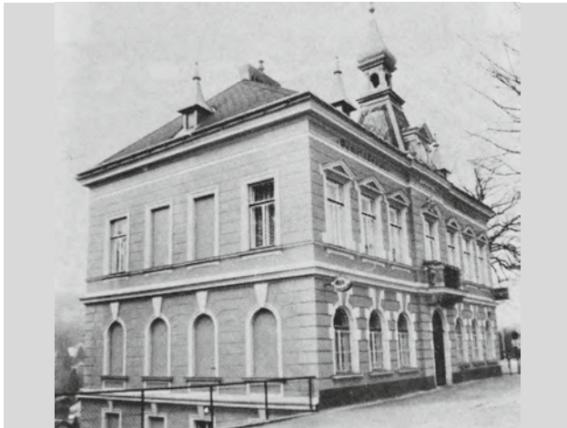
Abb. 420: Tullnerbach-Lawies, Knabstraße 9, Historisches Foto, Straßenansicht
