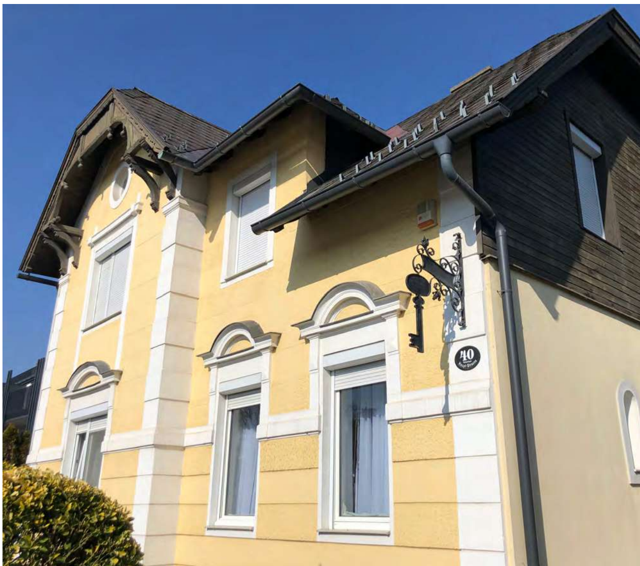
Abb. 389: Tullnerbach-Lawies, Hauptstraße 40, Süd-/Ostansicht
