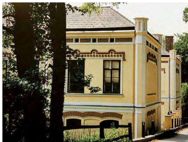
Abb. 145: Reichenau, Rudolfsvilla (Haus „Auf der Waag“), Straßenansicht, Foto vor 1995
