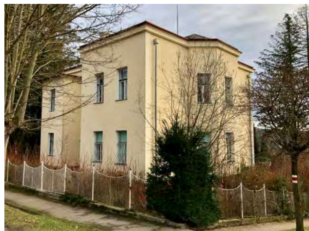
Abb. 31: Tullnerbach-Lawies, Franz-Schubert-Straße 5, Villa mit Eck- und Mittelrisalit, Nord-/Westansicht
