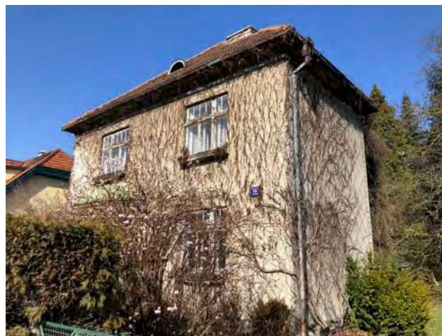
Abb. 382: Tullnerbach-Lawies, Hauptstraße 36, Süd-/Ostansicht
