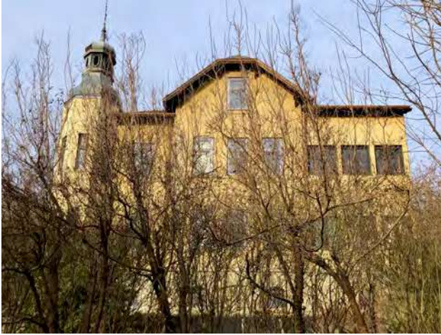
Abb. 210: Tullnerbach-Lawies, Egererstraße 22, Südansicht
