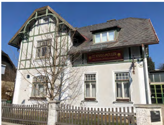
Abb. 384: Tullnerbach-Lawies, Hauptstraße 38, Südansicht
