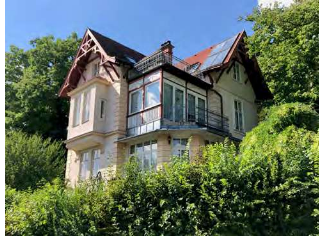
Abb. 351: Tullnerbach-Lawies, Genéestraße 13, Süd-/Ostansicht
