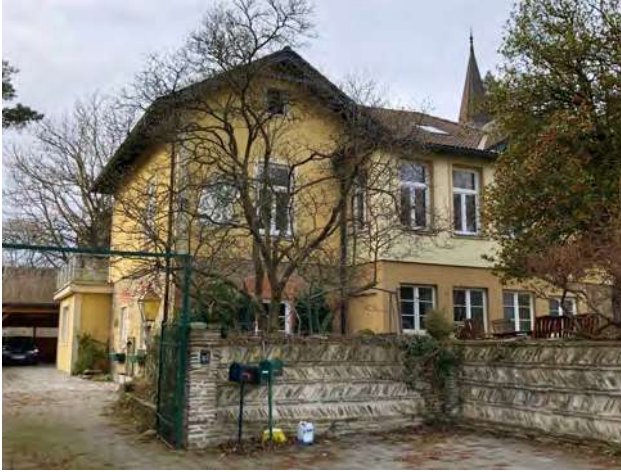
Abb. 236: Tullnerbach-Lawies, Egererstraße 38, Süd-/Ostansicht
