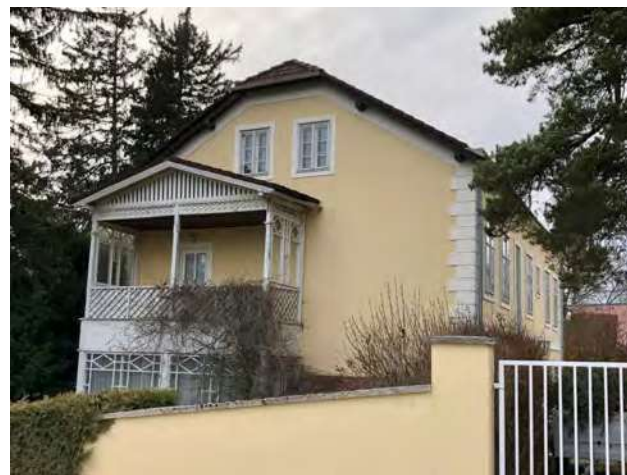
Abb. 240: Tullnerbach-Lawies, Egererstraße 40, Nord-/Ostansicht
