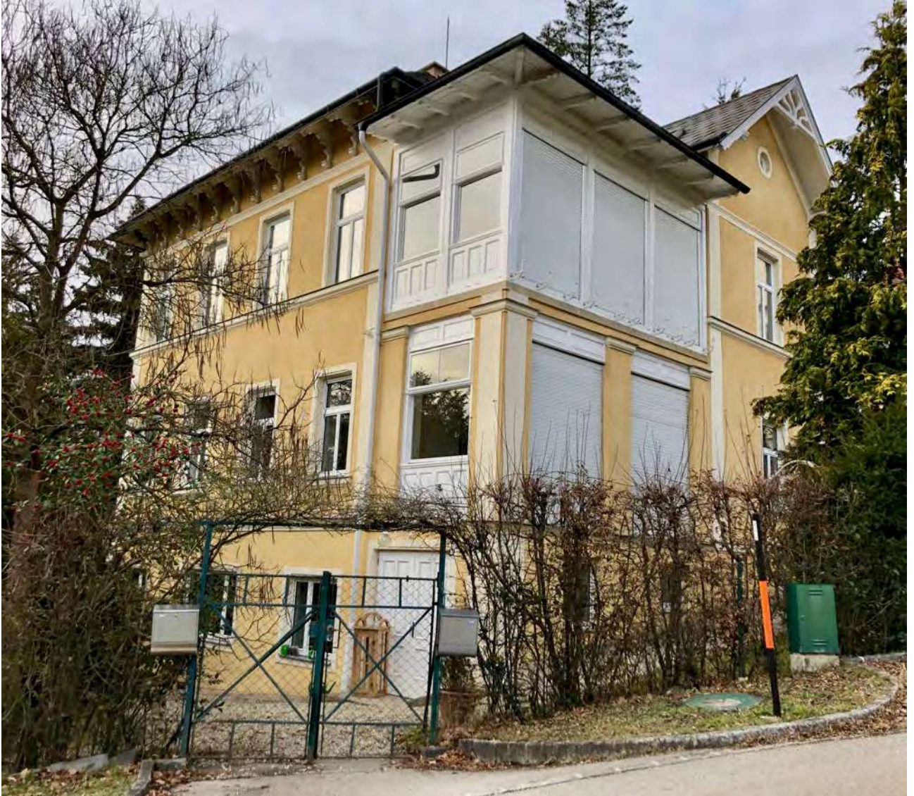
Abb. 331: Tullnerbach-Lawies, Genéestraße 7, Süd-/Ostansicht
