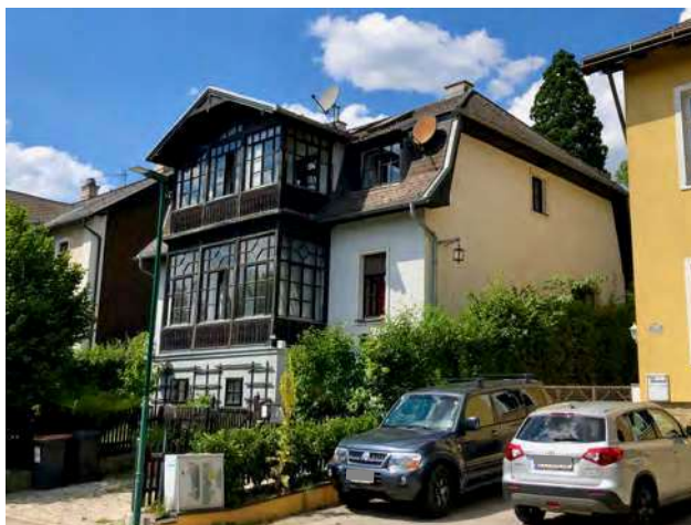
Abb. 221: Tullnerbach-Lawies, Egererstraße 30, Süd-/Ostansicht
