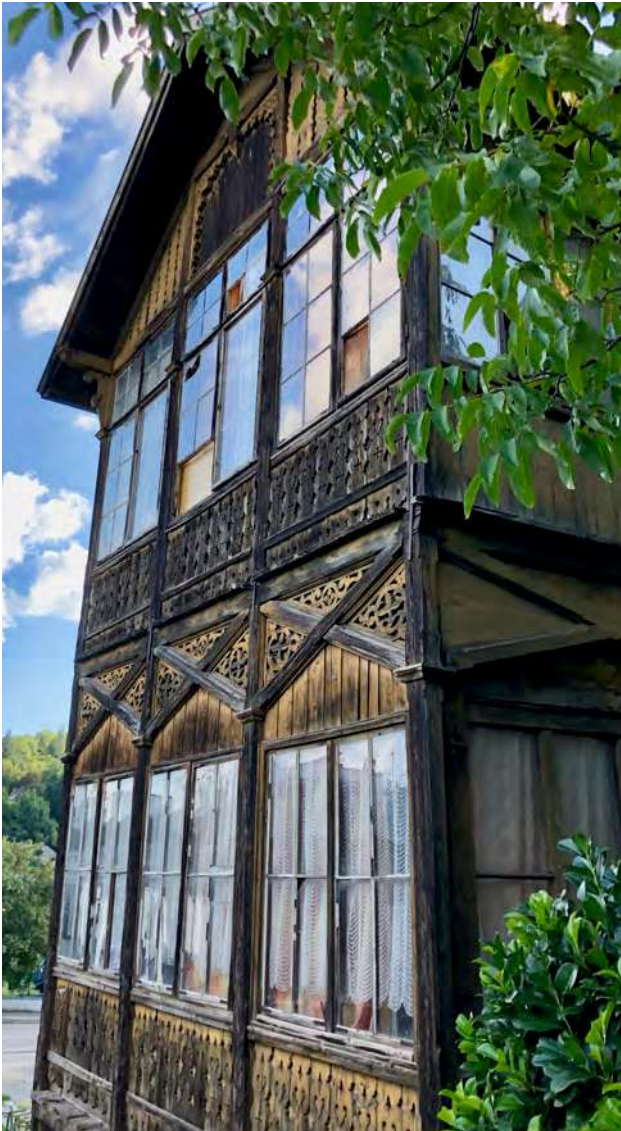
Abb. 392: Tullnerbach-Lawies, Hauptstraße 44, Ostansicht, Veranda
