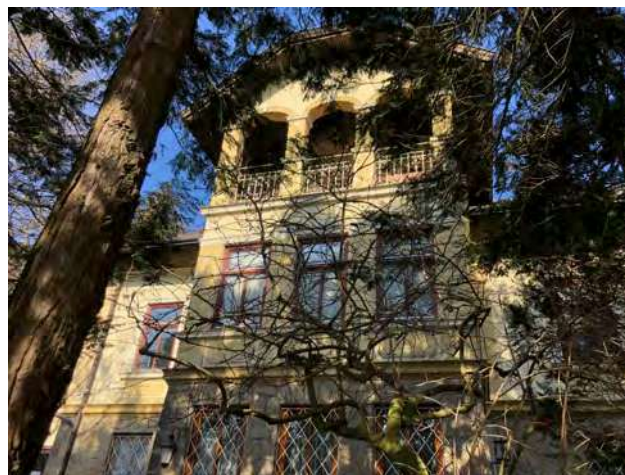
Abb. 395: Tullnerbach-Lawies, Hauptstraße 56, Südansicht
