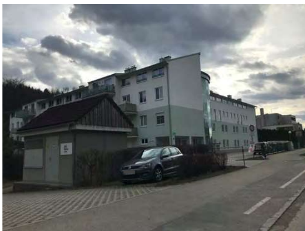
Abb. 178: Tullnerbach-Lawies, Hauptstraße 3, Wohnbau
