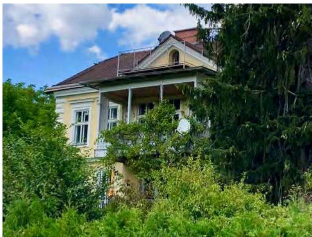
Abb. 239: Tullnerbach-Lawies, Egererstraße 40, Südansicht
