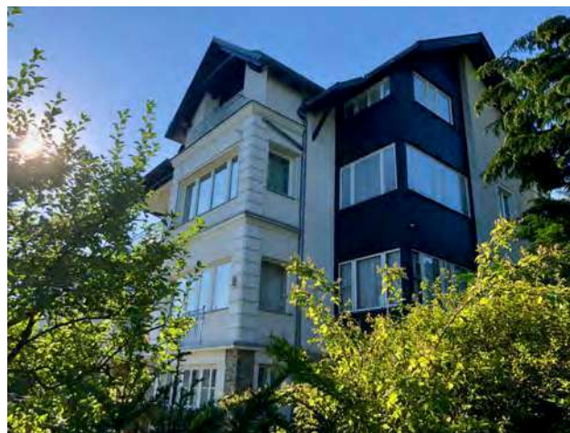
Abb. 267: Tullnerbach-Lawies, Franz-Schubert-Straße 7, Süd-/Ostansicht
