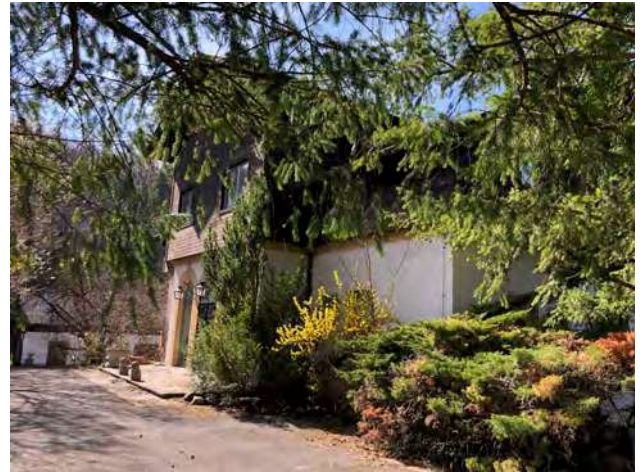
Abb. 160: Reichenau, Villa Hebra, Eingang
