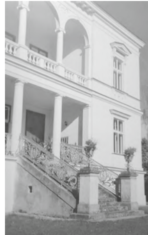
Abb. 365: Tullnerbach-Lawies, Lawieserstraße 19, Südansicht mit Freitreppe
