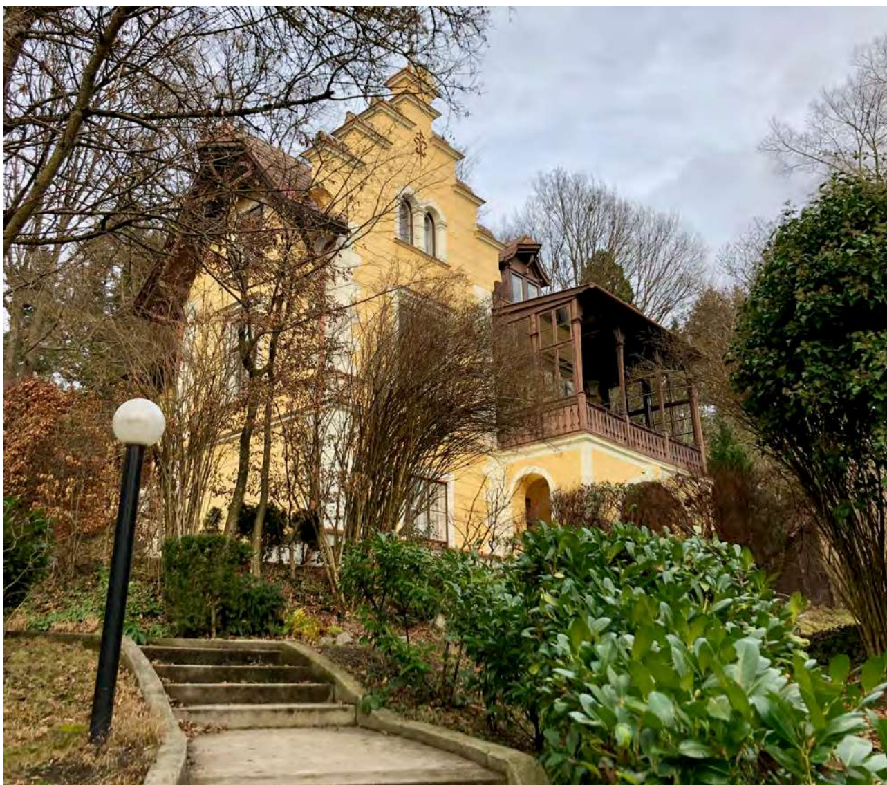
Abb. 315: Tullnerbach-Lawies, Genéestraße 2/4, Süd-/Westansicht
