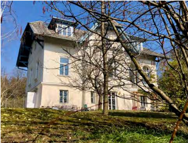
Abb. 310: Tullnerbach-Lawies, Franz-Schubert-Straße 20, Süd-/Westansicht
