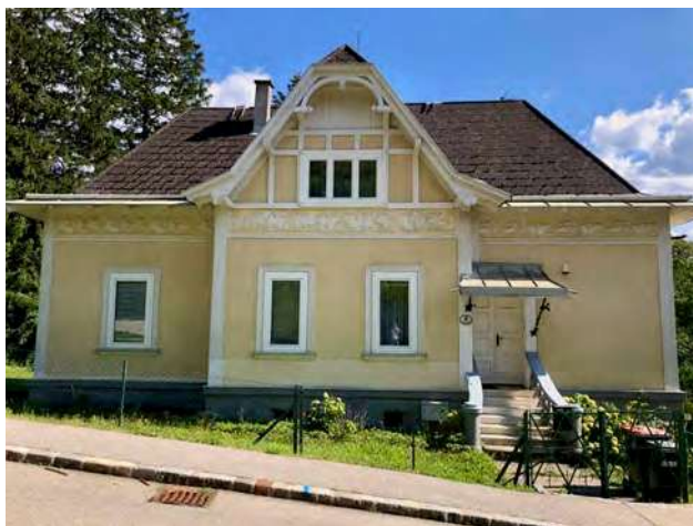
Abb. 334: Tullnerbach-Lawies, Genéestraße 8, Nordansicht
