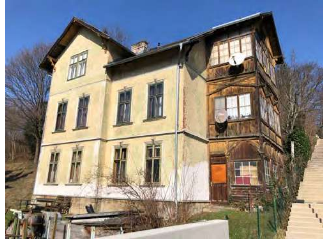
Abb. 391: Tullnerbach-Lawies, Hauptstraße 44, Süd-/Ostansicht
