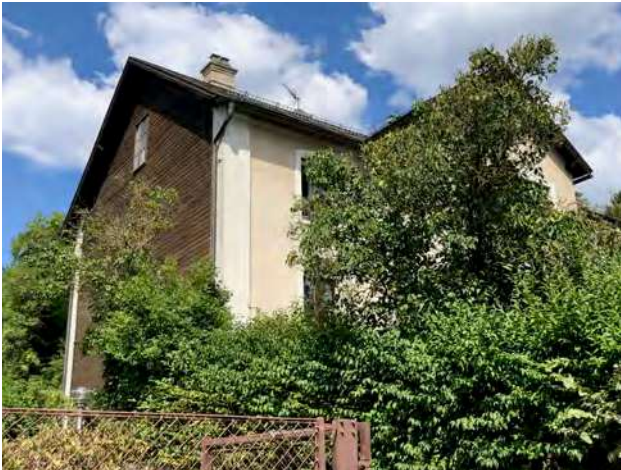
Abb. 226: Tullnerbach-Lawies, Egererstraße 32, Süd-/Westansicht
