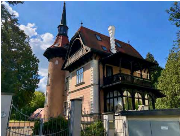
Abb. 34: Tullnerbach-Lawies, Genéestraße 9, Turmvilla, Asymmetrisch mit Veranda, Süd-/Ostansicht
