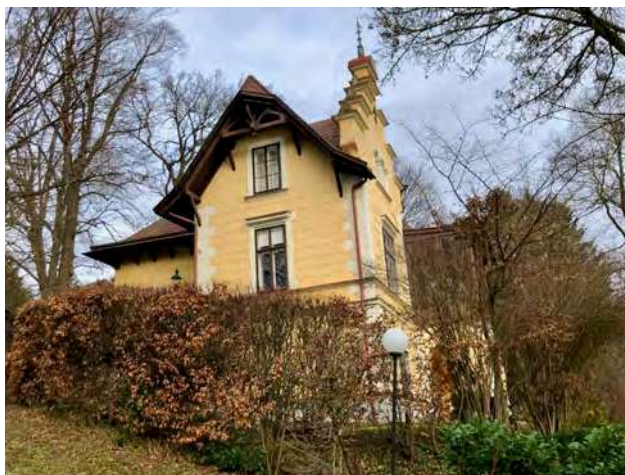
Abb. 313: Tullnerbach-Lawies, Genéestraße 2/4, Westansicht
