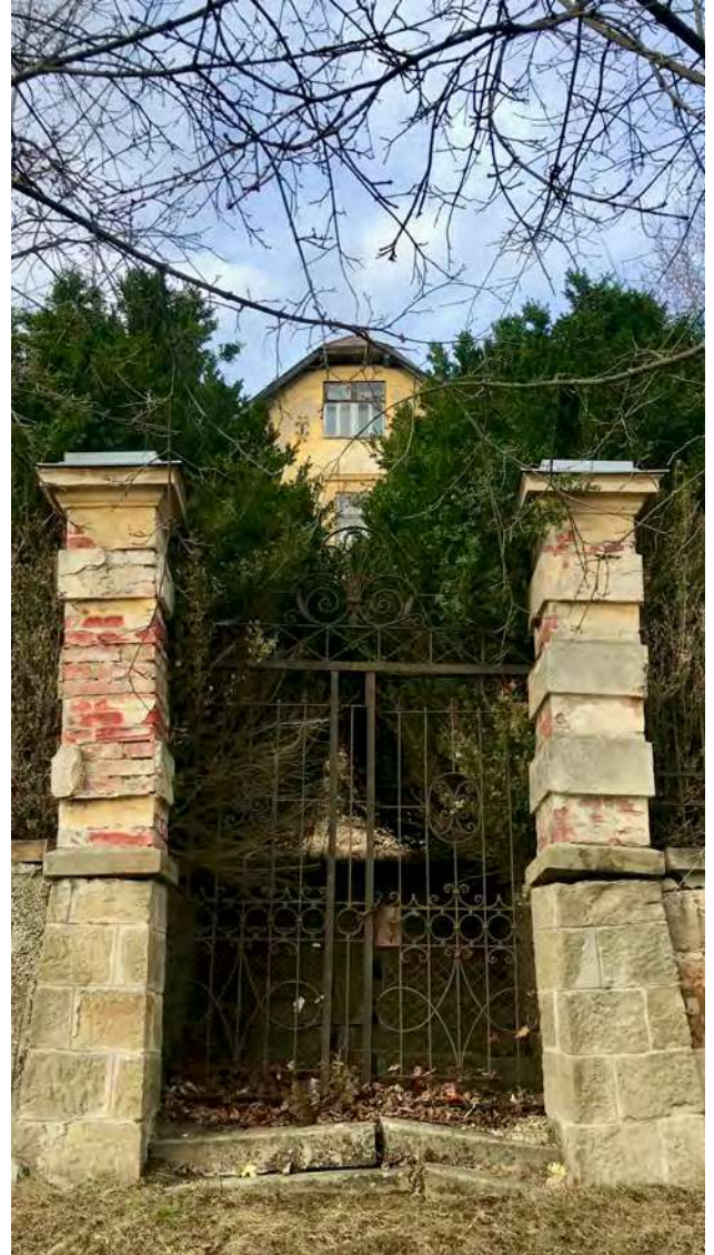
Abb. 207: Tullnerbach-Lawies, Egererstraße 20, Eingangstor
