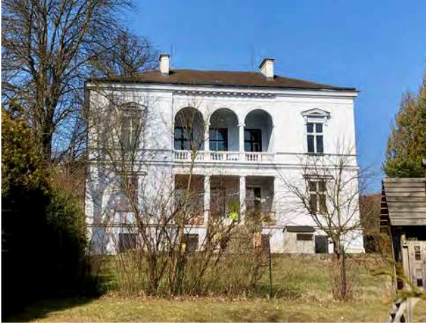
Abb. 362: Tullnerbach-Lawies, Lawieserstraße 19, Südansicht
