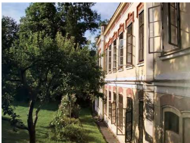
Abb. 144: Reichenau, Rudolfsvilla, Gartenfassade
