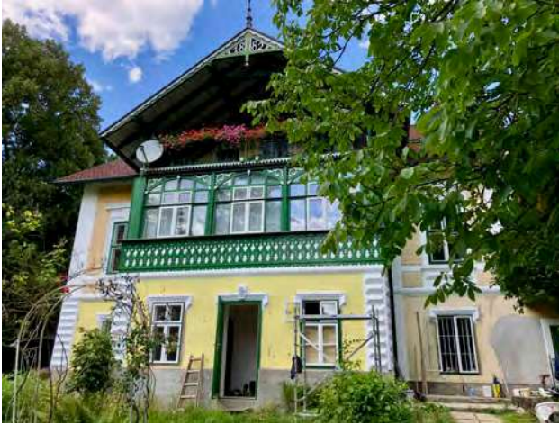
Abb. 242: Tullnerbach-Lawies, Egererstraße 42, Südansicht
