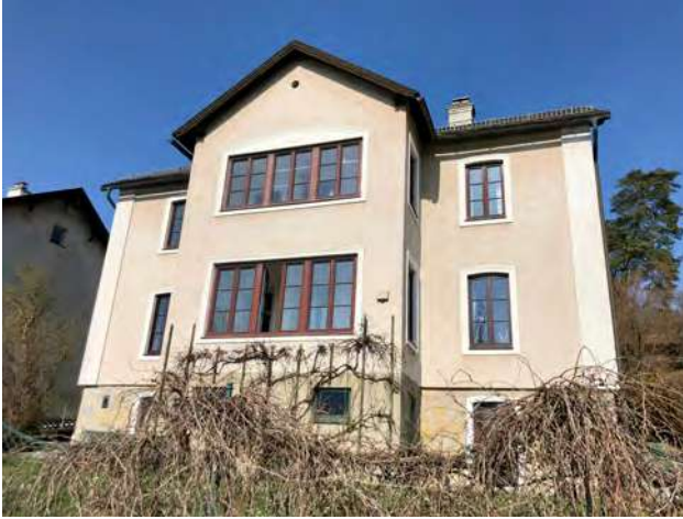
Abb. 224: Tullnerbach-Lawies, Egererstraße 32, Südansicht
