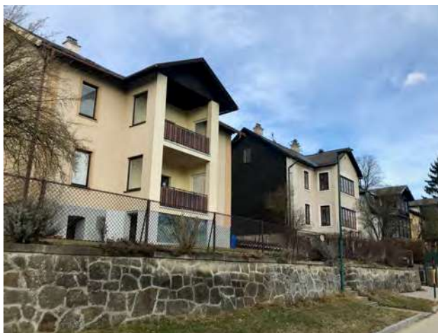
Abb. 230: Tullnerbach-Lawies, Egererstraße 34, Südansicht
