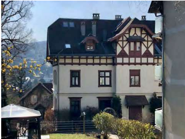
Abb. 408: Tullnerbach-Lawies, Knabstraße 5, Nordansicht
