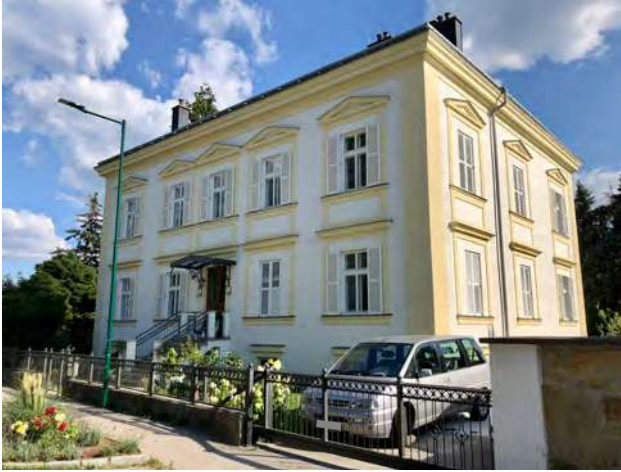
Abb. 435: Tullnerbach-Lawies, Weidlingbachstraße 15, Nord-/Ostansicht
