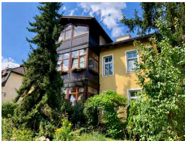
Abb. 218: Tullnerbach-Lawies, Egererstraße 28, Südansicht
