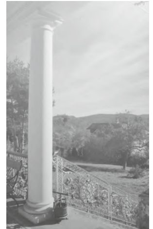
Abb. 366: Tullnerbach-Lawies, Lawieserstraße 19, Veranda mit Abgang in den Garten
