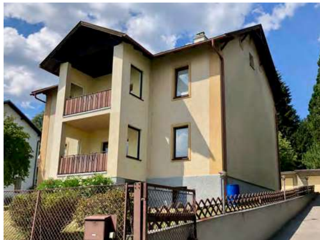
Abb. 96: Tullnerbach-Lawies, Egererstraße 34, erste Villa der oberen Lawies, Süd-/Ostansicht
