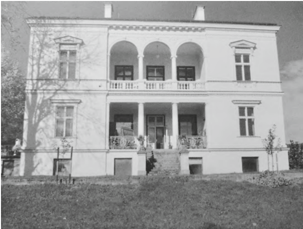
Abb. 364: Tullnerbach-Lawies, Lawieserstraße 19, Südansicht
