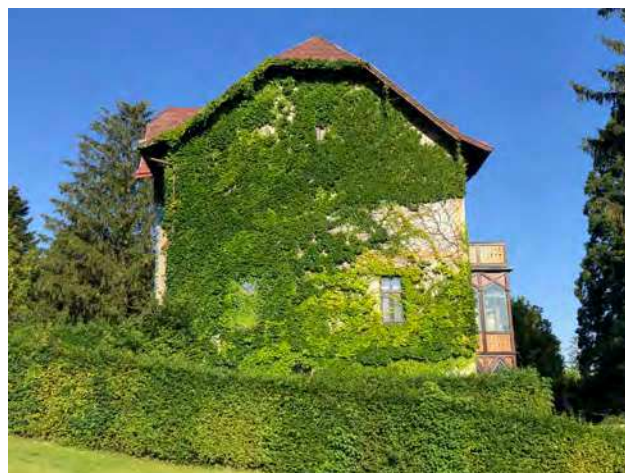
Abb. 119: Tullnerbach-Lawies, Franz-Schubert-Straße 19, Villa Elfi, Westansicht
