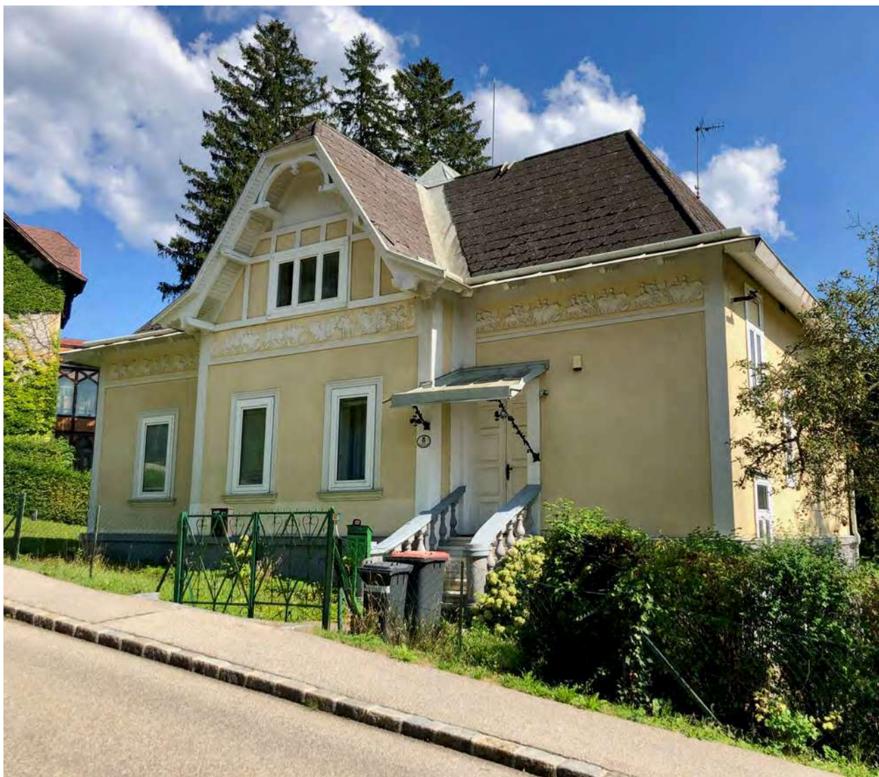
Abb. 336: Tullnerbach-Lawies, Genéestraße 8, Nord-/Westansicht
