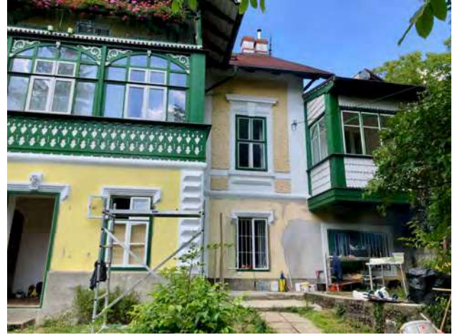
Abb. 243: Tullnerbach-Lawies, Egererstraße 42, Südansicht Zubau
