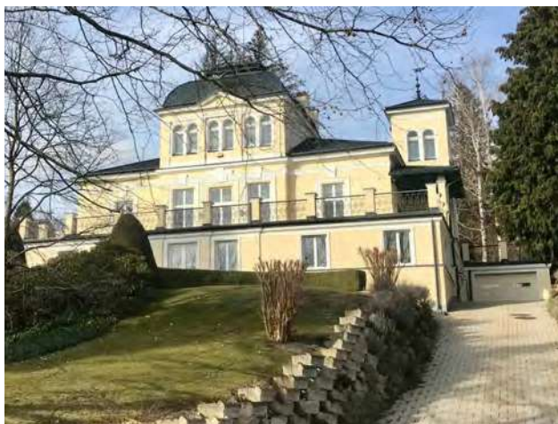
Abb. 202: Tullnerbach-Lawies, Egererstraße 18, Südansicht
