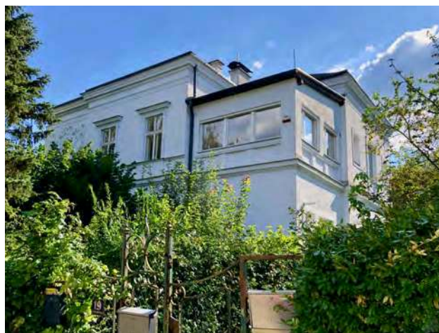
Abb. 113: Tullnerbach-Lawies, Lawieserstraße 19, Villa Schiff, Nord-/Ostansicht
