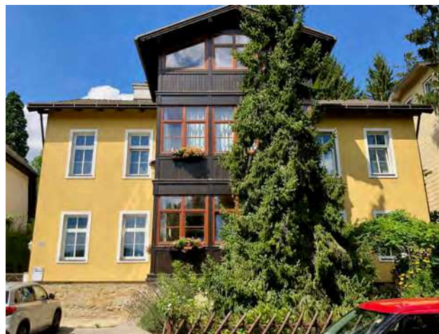
Abb. 219: Tullnerbach-Lawies, Egererstraße 28, Südansicht
