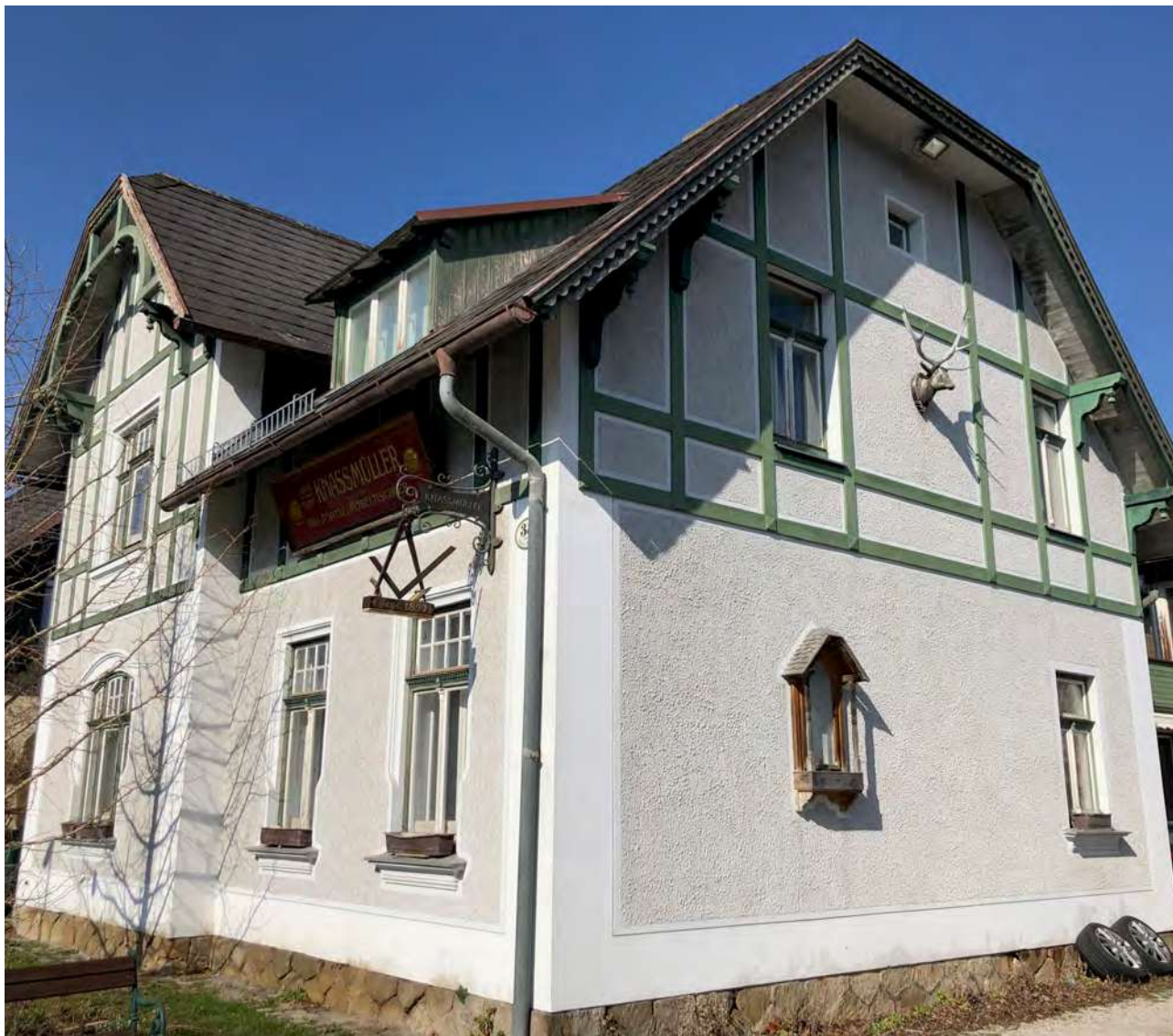
Abb. 386: Tullnerbach-Lawies, Hauptstraße 38, Süd-/Ostansicht
