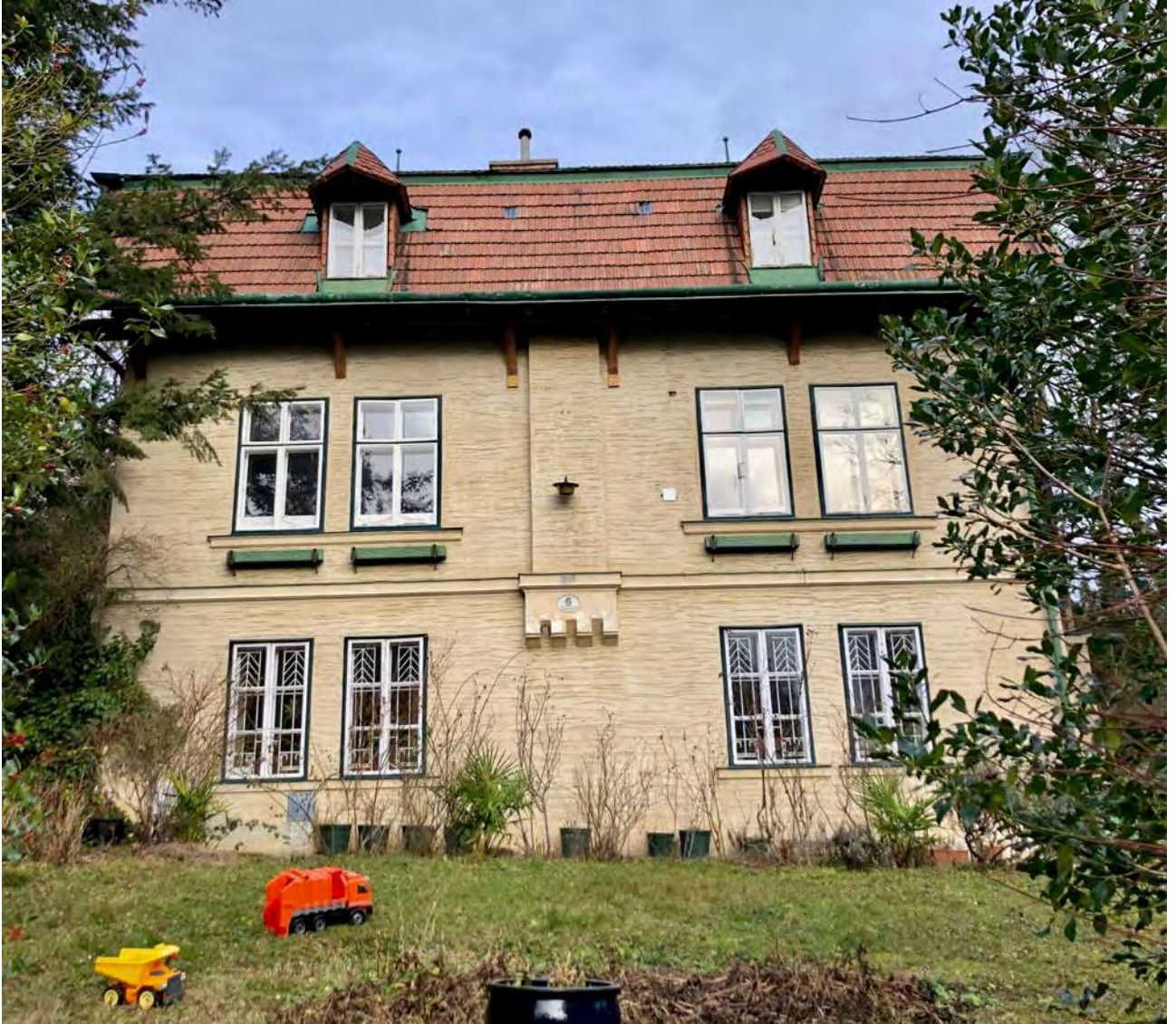
Abb. 328: Tullnerbach-Lawies, Genéestraße 6, Westansicht
