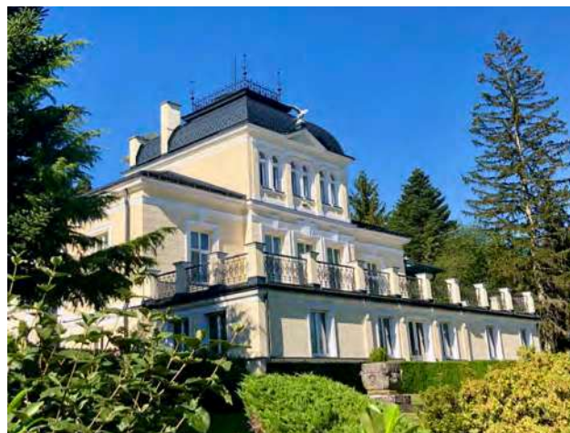
Abb. 203: Tullnerbach-Lawies, Egererstraße 18, Südansicht
