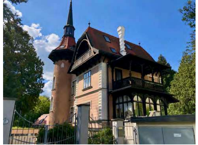
Abb. 338: Tullnerbach-Lawies, Genéestraße 9, Süd-/Ostansicht
