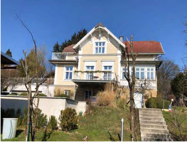
Abb. 356: Tullnerbach-Lawies, Carl-Söldner-Strasse 8, Südansicht
