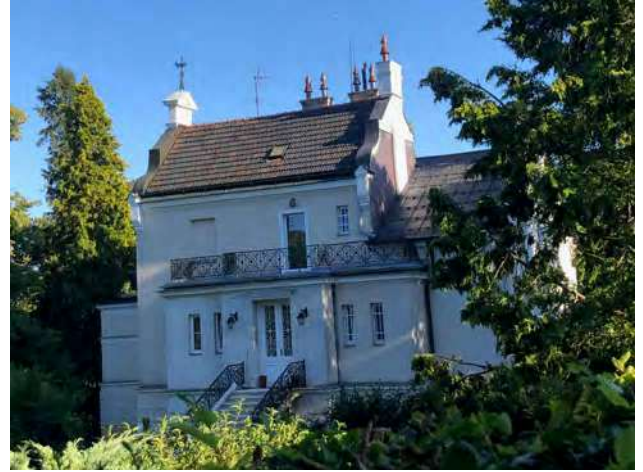
Abb. 377: Tullnerbach-Lawies, Lawieserstraße 39, Nordansicht
