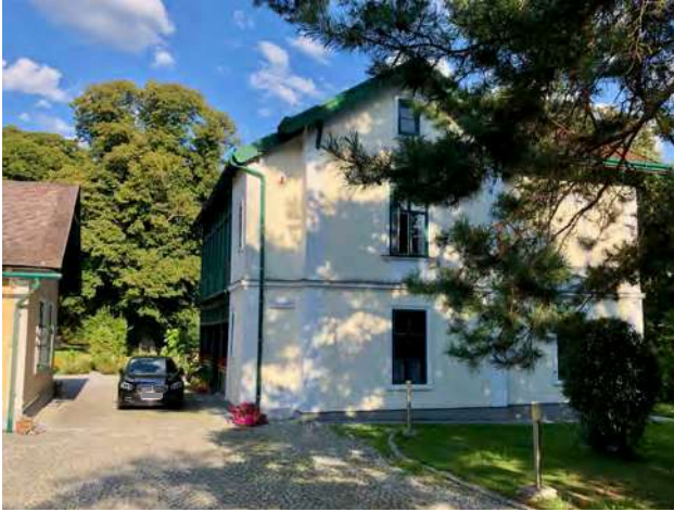
Abb. 424: Tullnerbach-Lawies, Lawieserstraße 4, Westansicht
