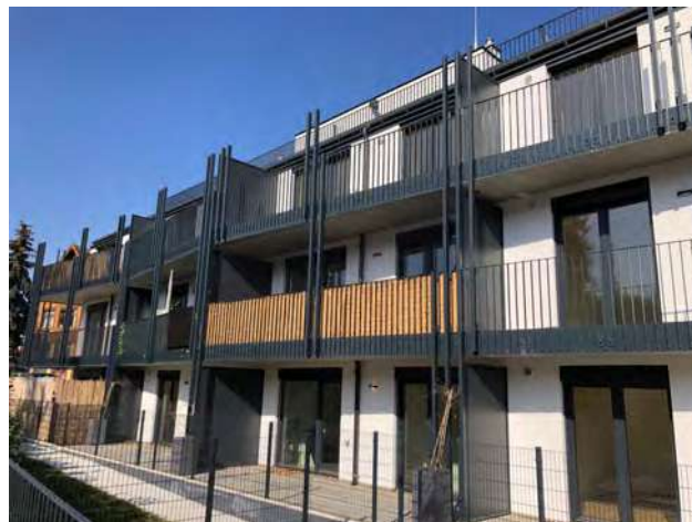
Abb. 177: Tullnerbach-Lawies, Hauptstraße 42, Wohnbau
