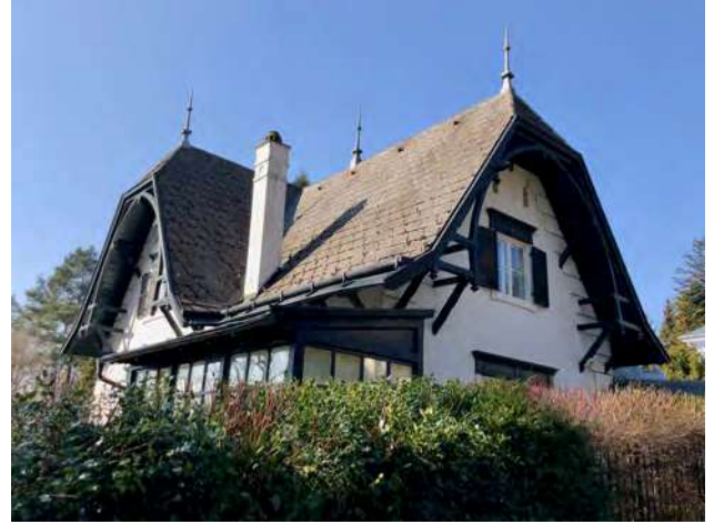
Abb. 317: Tullnerbach-Lawies, Genéestraße 3, Süd-/Ostansicht
