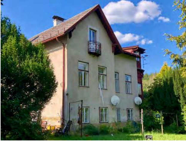
Abb. 188: Tullnerbach-Lawies, Egererstraße 2, Südansicht
