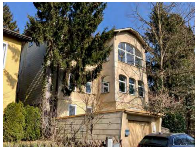
Abb. 215: Tullnerbach-Lawies, Egererstraße 26, Süd-/Westansicht
