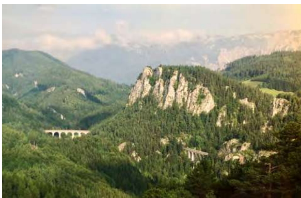
Abb. 40: Semmeringbahn, „Kalte Rinne“ (links) und „Krauselklause“ (rechts), dazwischen Pollerostunnel, „Zwanzig-Schilling-Blick“
