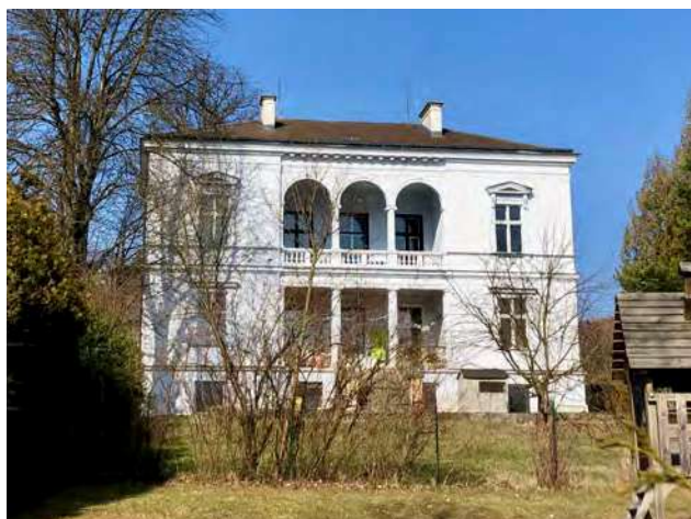
Abb. 112: Tullnerbach-Lawies, Lawieserstraße 19, Villa Schiff, Südansicht
