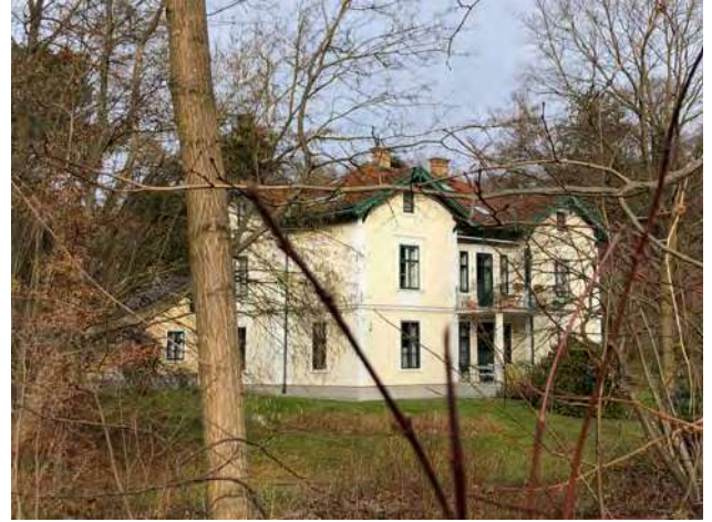
Abb. 425: Tullnerbach-Lawies, Lawieserstraße 4, Südansicht
