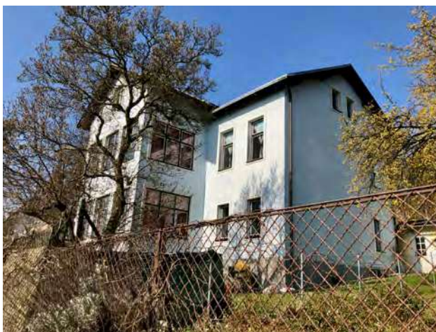
Abb. 234: Tullnerbach-Lawies, Egererstraße 36, Süd-Ostansicht
