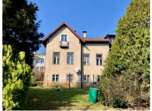
Abb. 189: Tullnerbach-Lawies, Egererstraße 2, Südansicht
