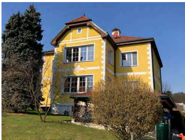
Abb. 370: Tullnerbach-Lawies, Lawieserstraße 28, Südansicht
