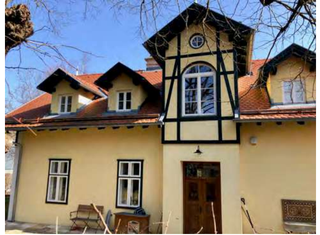
Abb. 374: Tullnerbach-Lawies, Lawieserstraße 37a, Westansicht
