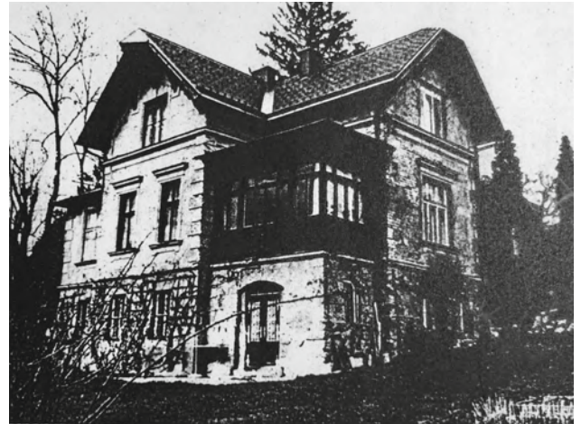
Abb. 359: Tullnerbach-Lawies, Carl-Söldner-Strasse 8, Historische Aufnahme, Süd-/Ostansicht
