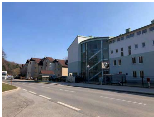
Abb. 179: Tullnerbach-Lawies, Hauptstraße 1 und 3, Wohnbauten
