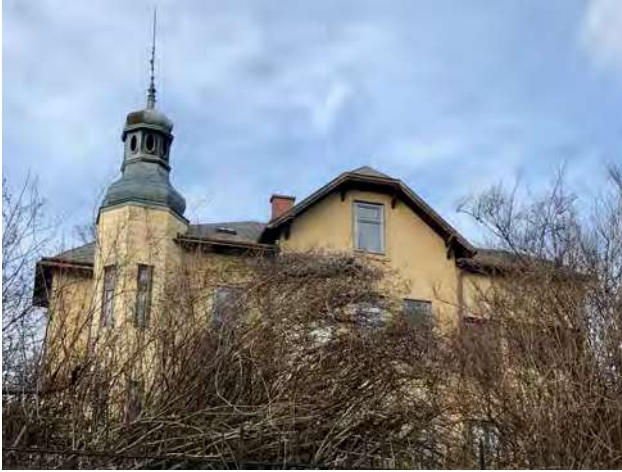
Abb. 205: Tullnerbach-Lawies, Egererstraße 20, Südansicht
