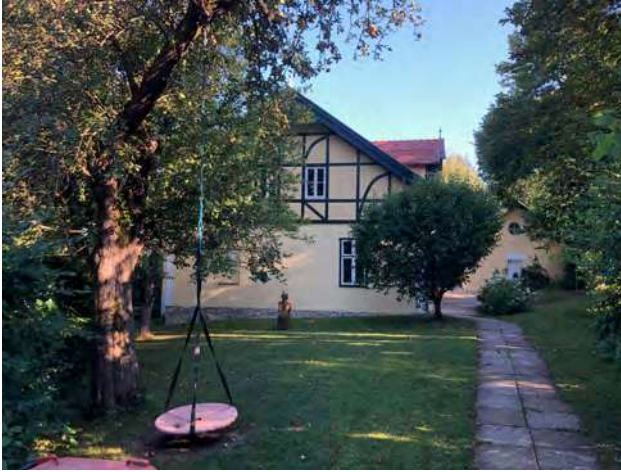
Abb. 373: Tullnerbach-Lawies, Lawieserstraße 37a, Nordansicht
