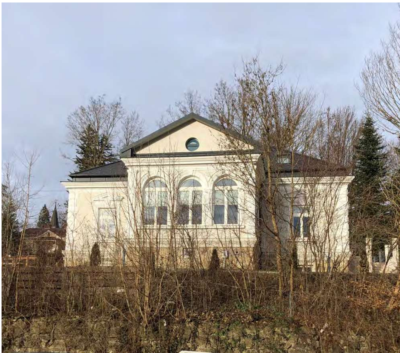
Abb. 414: Tullnerbach-Lawies, Knabstraße 6, Südansicht
