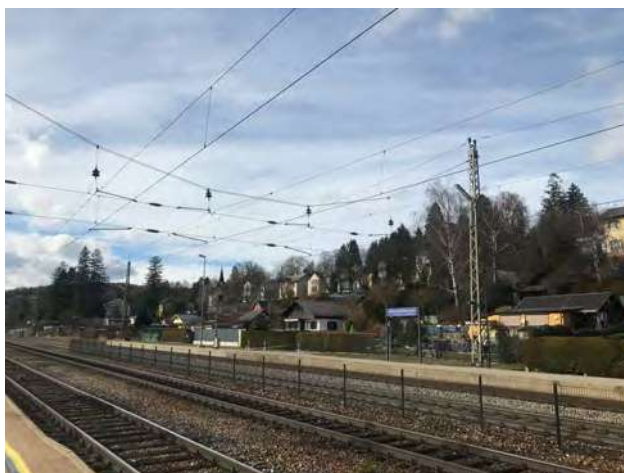
Abb. 65: Tullnerbach-Lawies, Bahnstrecke, Blick auf die obere Lawies
