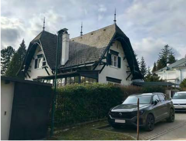
Abb. 316: Tullnerbach-Lawies, Genéestraße 3, Süd-/Ostansicht
