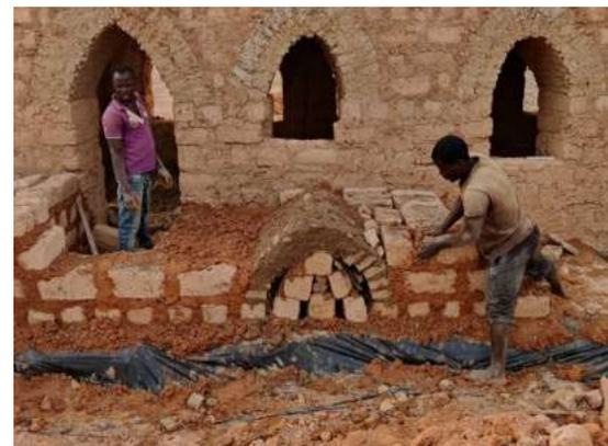
Ziegeln begonnen. Diese wurde jedoch nicht abgeschlossen, sondern in den Mauerwerksverband der Teppe integriert. Aufgrund der Länge dieses Rundbogens wurde sich bei der Errichtung zusätzlich eines runden Metallfasses bedient, dass auf lose gestapelte Ziegel positioniert und ebenfalls mit einer Kunststoffolie als Trennschicht bedeckt wurde. Nachdem den Arbeitern ein Anreiz in Form einer kleinen Prämie in Aussicht gestellt wor-
