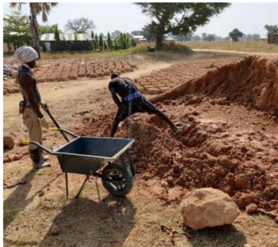
zu Beginn dieser Bauphase von zwei Arbeitskräften mit Wasser vermengt und zu einem Lehmörtel vermischt. Dieser Arbeitsschritt wurde fortlaufend sowie parallel zu den Mauerarbeiten durchgeführt.
