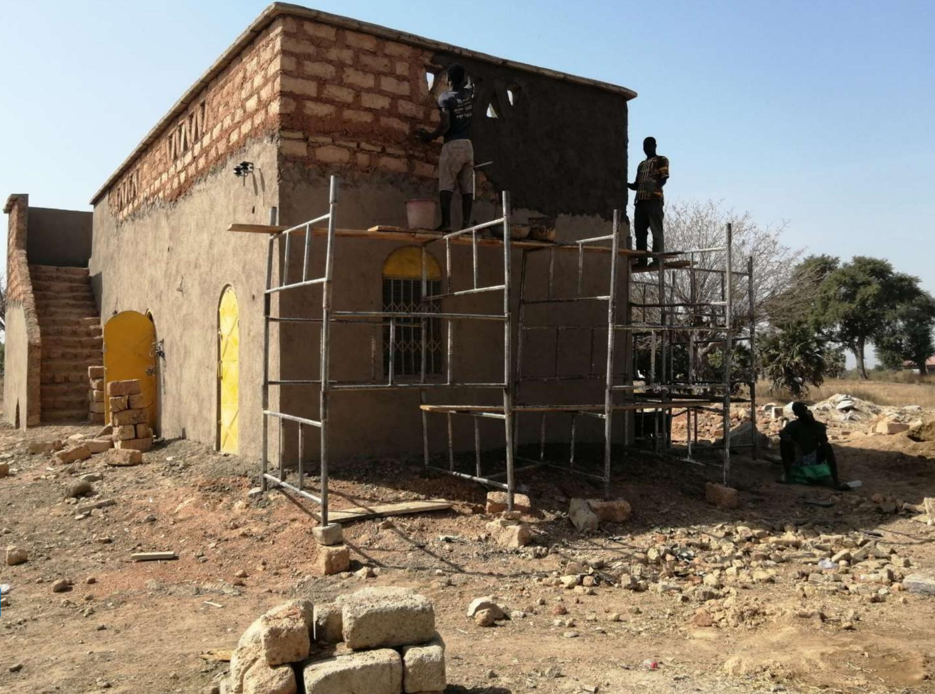
richtungsarbeiten verwendet wurde. Auf das Gerüst wurden wieder die Sperrholzbretter als Auflage verwendet, um das letzte obere Drittel der Außenmauern verputzen zu können. Nach insgesamt acht Arbeitstagen war die gesamte Außenhülle des Gebäudes vollständig verputzt.
