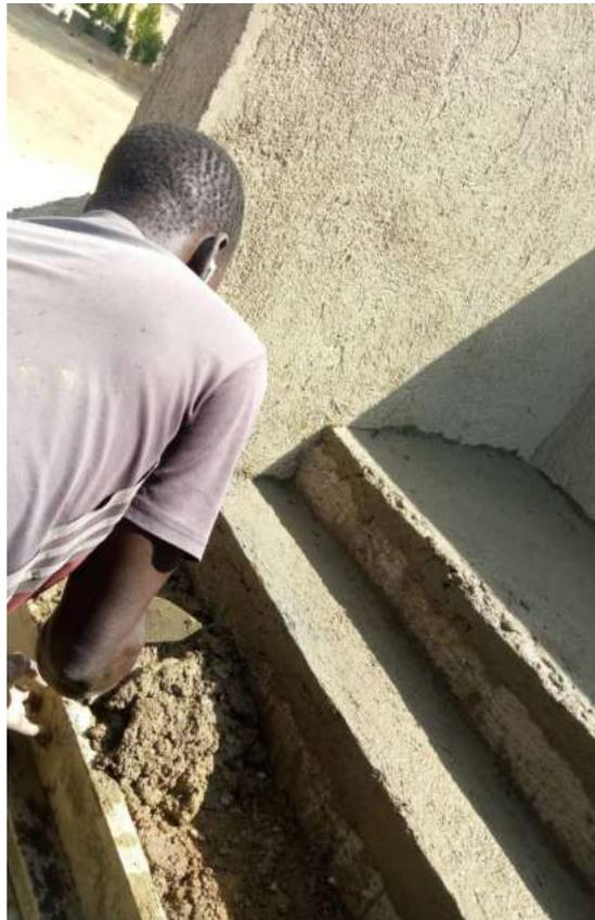
mit vom Gebäude weggerichtet sind. Dies war eine weitere Vorsichtsmaßnahme, damit die, von den Wasserspeiern vom Gebäude weggeleiteten, Wassermassen weder den Randstreifen noch die Fundamente in irgendeiner Weise ausspülen können. Um die Hydratation, also die chemische Bindung des Wassers mit dem Zement, aufrecht zu erhalten<sup>119</sup>, wurden die Treppenstufen und der Randstreifen die folgenden drei Tage weiterhin gewässert.
