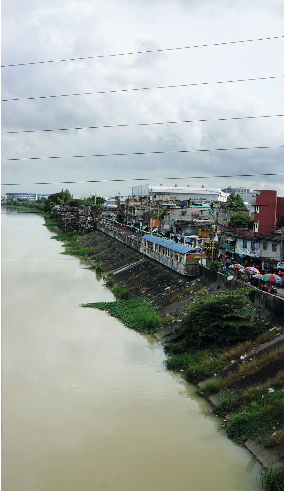
Abb. 31| Hang nach Abriss der informellen Häuser
