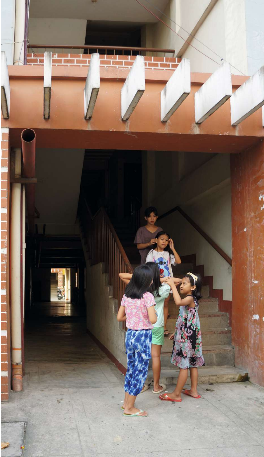
Abb. 29 | Gang im Erdgeschoss
