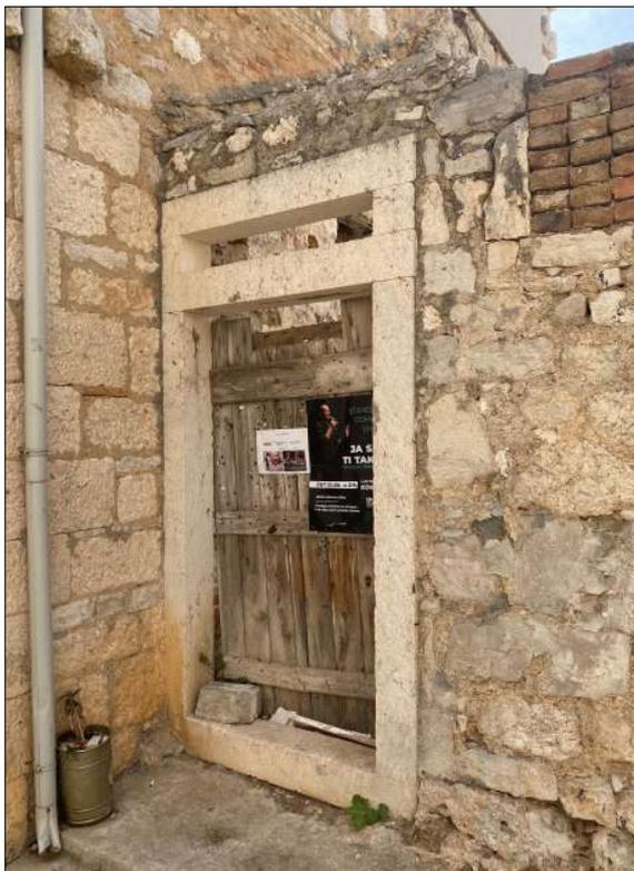
Abb. 85. Insel Vis, Komiža, geschnitzte Steinrahmen mit rechteckigen Oberbogen
