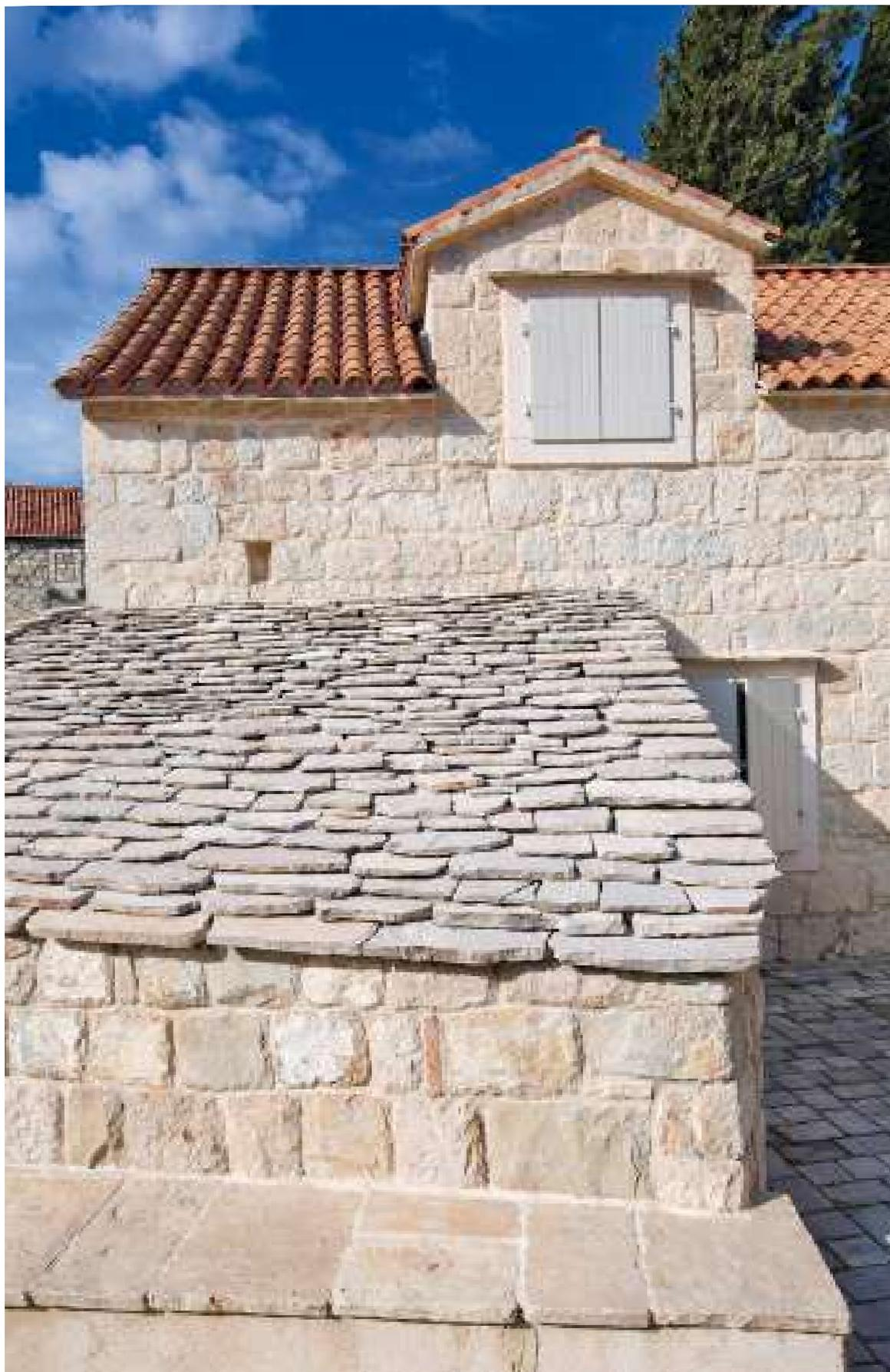
Abb. 104. Stadt Split, Varoš, verputzte und neu verfugte Stein am alten Haus, das in seiner ursprünglichen Form aus dem 19. Jahrhundert erhalten ist
