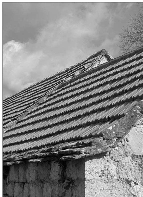
Abb. 77. Das Dorf Dugobabe, Rettung des Daches durch auf Steinplatten gelegte Ziegel
