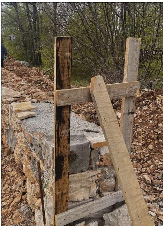
Abb. 15. Der Trockenbau, Konjsko, Platzierung von Nivellierbalken
