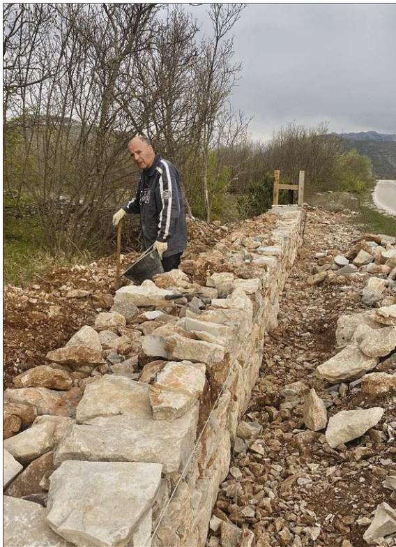
Abb. 13. Der Trockenbau, Konjsko, Abgrenzung der Grenze des Trockenbaus
