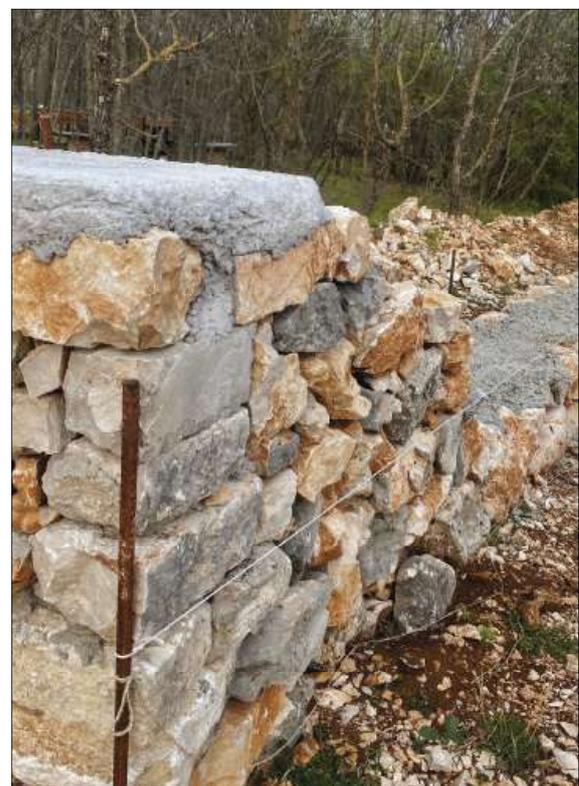
Abb. 16. Der Trockenbau, Konjsko, Entfremdung vom traditionellen Bauen - Betonverstärkung
