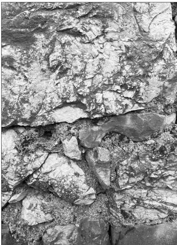
Abb. 41. Das alte Dorf Jesenice, mit Kalkmörtel verfugte Steinmauer, grobe Struktur, aber hohler als der Stein selbst
