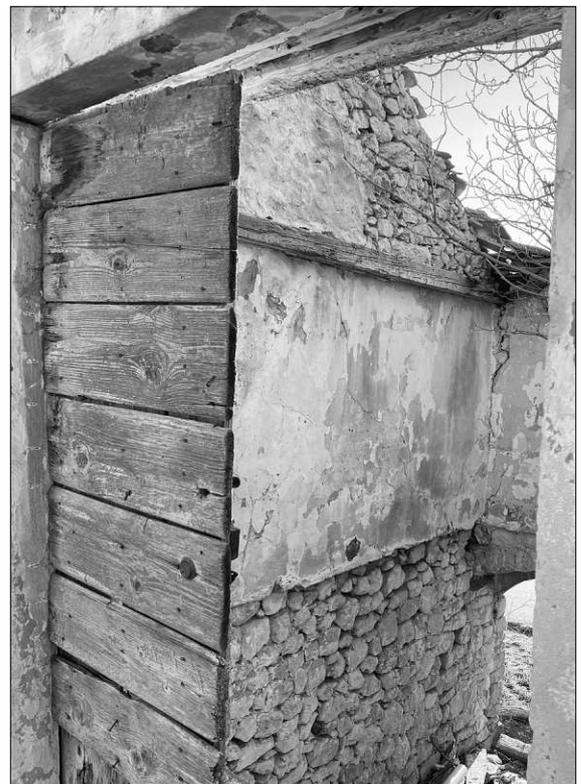
Abb. 42. Das alte Dorf Podstrana, verputzte Wand des Erdgeschosses als Aufbau der Steinwand des Erdgeschosses
