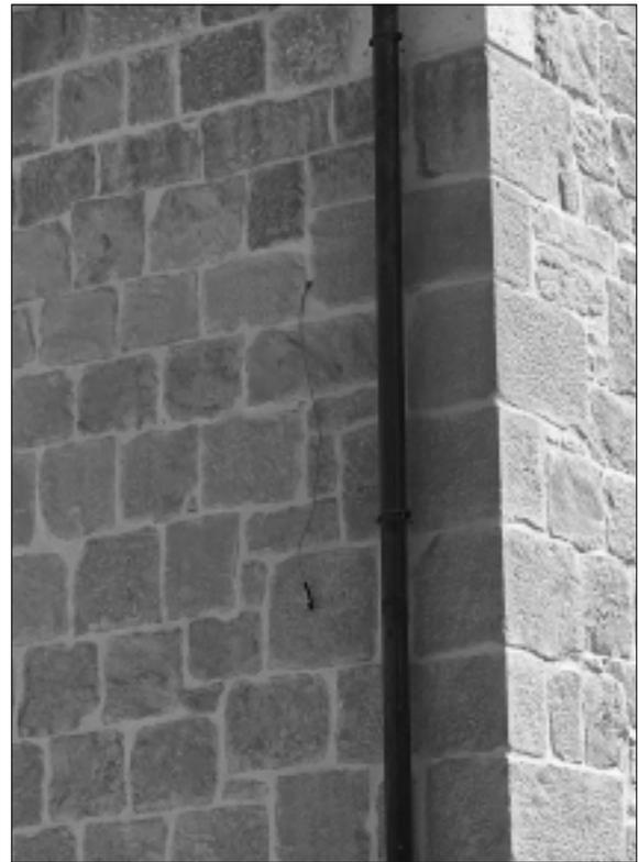
Abb. 40. Solin, Verfugung falsch ausgeführt, mit falscher Breite und Farbe der Fugen
