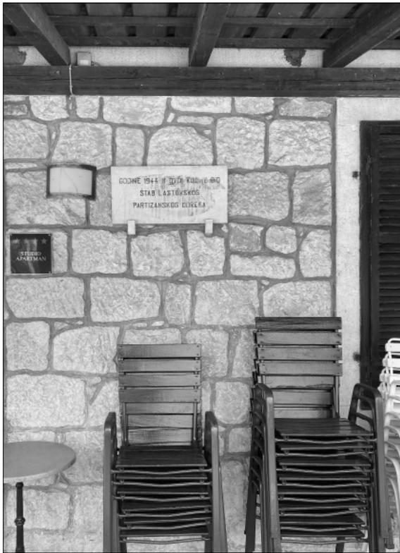
Abb. 39. Insel Lastovo, Stadt Lastovo, unsachgemäße Verwendung von Stein und Fugen
