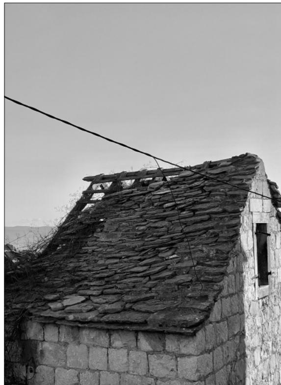
Abb. 75. Das alte Dorf Podstrana, Steinplatten auf dem Satteldach auf Holzbalken verlegt
