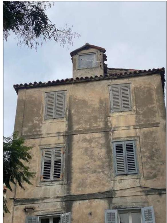
Abb. 79. Stadt Split, Radunica, ein von der Vorderseite des Hauses eingezogenes Fensterlicht, das in der Mitte der Fassade platziert ist
