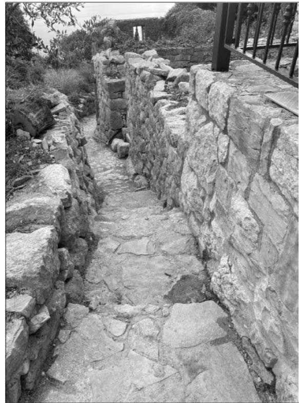
Abb. 10. Das Trockenbau, Das alte Dorf Jesenice, ein Weg in Form von Steinstufen zwischen den Trockenmauern, die die Grundstücke trennen
