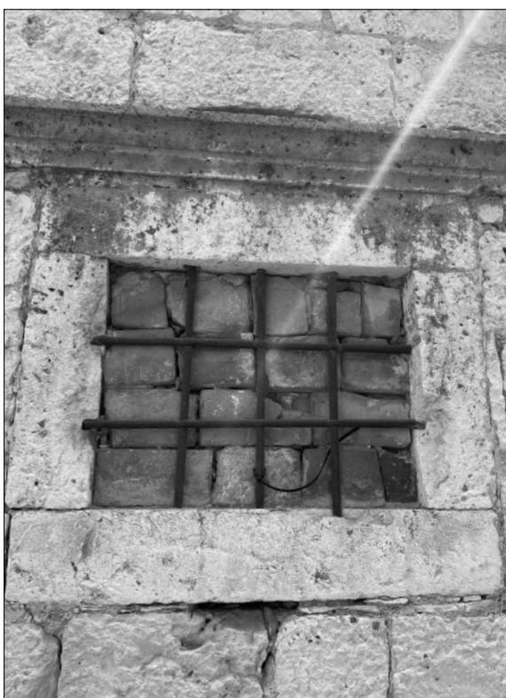
Abb. 87. Insel Vis, Komiža, Fensterrahmen mit Blöcken zugemauert
