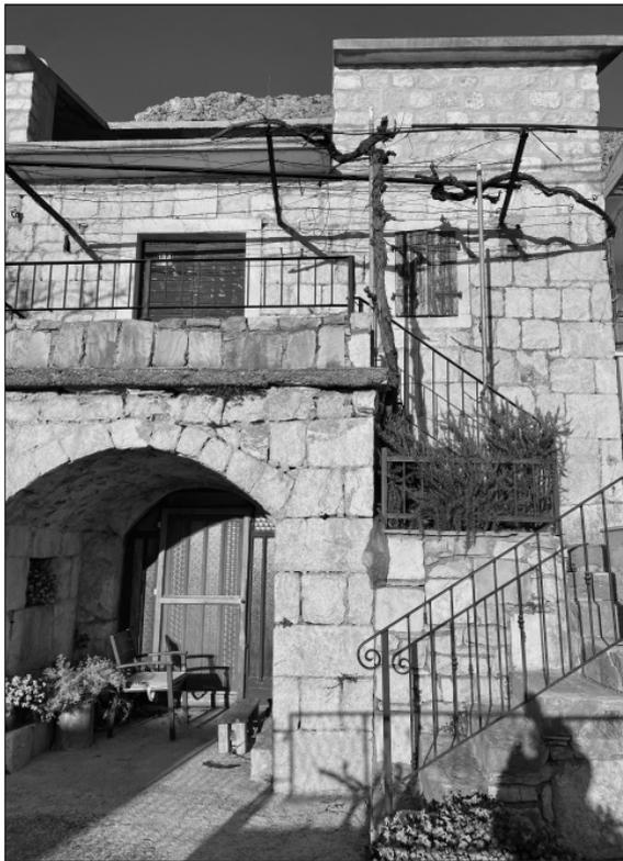
Abb. 66. Das alte Dorf Podstrana, balatura mit einem Sims über der Eingangstür
