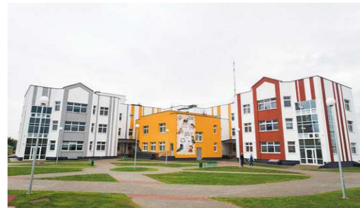
Abb. 21: Beispielfoto. Standardkindergarten im Dorf Ko-lodischtschi, Region Minsk, errichtet um 2020
