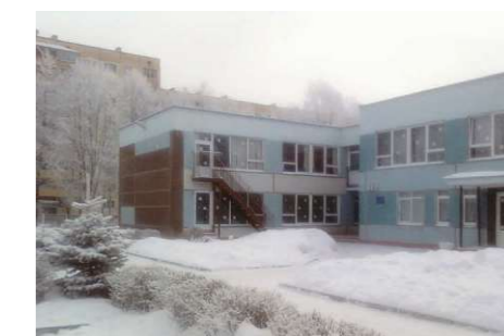
Abb. 19: Beispielfoto. Kindergarten Nr. 365 in Minsk, errichtet um 1977
