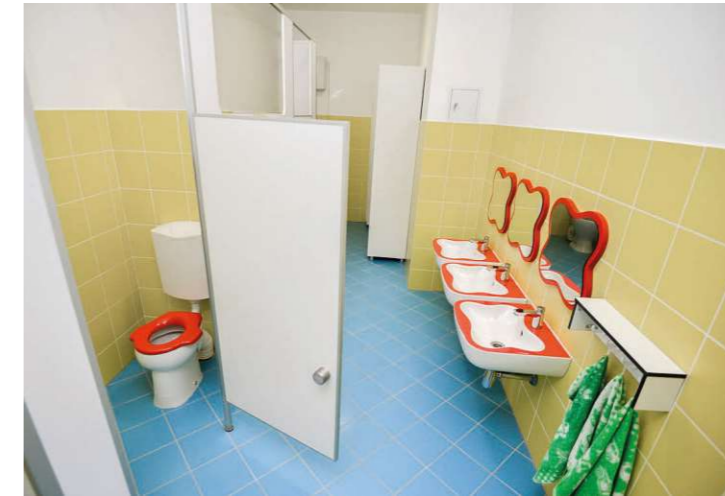
Abb. 37: Beispielfoto. Eine Sanitäranlage im Kindergarten Nr.32 in Minsk
