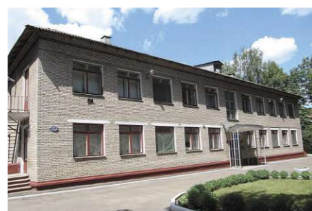
Abb. 16: Beispielfoto. Kindergarten Nr. 121 in Minsk, errichtet um 1960
