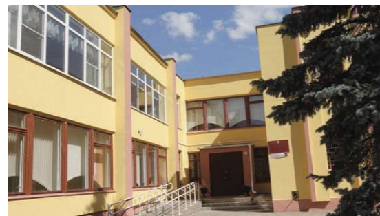
Abb. 31: Beispielfoto. Der Haupteingang in den Kindergarten Nr. 407 in Minsk
