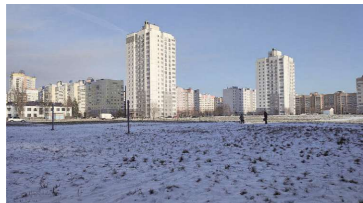
Abb. 50: Blick von der Wiese auf die Wohnhäuser Nr. 24 und Nr. 51
