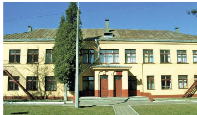
Abb. 14: Beispielfoto. Kindergarten Nr. 85 in Minsk, errichtet um 1951
