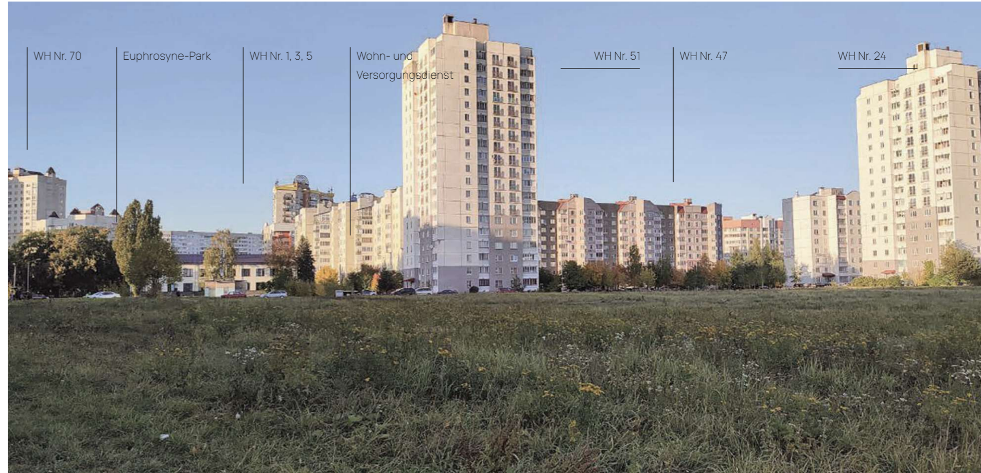
Abb. 56: Blick von der Wiese auf die Wohnhäuser Nr.70, Nr.1,3,5, Nr.51, Nr.47 und Nr.24, sowie auf das Wohn-und Versorgungsdienstgebäude und den Euphrosyne-Park
