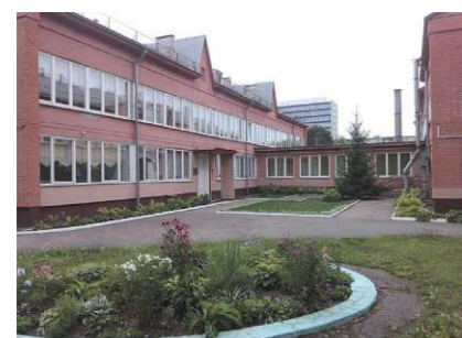
Abb. 15: Beispielfoto. Kindergarten Nr. 231 in Minsk, errichtet um 1965
