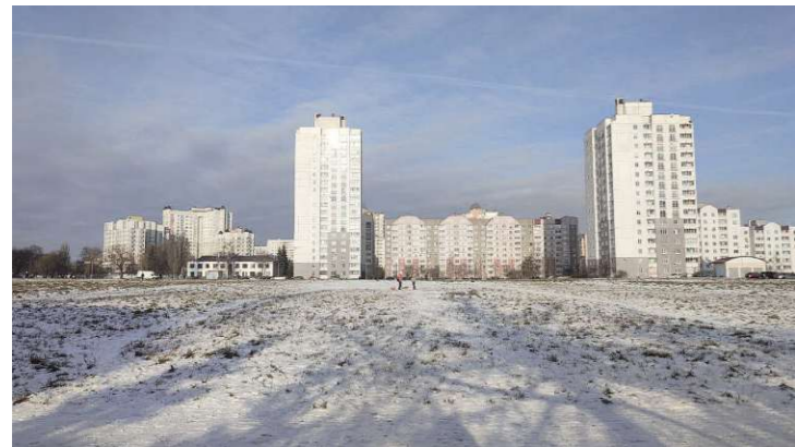
Abb. 54: Blick von der Wiese auf die Wohnhäuser Nr. 24, Nr. 51 und Nr. 47
