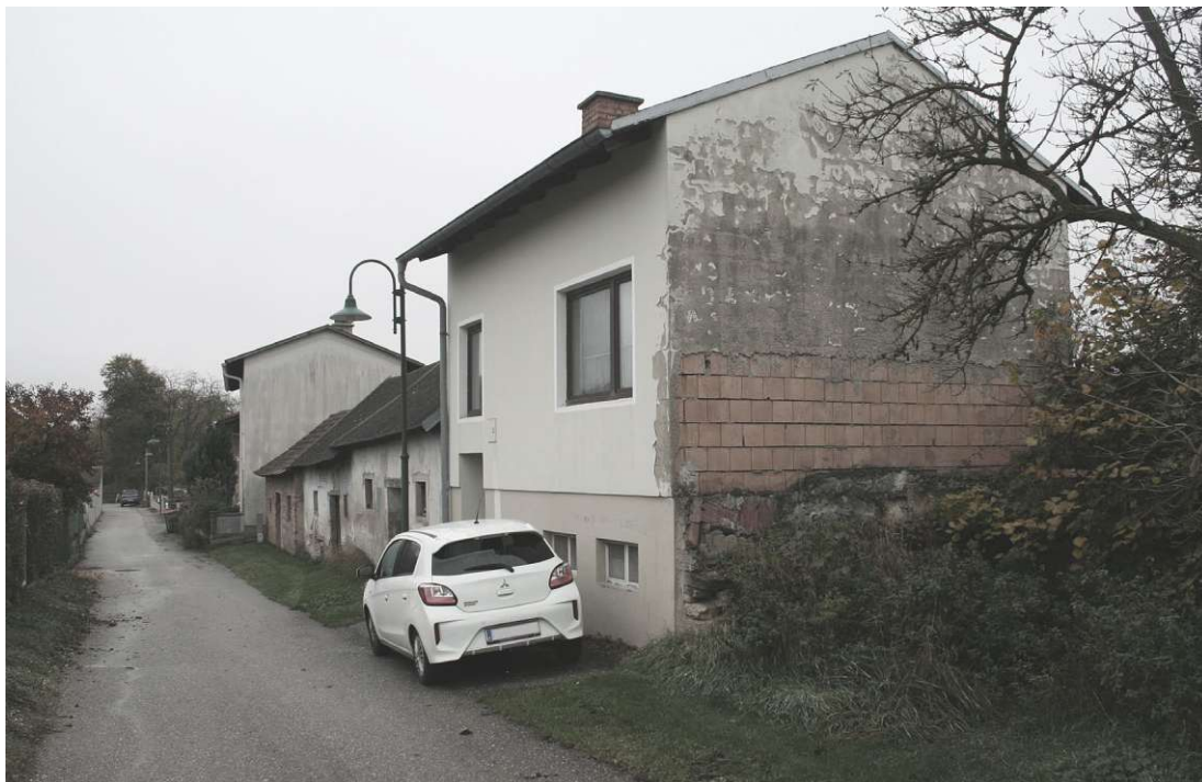
Abb. 15: Umbau eines Kellers zu einem Wohngebäude
