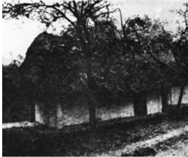
Abb. 57: Objekt 82a in einer Aufnahme aus 1980
