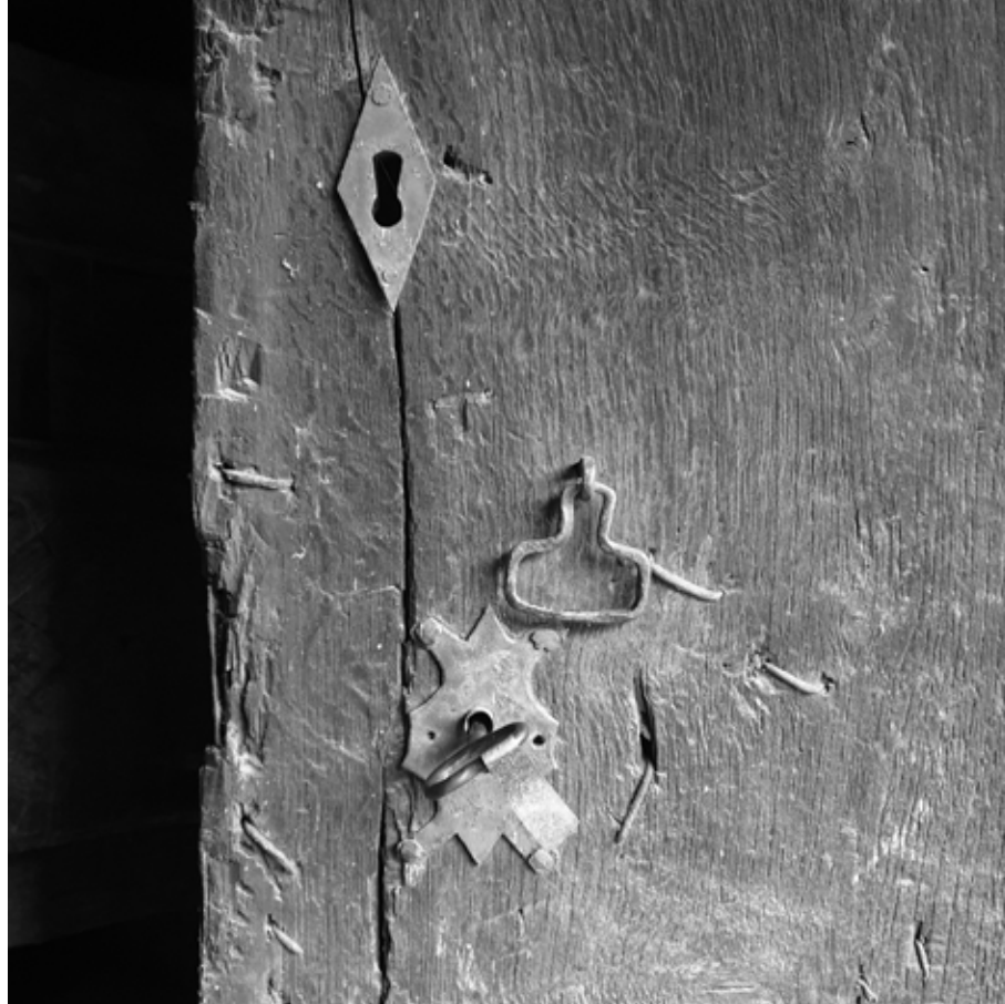
Abb. 161: Schlossbleche an einer Tür am Objekt 32
