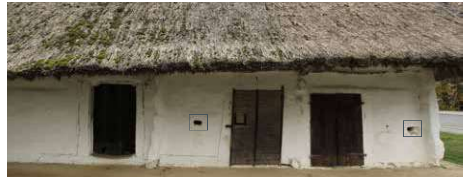
Abb. 145: Am Schaukeller Nummer 79 sind noch zwei Riegellöcher sichtbar, aber keine Fallriegelschlösser mehr. Der linke Raum war der Pressraum, dort wurde nicht gelagert, deshalb gab es dort vermutlich kein Fallriegelschloss
