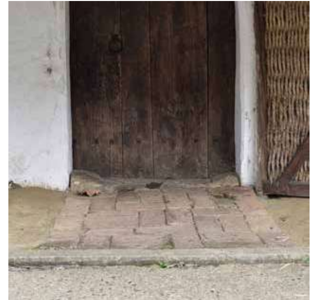
Abb. 127: Der stark genutzte Eingangsbereich wurde mit Ziegeln ausgelegt. Dabei handelt es sich um eine individuelle Sonderlösung
