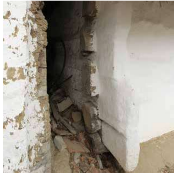
Abb. 117: Unverputzte Balkenköpfe am Objekt 82a
