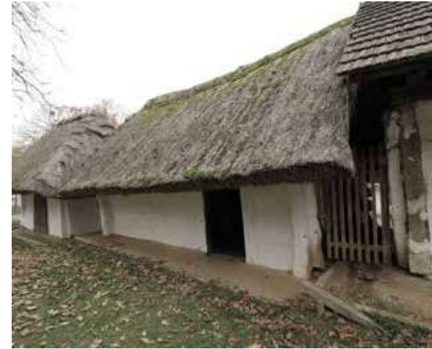
Abb. 58: Objekt 82a in einer Aufnahme aus 2020
