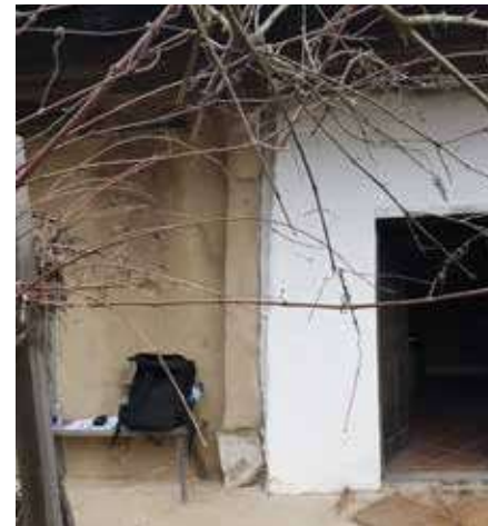
Abb. 121: Der alte Teil des Objektes 32 aus Holzbalken wurde mit einer Fuge an das neuere gemauerte Stüberl samt Unterkellerung angebaut. Verbunden sind die Bauteile vor allem über ein gemeinsames Dach
