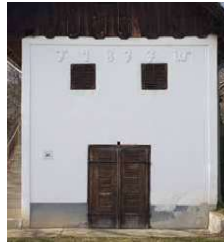
Abb. 143: Für das Kellerstöckel typische Fensteröffnungen in der zweigeschossigen Fassade
