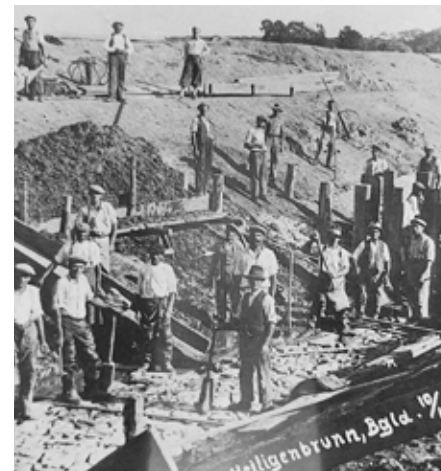
Abb. 7: Arbeiten zur Strembachregulierung 1935 [Six-Hohenbalken, 1998, S.82]
