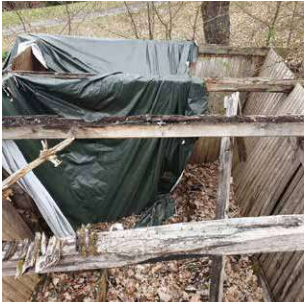
Abb. 94: Blick in den 3. Raum. Reste der Balkendecke und der Holzvertäflung sind noch vorhanden
