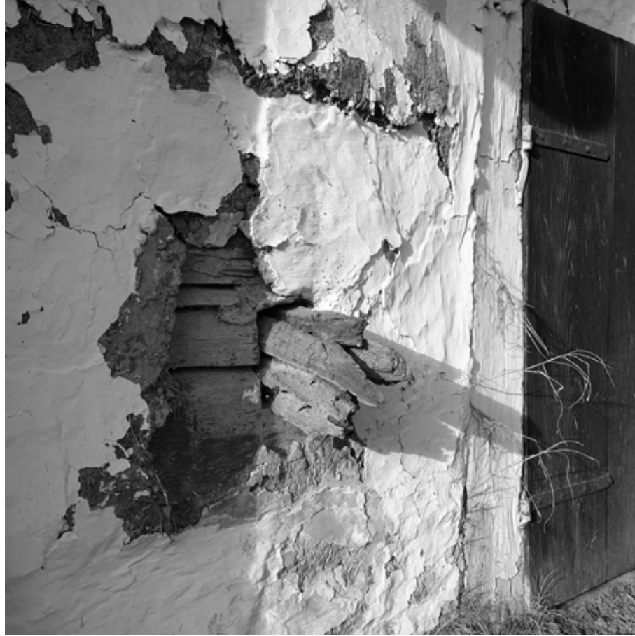
Abb. 113: Detail Objekt 75. Das Riegelloch wurde mit Holzstücken verschlossen
