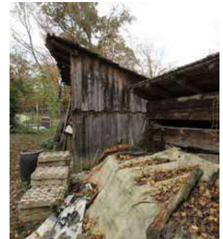
Abb. 40: Schweinestall zum Objekt Nummer 11
