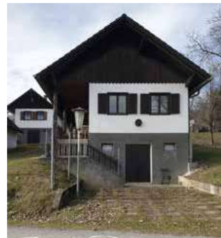
Abb. 144: Nachträglich integrierte, nicht den traditionellen Proportionen entsprechende Fenster
