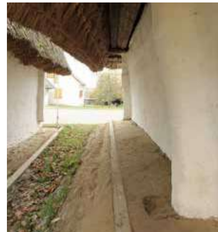
Abb. 60: Lehmgredn mit Abstufung. Das Loch deutet darauf hin, dass der Balken des Schwellenkranses gekürzt wurde
