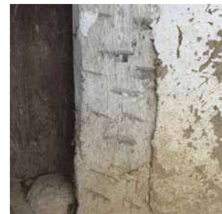
Abb. 123: Einkerbungen einer Axt als Putzträger
