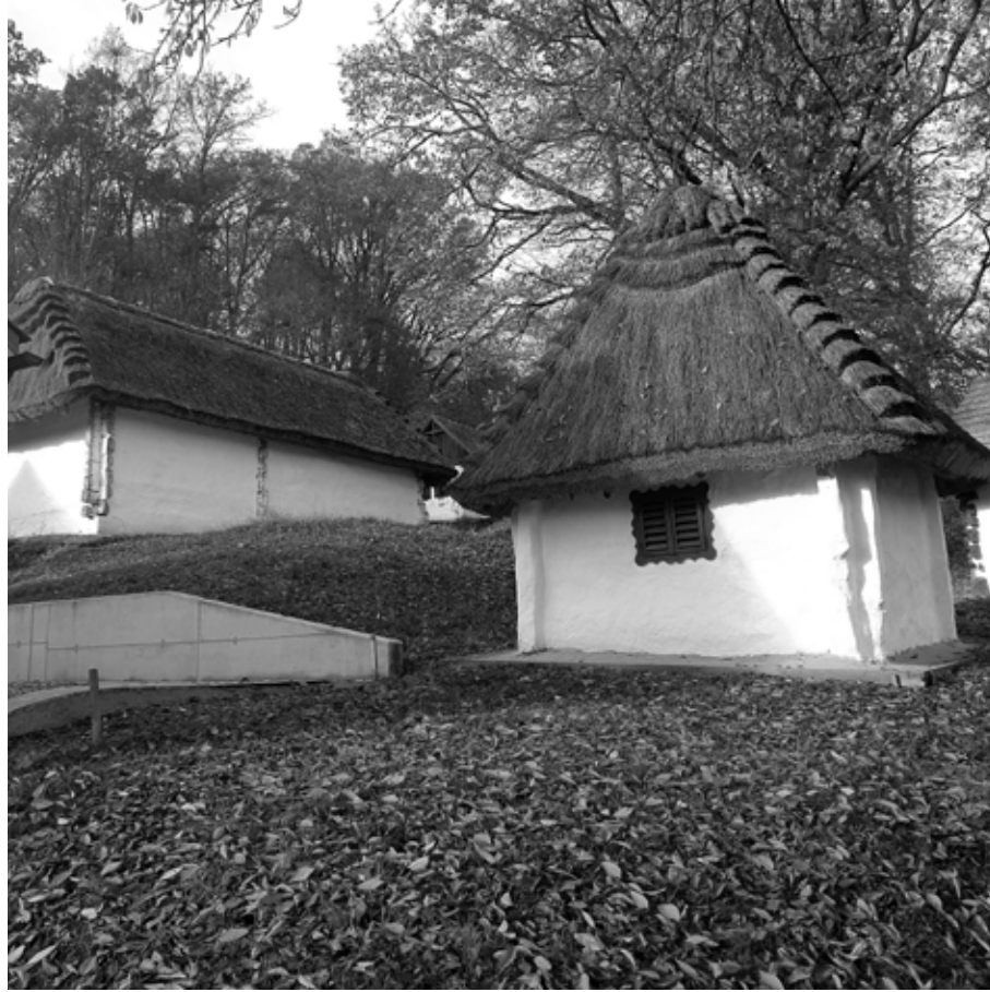
Abb. 8: In die Landschaft eingebettete Kellerobjekte mit Betonstützmauer
