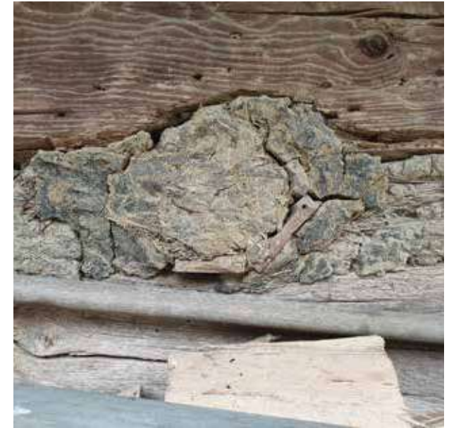
Abb. 118: Große Fugen wurden oft mit Lehm ausgefüllt, in diesem Fall mit Zugabe von Ziegelbruch
