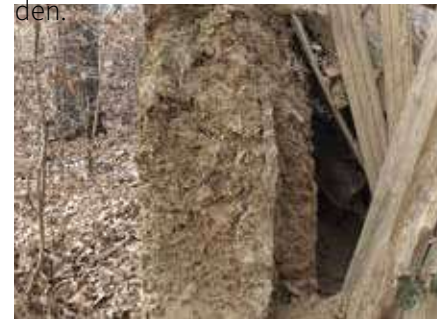
Abb. 119: Querschnitt der Lehm-mauer, Objekt 113
