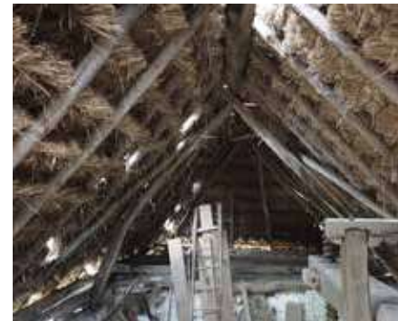
Abb. 129: Konstruktion des Scherenjochdaches im Objekt 130
