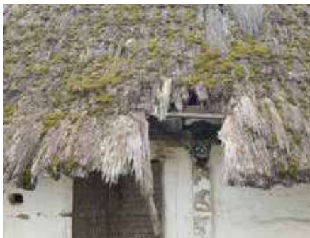
Abb. 157: Massive Schäden und Fehlstellen im Strohdach ziehen grobe Probleme an der Konstruktion durch eindringendes Niederschlagswasser nach sich
