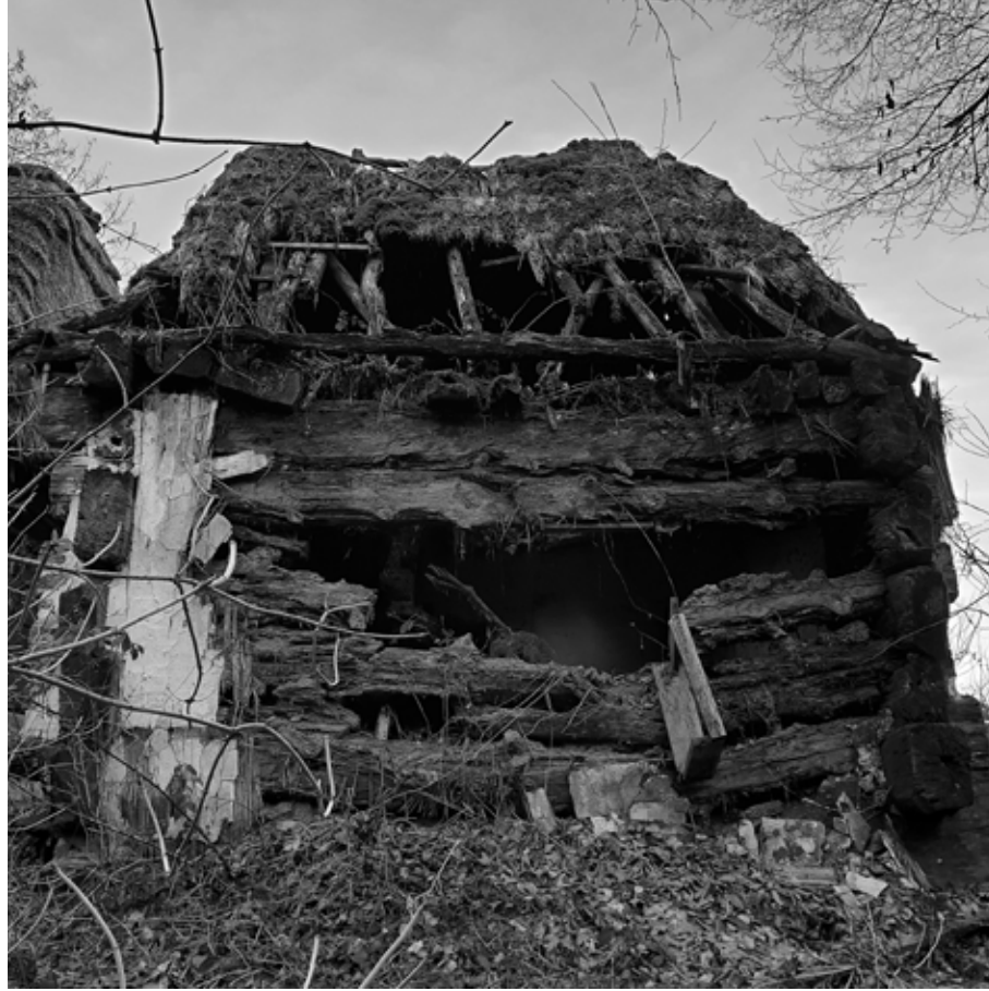
Abb. 2: Objekt Nummer 136. Die Rückseite gegenüber dem Wald ist bereits eingebrochen
