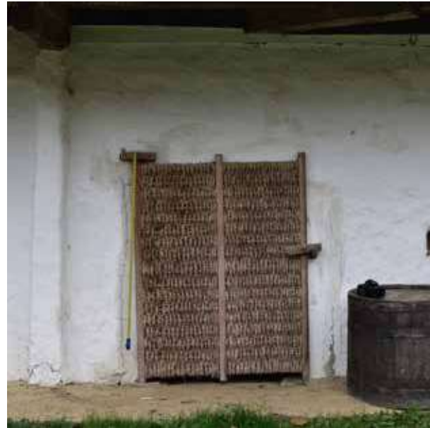
Abb. 141: Der Schließmechanismus ist ein einfacher kleiner Holzbalken, der drehbar mit einem Holz Nagel befestigt und mit einem Wandhaken neben der Türe fixiert wird
