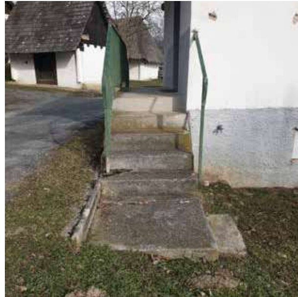
Abb. 151: Betonierte Treppe und metallene Absturzisicherung
