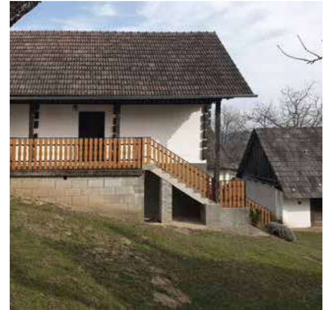
Abb. 152: Extreme Überformung, hier am Beispiel von Objekt 103
