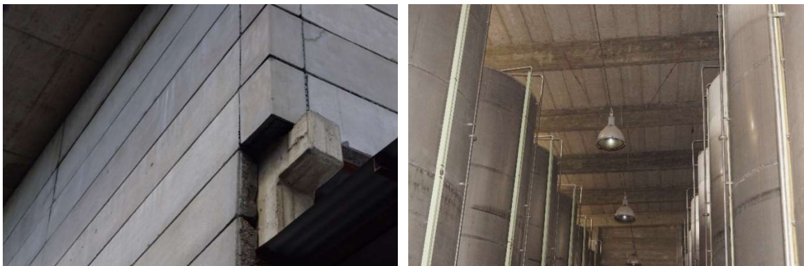
Abbildung 85 und 86: Weinlagerhalle/Rahovec, die Tarolitplatten sind mit Beton außen verkleidet
