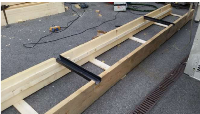
Abbildung 162: Befestigung der U-Profile mit Holzschrauben
