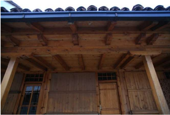
Abbildung 29: Vorbautragkonstruktion aus Holz
