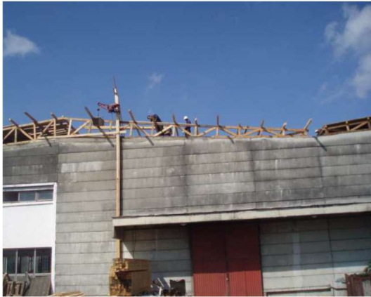
Abb. 82: Die Wand ist aus mehreren länglichen Tarolit-Platten gebaut
