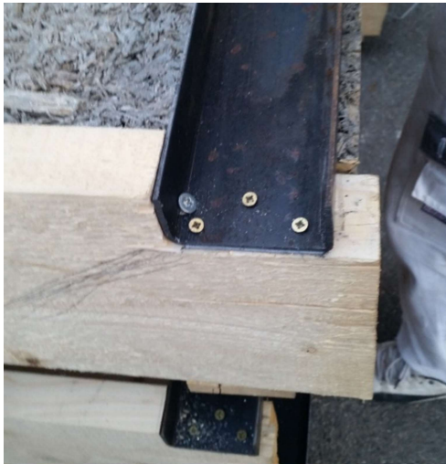
Abbildung 170: Bauteil P01 mit schräg eingebohrter Spax Senkkopf T-Star Holzschraube (7,5 x 200 mm) das U-Profil wurde mit 3 Spax Senkkopf T-Star plus 4CUT gleitbeschichtet (6 x 100 mm) befestigt.
