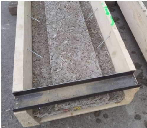
Abbildung 173: zweite VELOX Platte und HEKO Topix CC vor der Betonierung
