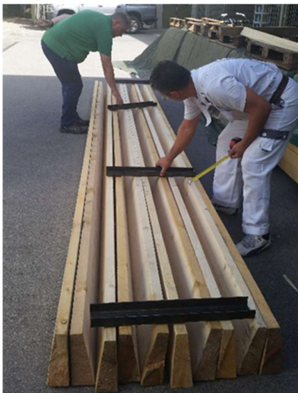
Abbildung 158: Vorbereitung für Stege
