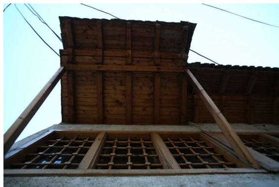
Abbildungen 27 und 28: Geschäftslokal aus Holztragwerken mit Sichtschutz- und Sonnenklappen
