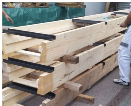
Abbildung 164: Balken mit Profilen gestapelt
