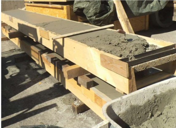
Abbildungen 175 und 176 : Auftragen des Betons bei beiden Konstruktionstypen (P01A – P03A) / (P04A und P04B)
