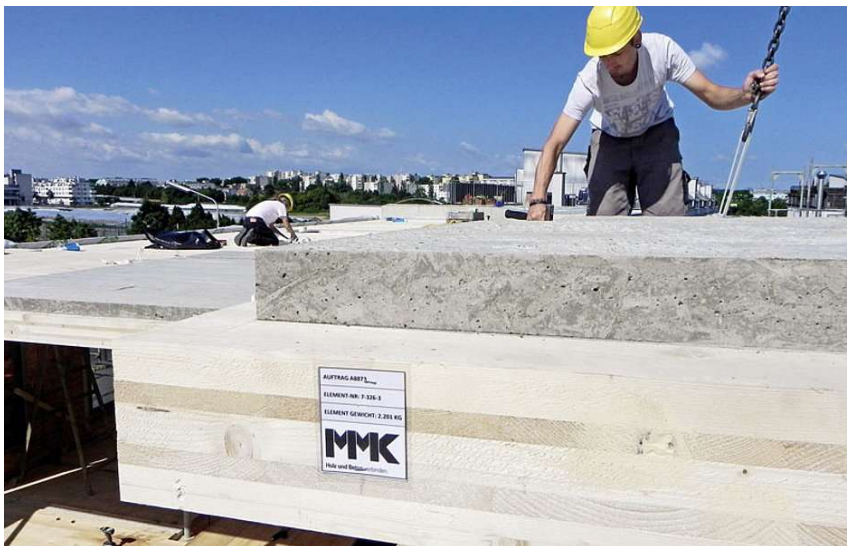
Abbildung 132: Deckenelement XC © von MMK Holz-Beton-Fertigteile während der Befestigung am Bauobjekt ( http://www.holzcluster-steiermark.at/index.php/755-clusterpartner-mayr-melnhof-praesentiert-gemeinsam-mit-kirchdorfer-beton-das-xc-holz-beton-verbundelement )
