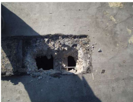
Abb. 80: durchgestemmtes Loch in der Tarolit-Decke – die feinen Sägespäne in einer relativ hohen Dichte sind gut erkennbar
