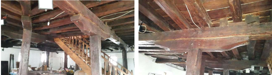
Abbildung 42 und 43: Holzdecke und Säulen im Erdgeschoss
