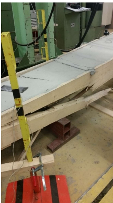
Abbildung 213: Bruch des Bauteils P04A 154 cm vom Bauteilende
