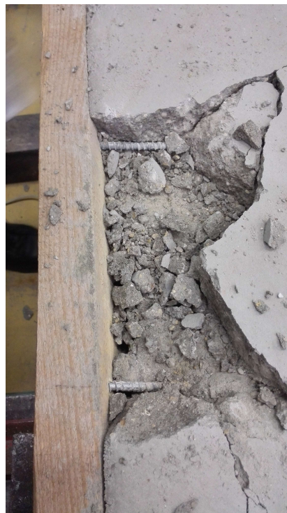
Abbildung 200: Öffnung der Betonplatte nach Bruch zur Darstellung der Schrauben am Bauteil P02A
