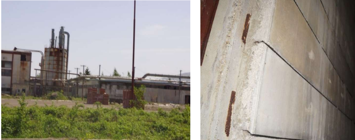
Abbildung 85 und 86: Weinlagerhalle/Rahovec, die Tarolitplatten sind mit Beton außen verkleidet
