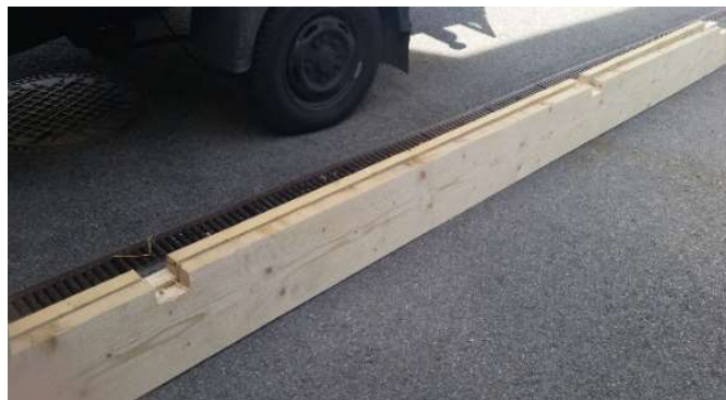
Abbildung 159: Balken mit gesägten Stegen
