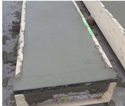
Abbildung 174 : Bauteil P04A betoniert
