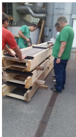
Abbildung 165 und 166: die geschnittenen Veloxplatten (200x50x5 cm) werden in die Konstruktion geschoben und danach mit Holzschrauben verbunden
