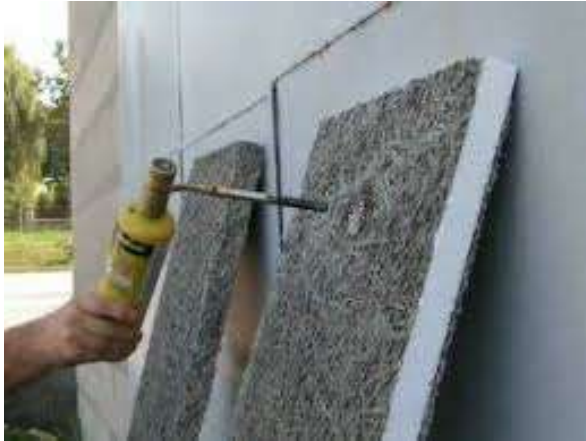
Abbildung 65: Tarolitplatte mit Stryopor ( aus: http://www.tarolit.co.rs/Classic1/index2.html )
