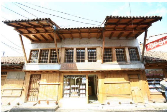
Abbildungen 27 und 28: Geschäftslokal aus Holztragwerken mit Sichtschutz- und Sonnenklappen
