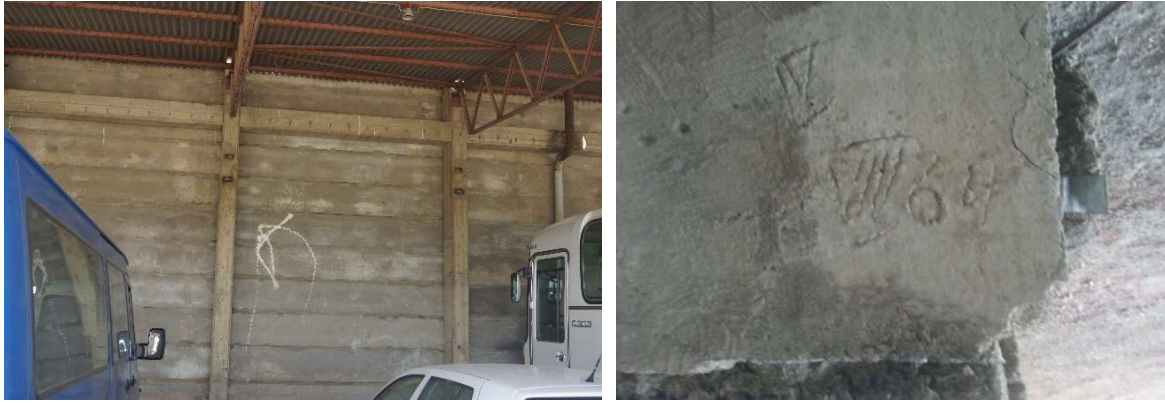
Abbildung 93 und 94: Wand mit Tarolitplatten, auf einer Tarolitplatte, welche noch Teile einer Fassade hat, ist das Jahr 64 eingeritzt, welches ein Beweis für das Alter der Tarolitplatten ist.
