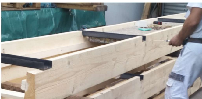
Abbildung 168 : Spax Senkkopf T-Star plus 8 x 200 mm Holzschraube mit Teilgewinde wird seitlich eingebohrt zur Befestigung der VELOX Platte
