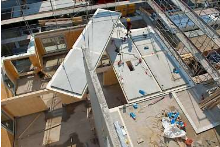
Abbildung 133: Ein Deckenelement XC© von MMK wird mit dem Kran auf das Holzgerüst aufgebracht.
