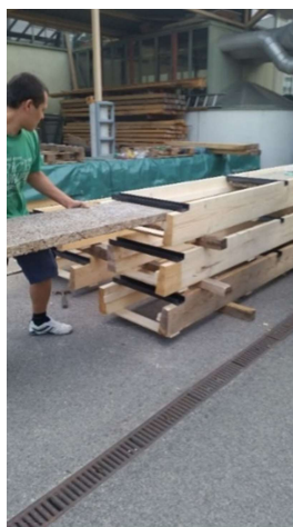
Abbildung 165 und 166: die geschnittenen Veloxplatten (200x50x5 cm) werden in die Konstruktion geschoben und danach mit Holzschrauben verbunden
