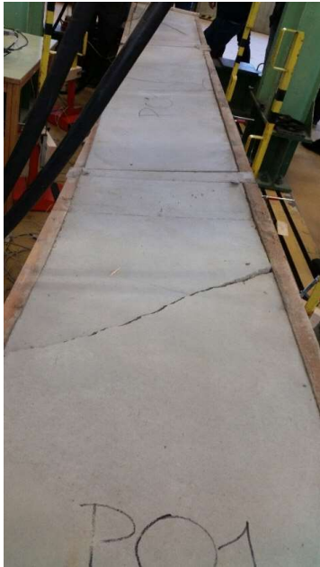
Abbildung 190: Bruch im Beton P01
