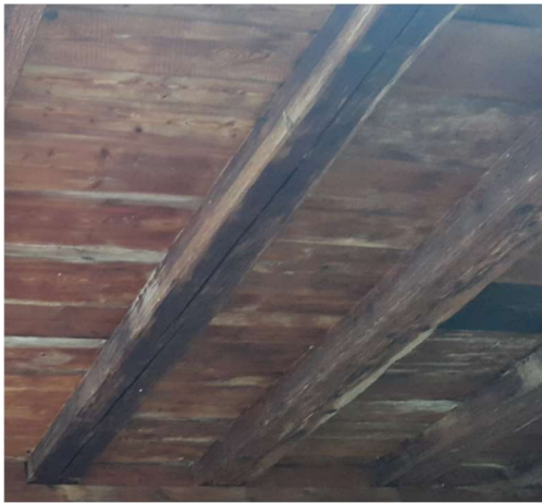
Abbildungen 38: Balkendecke aus Eichenholz aus einer Kulla
