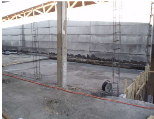
Abb. 82: Die Wand ist aus mehreren länglichen Tarolit-Platten gebaut
