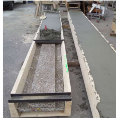
Abbildungen 175 und 176 : Auftragen des Betons bei beiden Konstruktionstypen (P01A – P03A) / (P04A und P04B)
