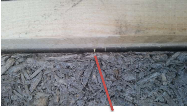
Abbildung 169 : Spax Holzschraube zwischen Balken und VELOX Platte
