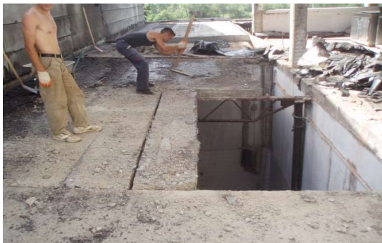
Abb.78: Arbeiter beim Versuch das Tarolit-Deckenelement manuell zu entfernen
