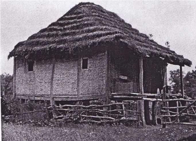
Abbildung 75: ein Haus in den Bergen aus Lehm und Holz mit einem Strohdach, es steht auf einem Holztragwerk aus unbehandelten dünnen Baumstämmen (Bartl, 1995)
