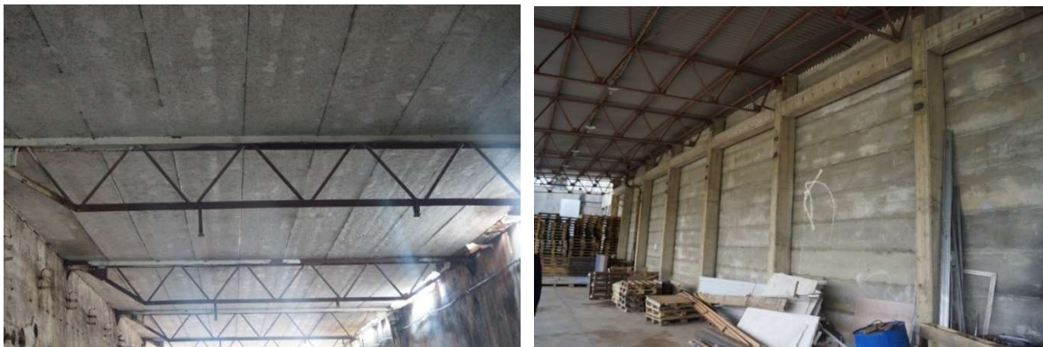
Abbildung 90 bis 92: Tarolitplatten werden teilweise auch als Deckenelemente verwendet – sie werden von einem Stahlbetonbalken gestützt – zusätzlich werden Stahlgerüste zur Fixierung angebracht
