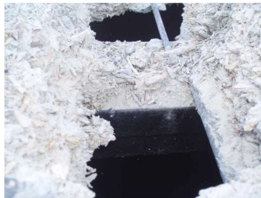
Abb. 80: durchgestemmtes Loch in der Tarolit-Decke – die feinen Sägespäne in einer relativ hohen Dichte sind gut erkennbar
