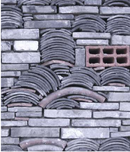
Abb.17 Waddetail in "Wa Pan"-Technik, bei der Fragmente von gefundenen Materialien in die Fassade integriert werden, Ningbo Museum, 2008
