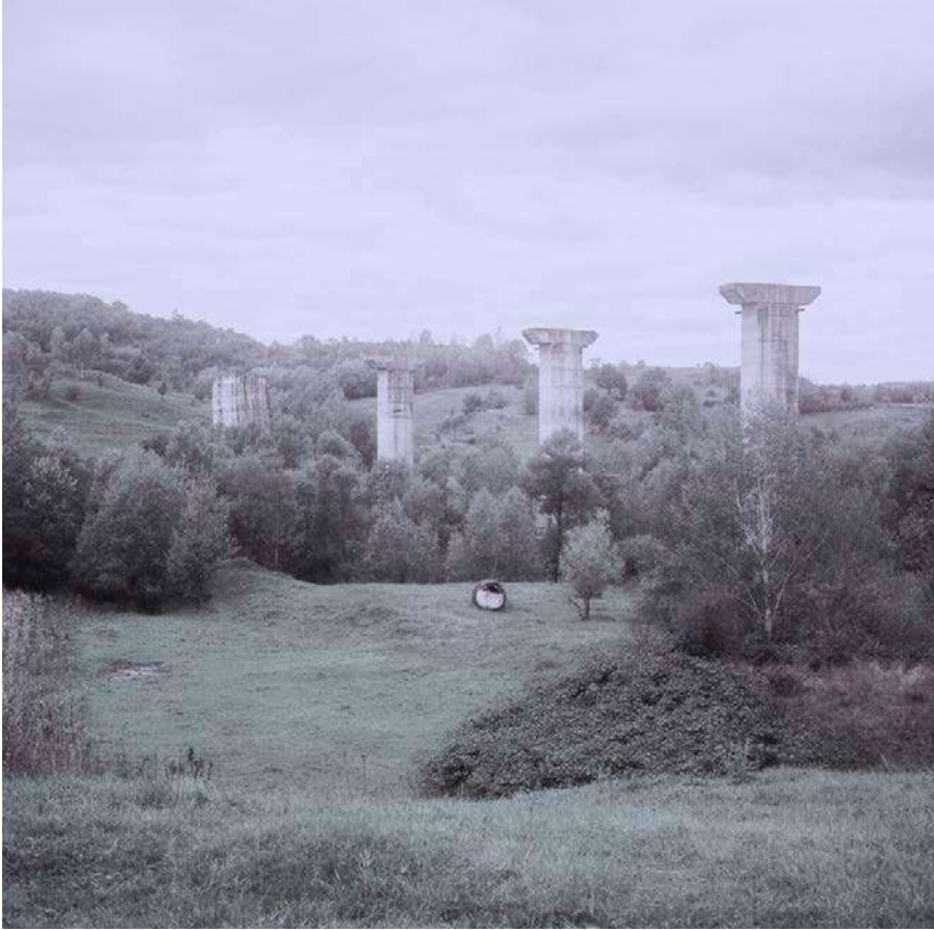
Abb.36 Pfeiler einer unvollendeten Brücke bei Rosia de Amaradia, Gorj, Rumänien, 2014
