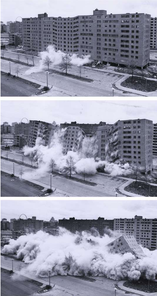
Abb.15 Pruitt-Igoe Anlage-der zweite, weithin im Fernsehen übertragene Abriss, der auf den Abriss vom 16. März folgte, St. Louis, Missouri, April 1972
