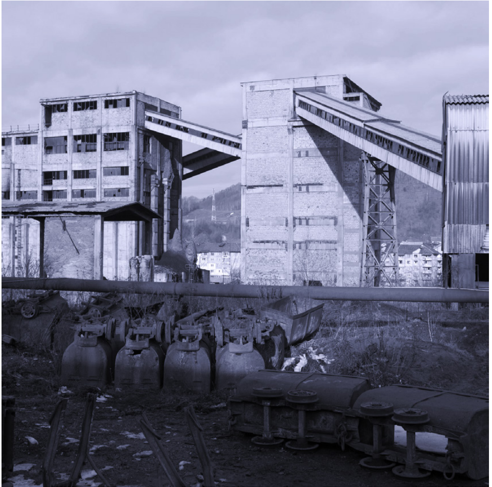
Abb.31 die Waggons, die einmal für den Kohletransport im Petritu-Bergwerk verwendet wurden, liegen nach der Schließung des Bergwerks im Jahr 2015 verlassen auf dem Gelände. Die Gebäude des ehemaligen Bergwerks verfallen auch langsam. Petritu, Rumänien, 2016
