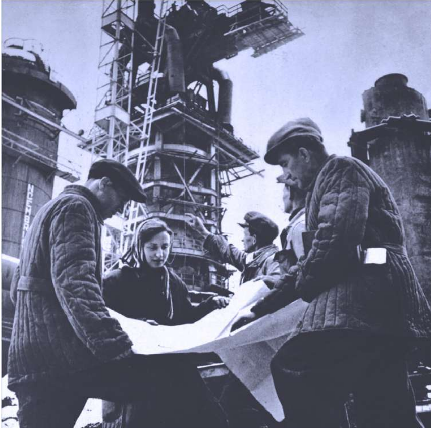
Abb.29 ArchitektInnen auf dem Baustellengelände des Stahlwerks Hunedoara, Rumänien, 1952
