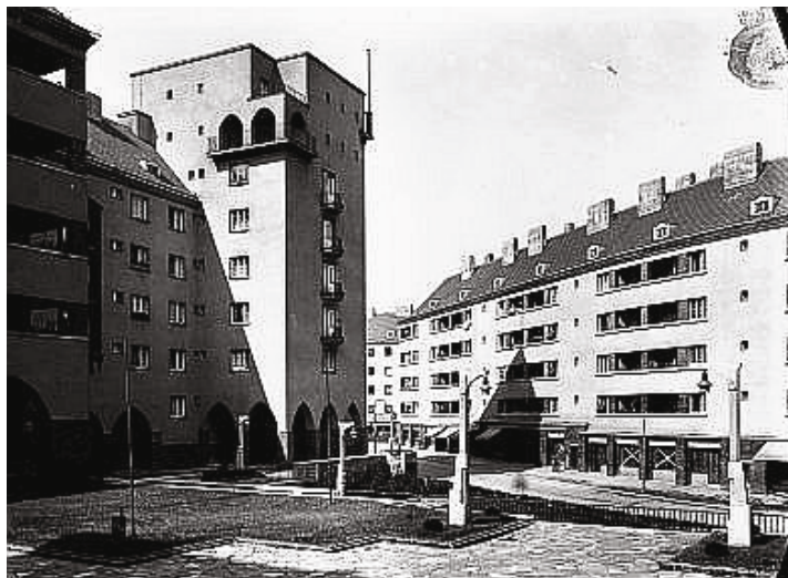
Städtische Wohnbauten in Wien Erdberg Rabenhof
