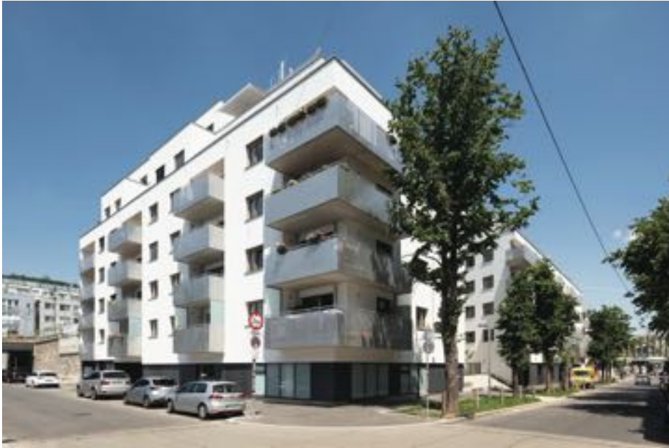
Balkone in 1170 Heigerleinstraße
