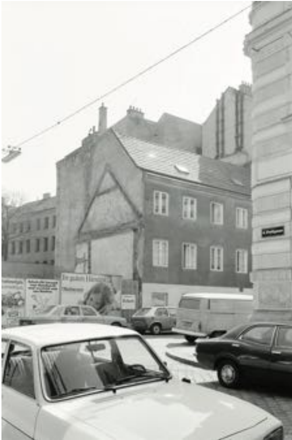
Schäffergasse 11 und Baulücke ON. 9 mit Abbruchspuren Schäffergasse 11 - 1 zur Waaggasse Baulücke Schäffergasse 18 - 20
