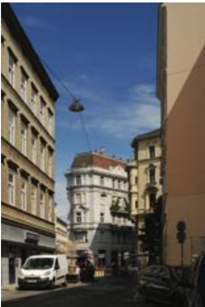
Die ‚Heumühle‘ und die Aufstockung Heumühlgasse 9 Die ‚Heumühle‘ von der Grüngasse Hofansicht Heumühlgasse 11 Blick von der Schönbrunner Straße zur Heumühlgasse 6 – 8 Feuermauer Margaretensstraße 44 von der Heumühlgasse Heumühlgasse zur Einmündung der Preß- und der Waaggasse
