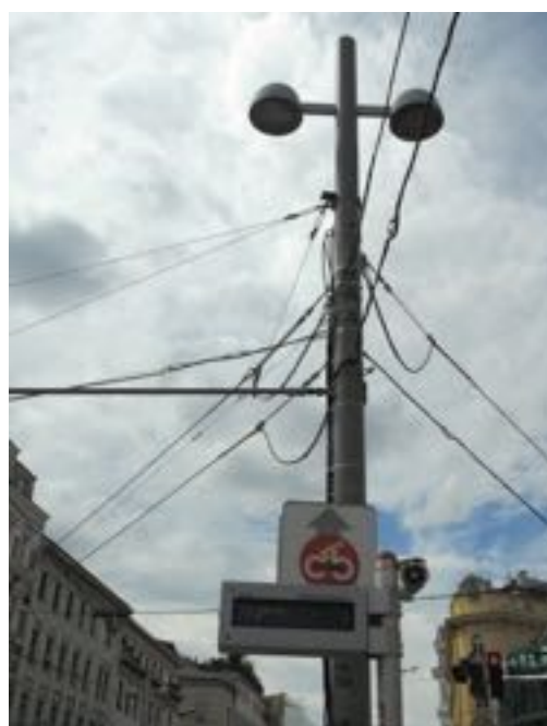
Mastwirkungen am Fasanplatz
