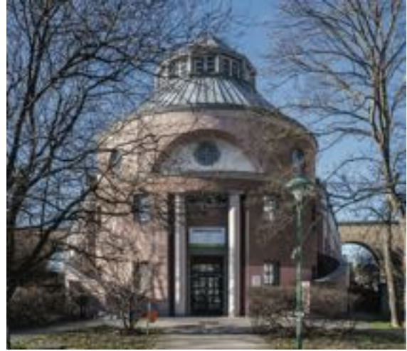
Wohnhausanlage Wien - Breitenfurter Straße
