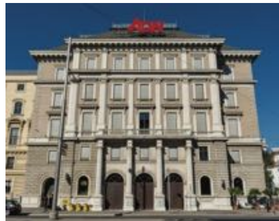
Wiederaufbau als SBER-Bank (Arch. Lippert)
