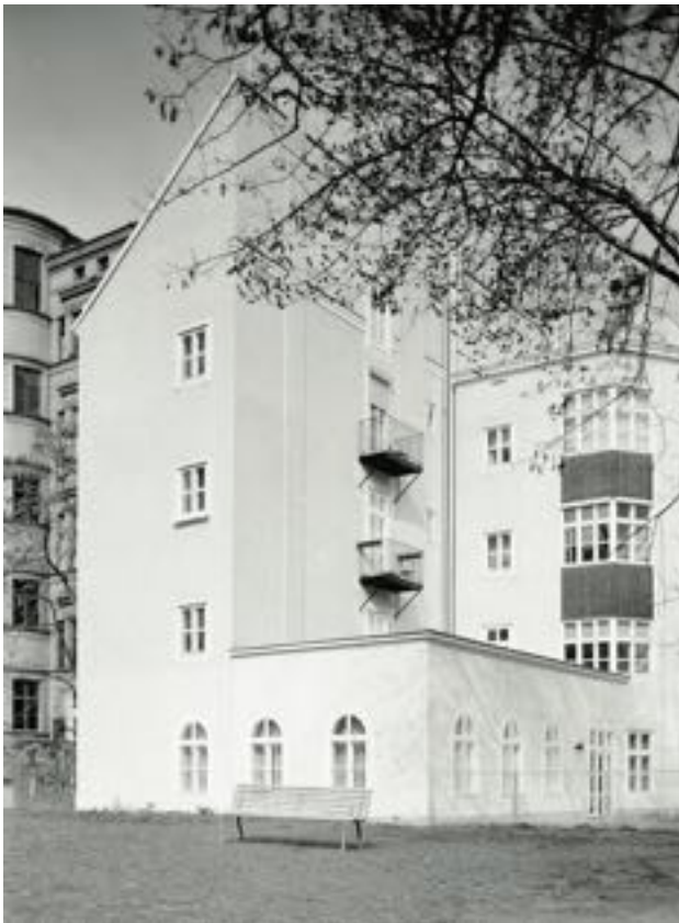
Feuermauer Margaretenstraße 34 ,Planquadrat'-Hof
