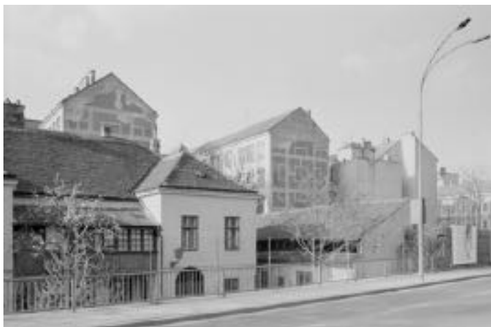
Feuermauern an der Linken Wienzeile/Stiebergasse 1985
