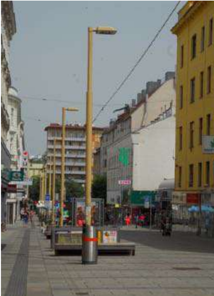
Blick zum Wiental mit neuen Mastleuchten
