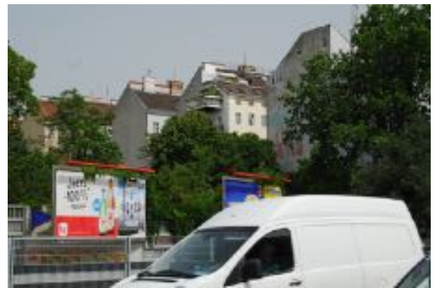
Feuermauerdurchbrüche mit Balkonen und Fenster Linke Wienzeile 22/Girardigasse
