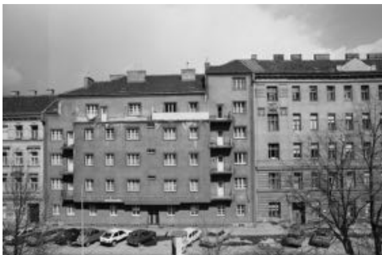
Gestalterisch bedingte Gesimsanpassung der Zwischenkriegszeit (3, Göllnergasse 25)
