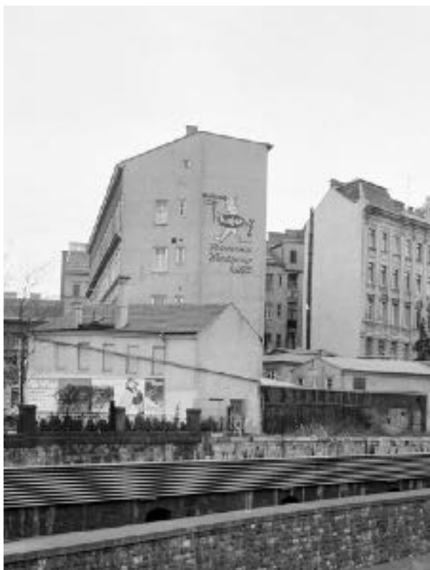
Feuermauerwerbung Rechte Wienzeile 65
