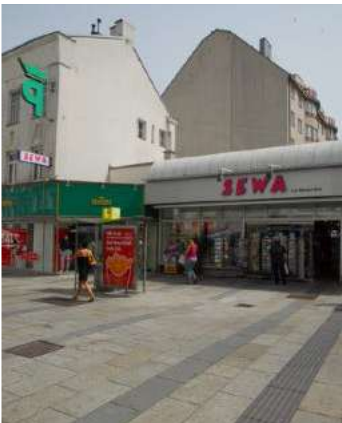
Raumbildende Feuermauern an der Einmündung der Zeleborgasse
