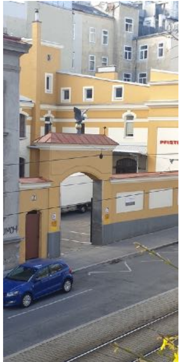
Augasse Detailansicht O.N. 17
