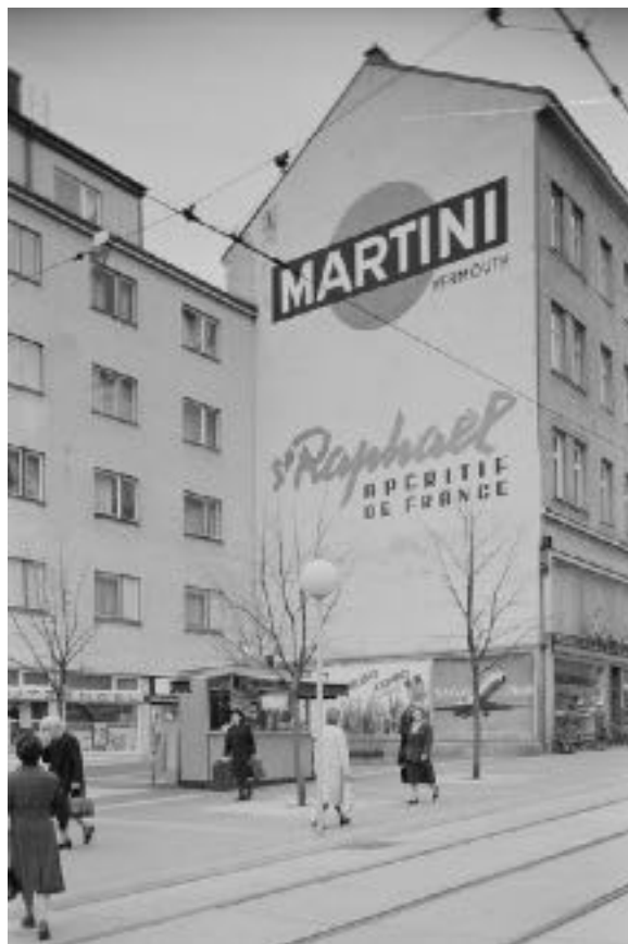
Werbeflächen an Baukörpervorsprung
