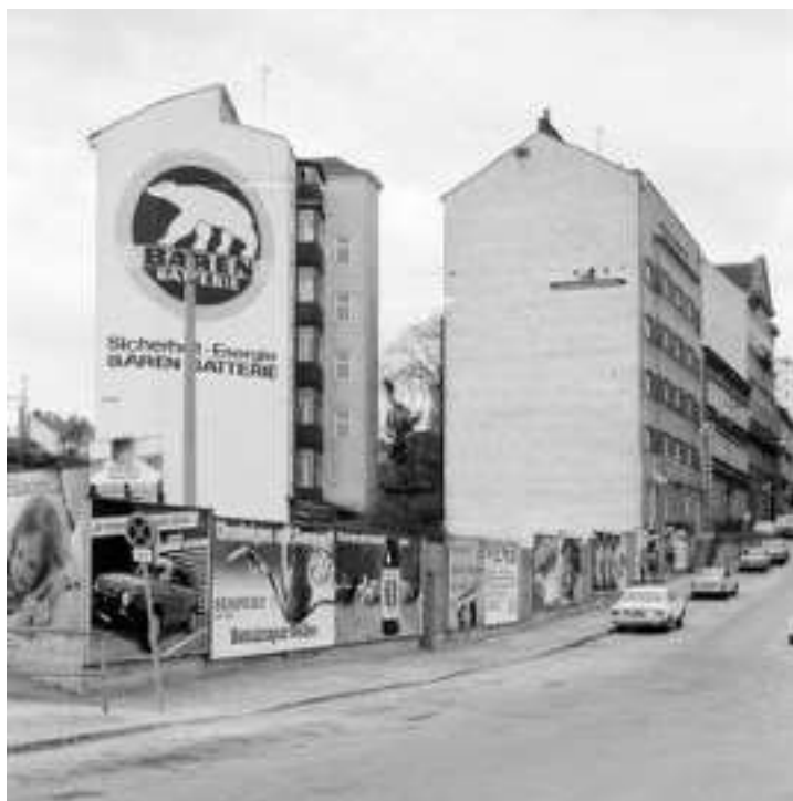
Feuermauerhäufung 1985 Linke Wienzeile 206/Diefenbachgasse
