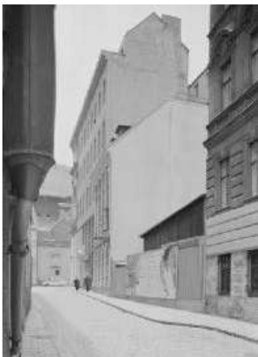
Hochaufragende Feuermauern in der Spittelberggasse
