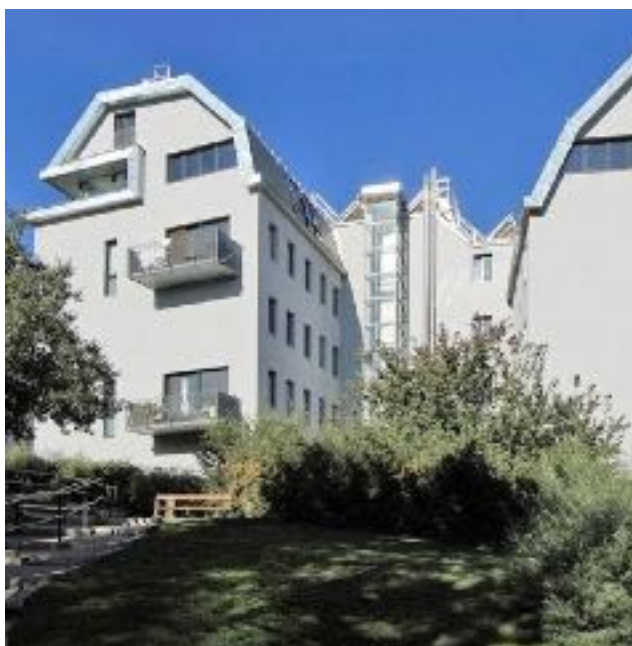
Erdbergstraße 120: Funktionell gestalte Feuermauer am ‚Fiakerbergl‘ 2021
