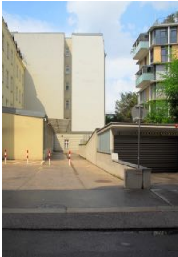
Garageneinfahrt der Neubebauung Taubstummengasse
