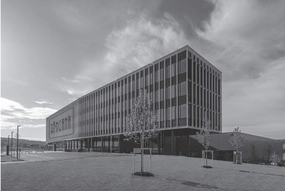
Abb. 1: Der neue RINGANA campus, integral mit BIM geplant von ATP Wien © ATP/Pierer
