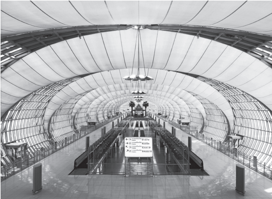
Abb. 6: Innenansicht einer Concourse – durch die textile Fassade gelangt viel Tageslicht ins Innere; ein spezieller dreilagiger Aufbau schützt vor thermischen und akustischen Immissionen © Rainer Viertlböck, Gauting
