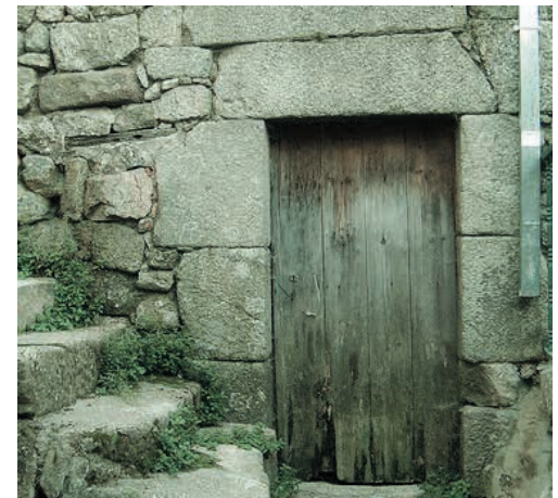
Abb.43: Sturz und Laibung eines Hauses
