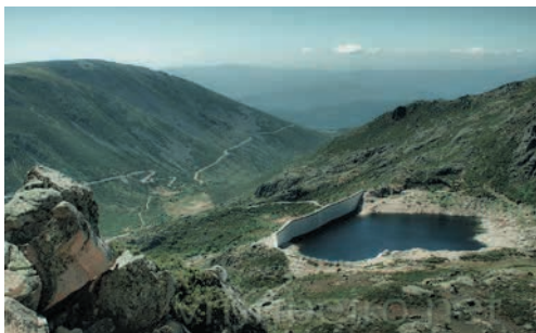
Abb.5: Albufeira da Barragem do Covao de Ferro
