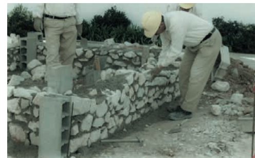
Abb.63: Beschichtung des Steinmauerwerks mit Steinen und Mörtel
