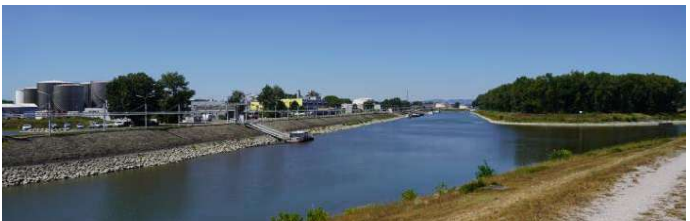
Abb. 21: Ölhafen Lobau, rechts Beginn des Donau-Oder-Kanals
