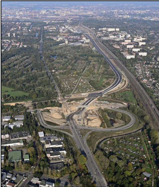
Abbildung 22: Verlegte Reichsstraße, Quelle: G + S Planungsgesellschaft mbH, o.J., Foto: DEGES
