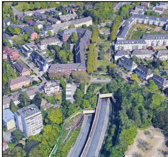
Abbildung 31: Überdeckung in Bochum, Quelle: Google Earth, 2022
