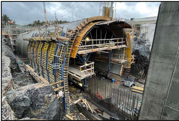
Abbildung 40: Gewölbequerschnitt, Quelle: Doka GmbH, o.J.
