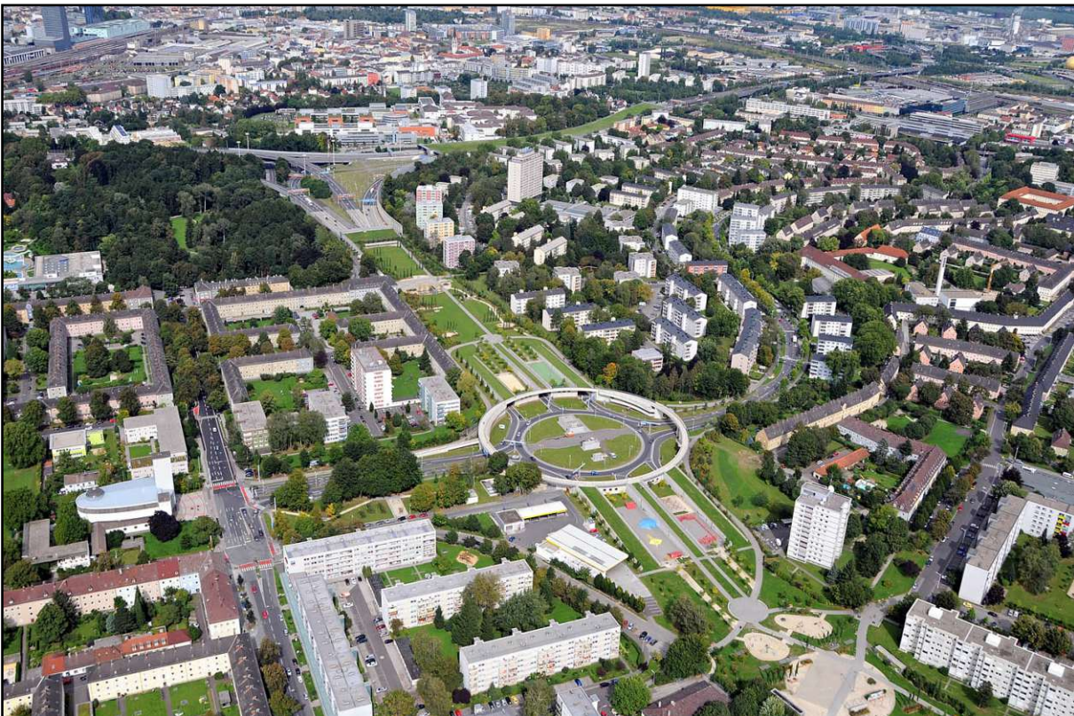
Abbildung 54: Überdeckung BinderMichl - Blickrichtung Nord, Quelle: Mauerer, 2022
