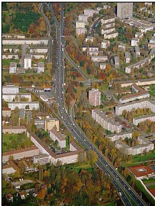
Abbildung 50: A7 Linz vor der Überdeckung, Quelle: Stadt Linz, 2009
