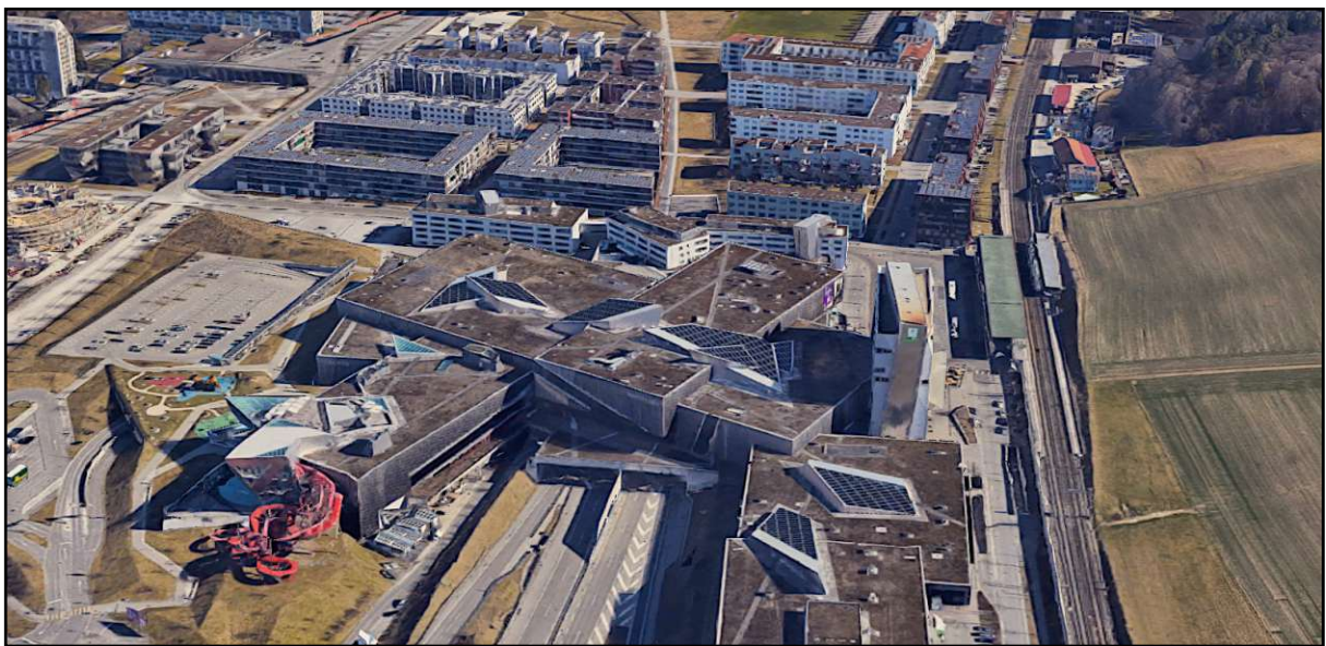
Abbildung 48: Quartier Bern-Brünnen - Übersicht, Quelle: Google Earth, 2022
