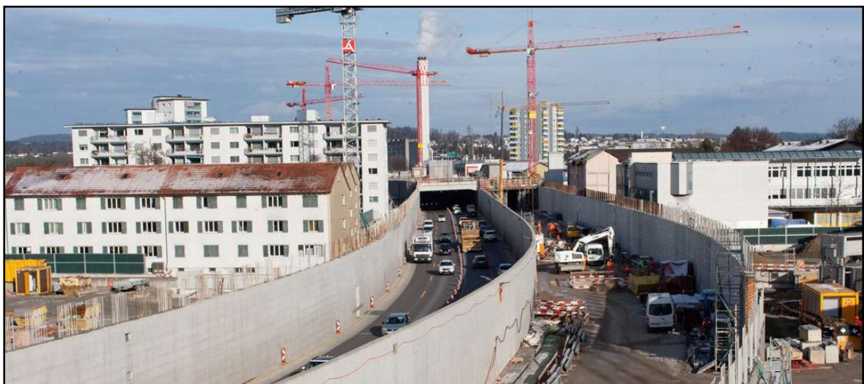
Abbildung 66: Einhausung Schwamendingen - Baustelle, Quelle: Stadt Zürich, o.J. Foto: Ruth Erdt.
