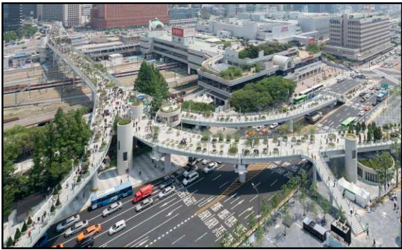
Abbildung 21: Hochstraße Seoul nachher, Quelle: Van Duivenbode, o.J.
