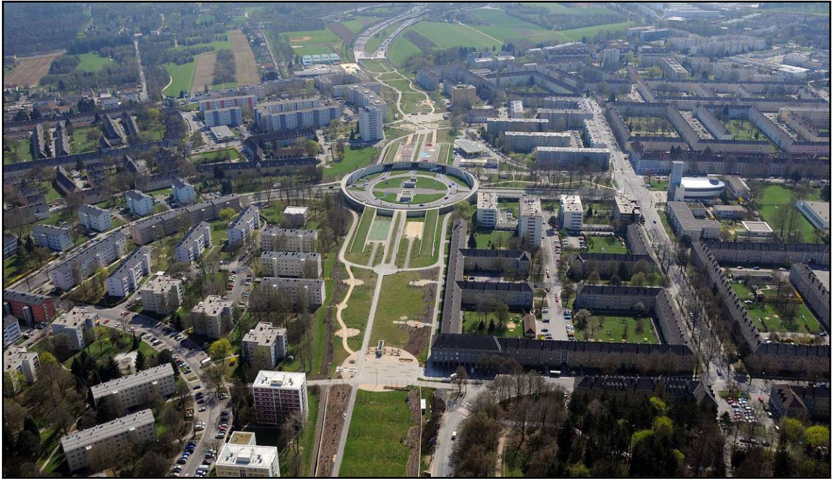
Abbildung 55: Überdeckung Bindermichl - Blickrichtung Süd, Quelle: Maurer, 2022
