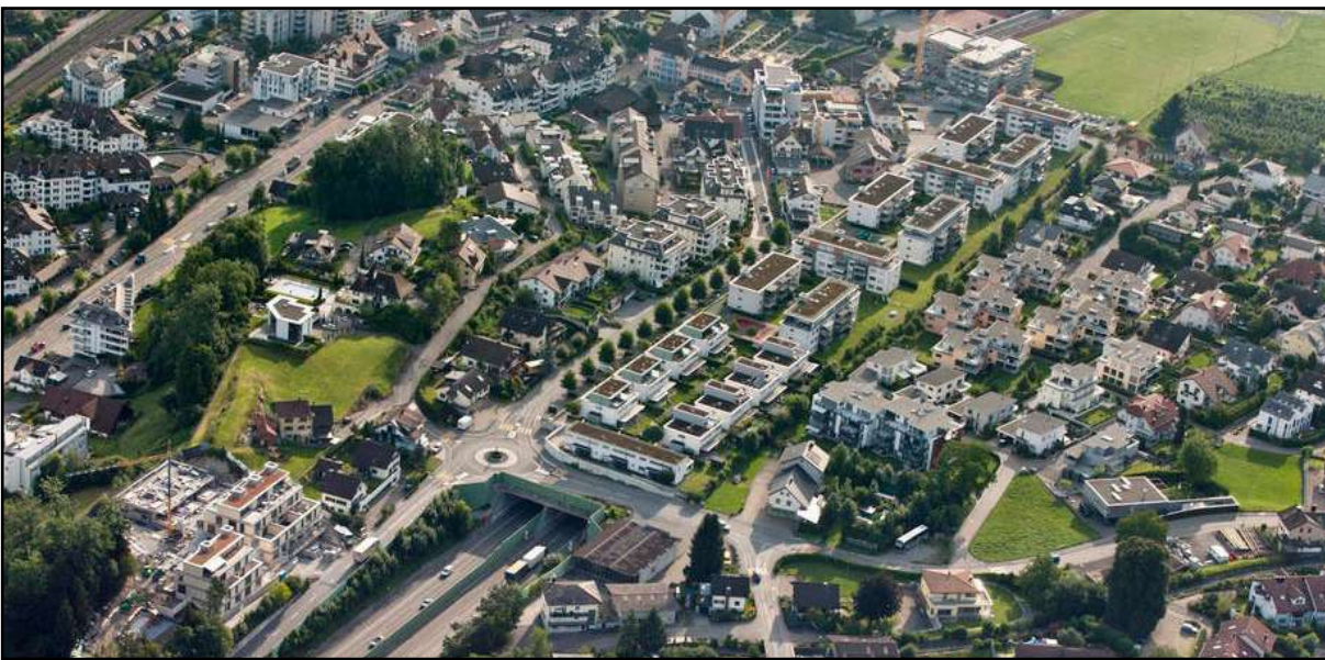
Abbildung 44: Autobahnüberdeckung Altendorf, Quelle: Rudolf, 2015, Foto: Keystone
