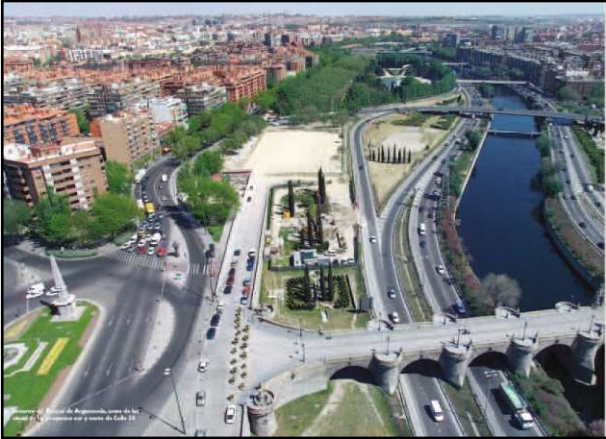
Abbildung 24: Madrid Manzanares vorher, Quelle: Congress for the New Urbanism, o.J., Foto: Escuela de organización industrial
