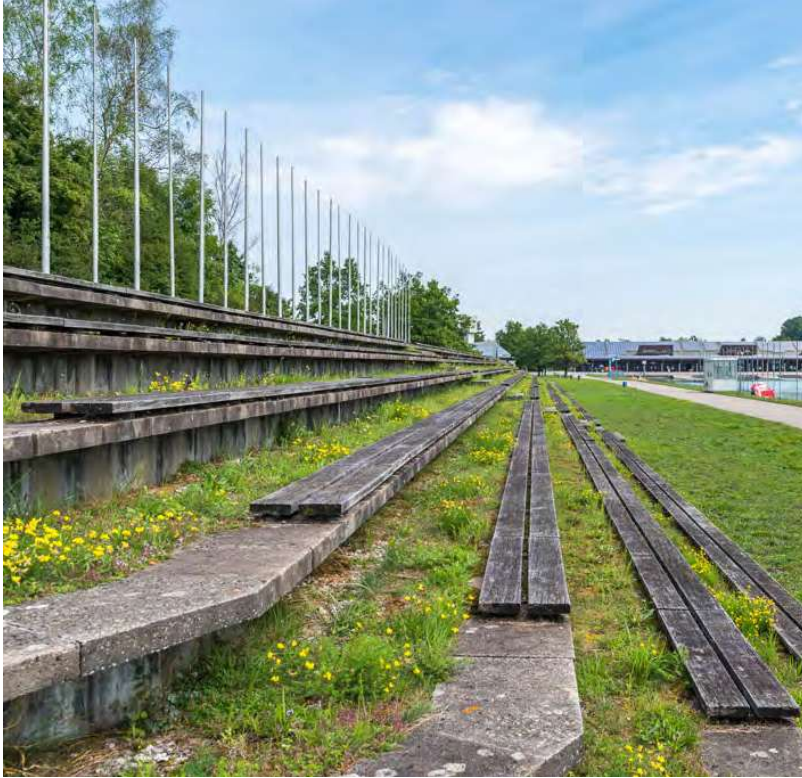
Abb. 99 Bauplatz, alte Tribünenstufen
