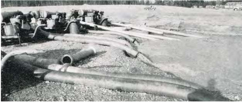
Abb. 36 Baustelle während Aushubarbeiten
