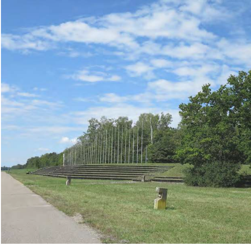
Abb. 101 Blick von Uferstraße auf den Bauplatz
