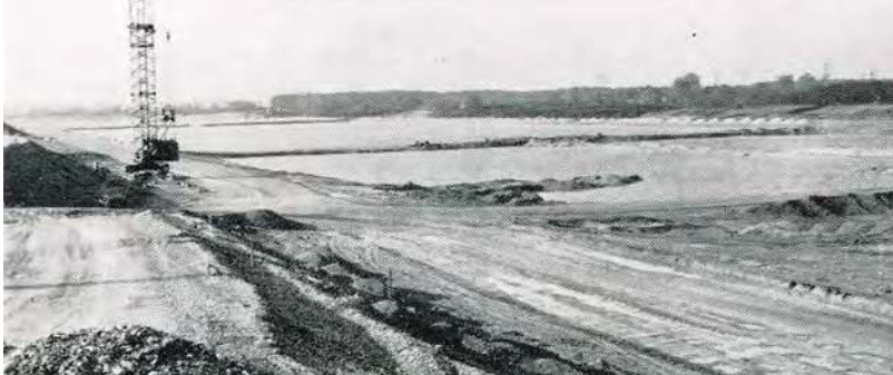
Abb. 35 Blick auf Baustelle Regattatrog
