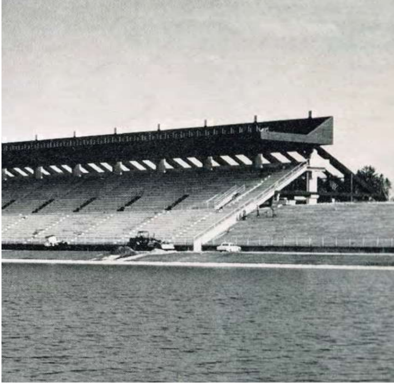
Abb. 22 Haupttribüne kurz vor der Fertigstellung
