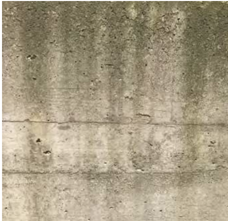
Abb. 122 Sichtbeton gealtert
