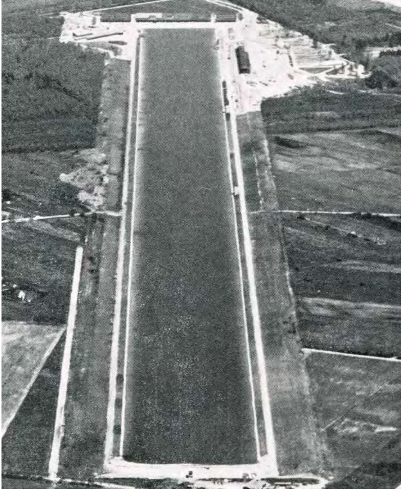
Abb. 37 Olympische Ruderregatta im Bau
