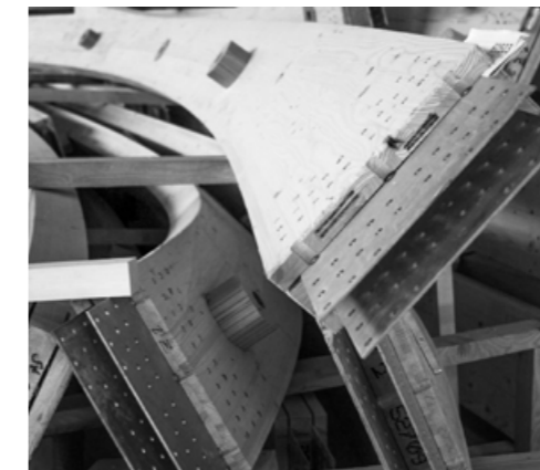
Abb. 29: Holzknoten der Dachschaale, Centre Pompidou Metz, Amann Holzbau
