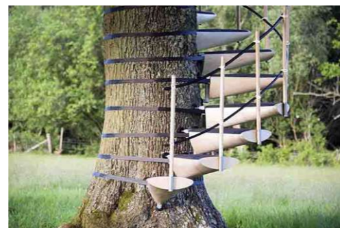
Abb. 33 Treppen mittels Klemmmethode am Stamm befestigt
