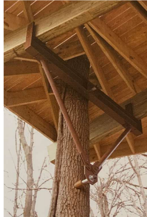
Abb. 25 Garnier-Schraube trägt ein ganzes Baumhaus
