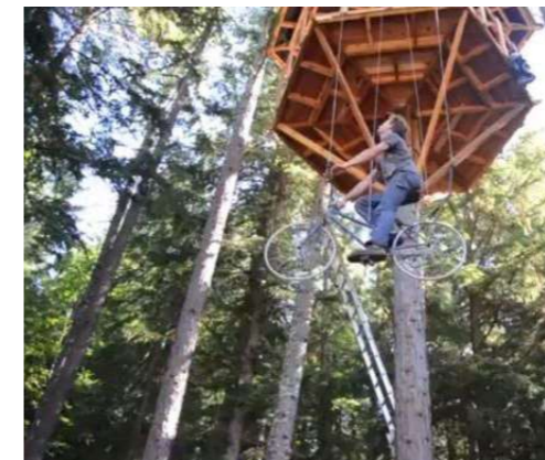
Abb. 35 Ein Baumhaus wird mit einem Radlift erschlossen
