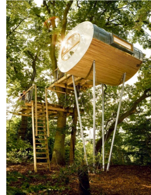
Abb. 28 Vier zarte Stahlsäulen tragen das Baumhaus, Andreas Wenning, Gross Ippener, Deutschland, 2008
