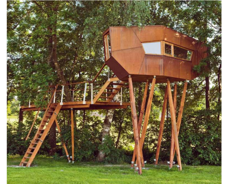
Abb. 29 Ein Baumhaus auf Holzpfählern, Andreas Wenning, Eberschwang, Österreich, 2008
