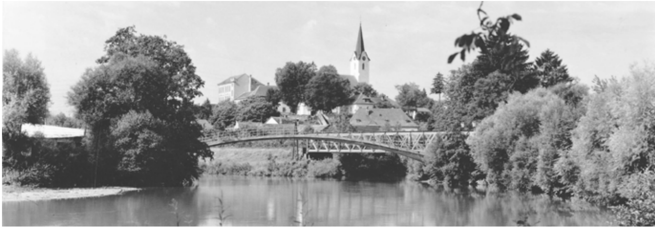
Abb. 2: Bogenbrücke über den Erlaufzwiesel mit dahinterliegenden Kirchenberg, 1963
