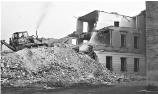
Abb. 11: Schule am Berg- Abriss 1984
