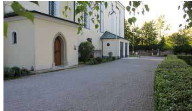
Abb. 14: Vorplatz mit Zugang Oktogon, dahinter Haupteingang Nord
