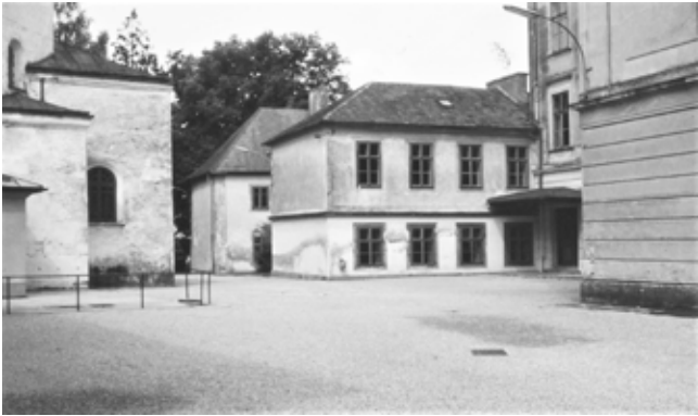
Abb. 10: Schule am Berg- Abriss 1984
