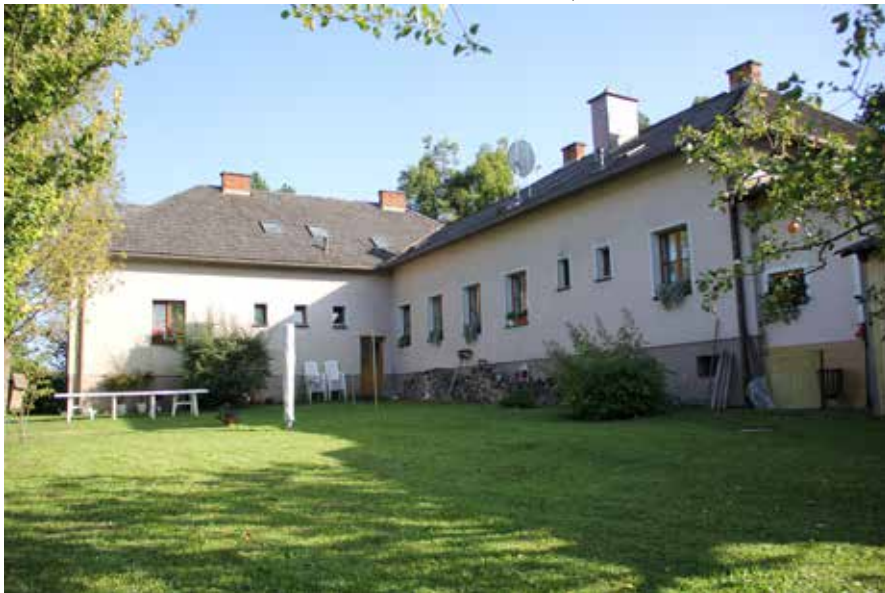
Abb. 20: Das neue Pfarrhaus, Ansicht Nordwest (Gartenansicht)
