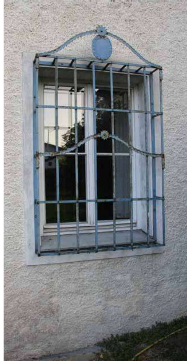
Abb. 24: Alter Pfarrhof, Detailansicht: Schmiedeeisener Fensterkorb
