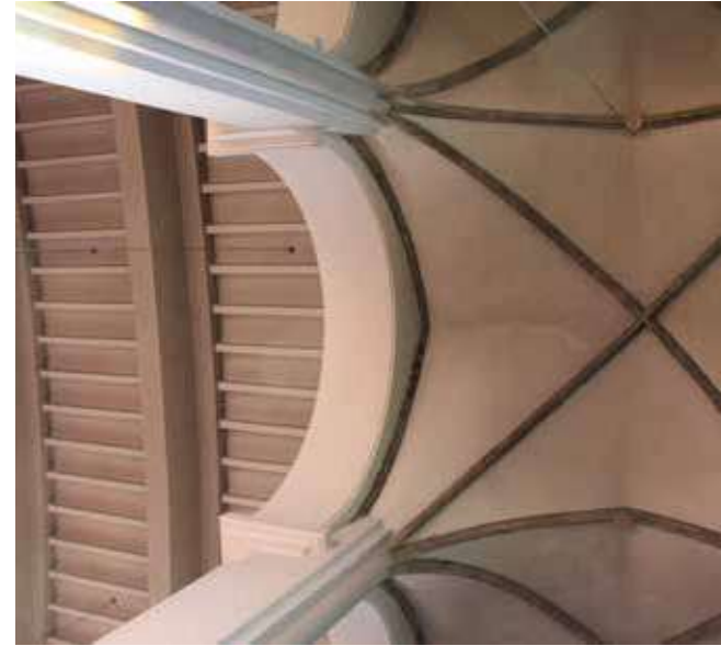
Abb. 17: Kreuzrippengewölbe mit Übergang zum Erweiterungsbau
