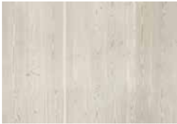
Holzstützen, unbehandelt Fassade und Tragstruktur
