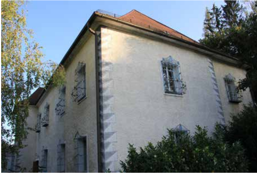
Abb. 22: Alter Pfarrhof, Ansicht Nordwest (Straßenansicht- Pfarrhofgasse)
