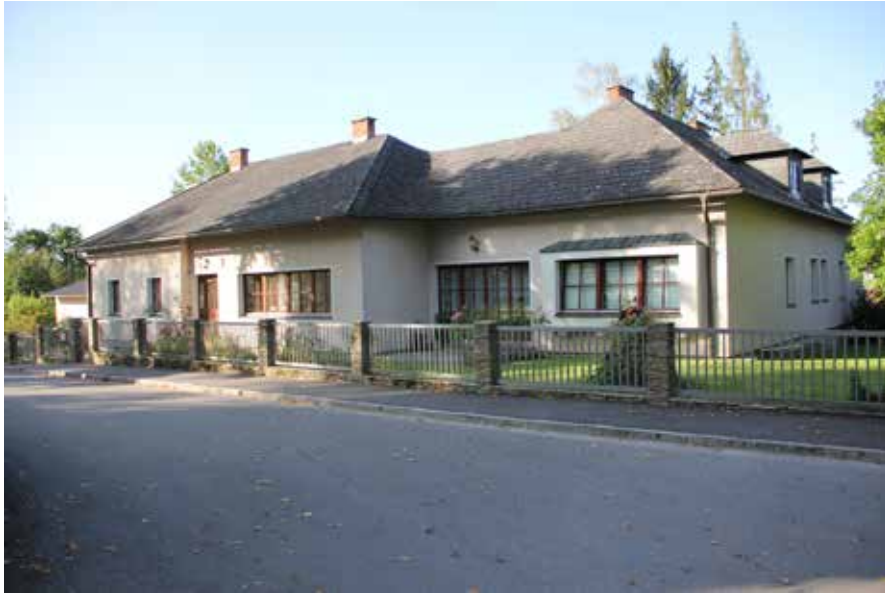
Abb. 19: Das neue Pfarrhaus, Ansicht Süd (Straßenansicht- Kirchenplatz)
