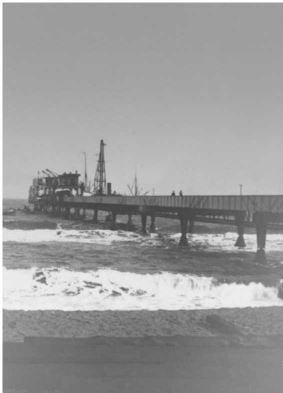
Abb. 35: Bei einer Sturmflut im Jahr 1905 wurde die Loméer Landungsbrücke in Togo vollständig zerstört. ©AWGS
