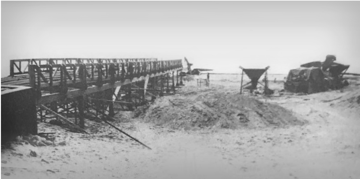
Abb. 52: Aufgrund der starken Brandung mussten die Bauarbeiten immer wieder unterbrochen werden.
