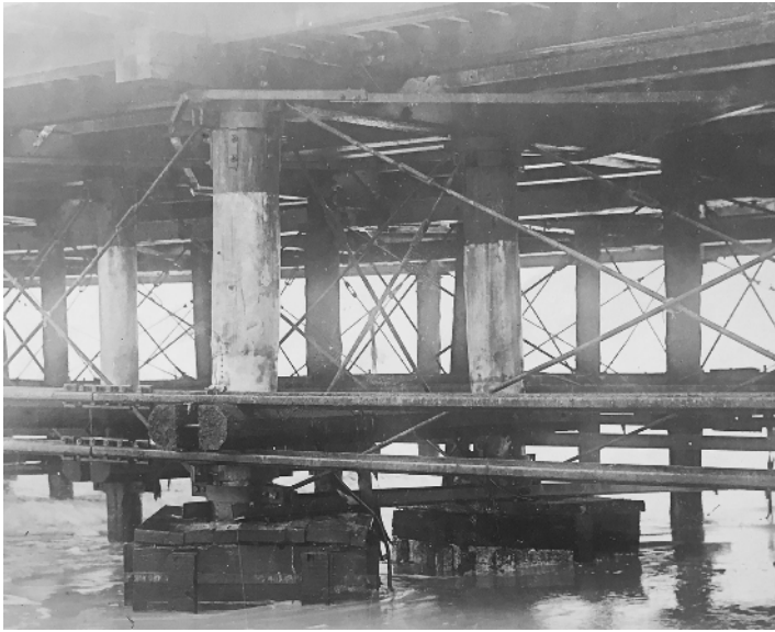
Abb. 45 + 46: Die linke Aufnahme zeigt eine provisorische Pfahlgründung - rechts ist der Unterbau zu erkennen. ©AWGS
