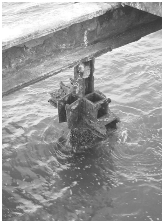
Abb. 61: Blick auf einen Pfahl am Brückenkopf. ©Y.Rödel
