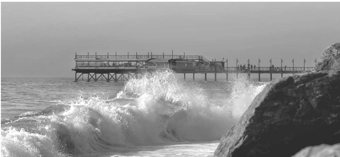
Abb. 72: Nur wenn die Brücke einer regelmäßigen Wartung und Pflege obliegt, wird sie in Zukunft erhalten bleiben. ©Y.Rödel
