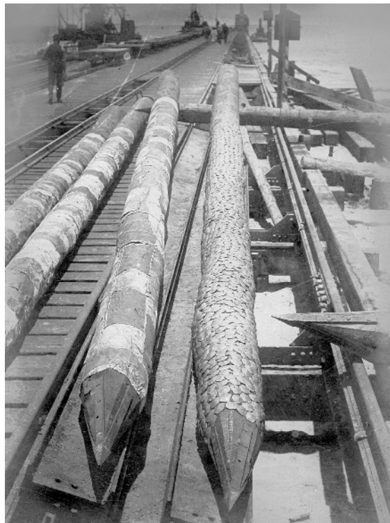
Abb. 32: Bei den Sanierungsarbeiten.
