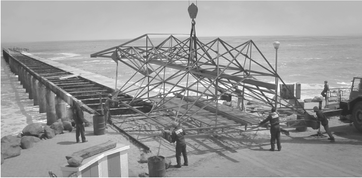
Abb. 54: Um die Statik der Brücke zu schonen, wurde ein Laufkran aus einer innovativen Fachwerkstruktur erstellt. ©AWGS
