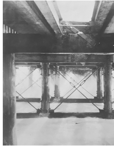
Abb. 45 + 46: Die linke Aufnahme zeigt eine provisorische Pfahlgründung - rechts ist der Unterbau zu erkennen. ©AWGS
