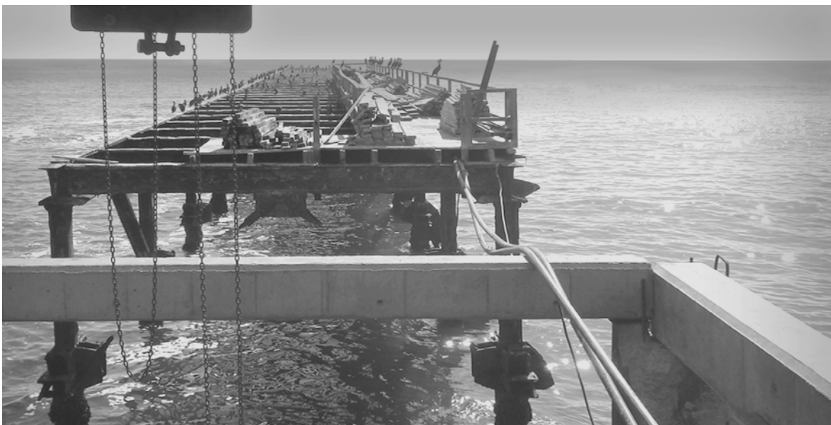
Abb. 55: Nach eingehender Überprüfung wurde entschieden, auch den Brückenkopf zu sanieren.
