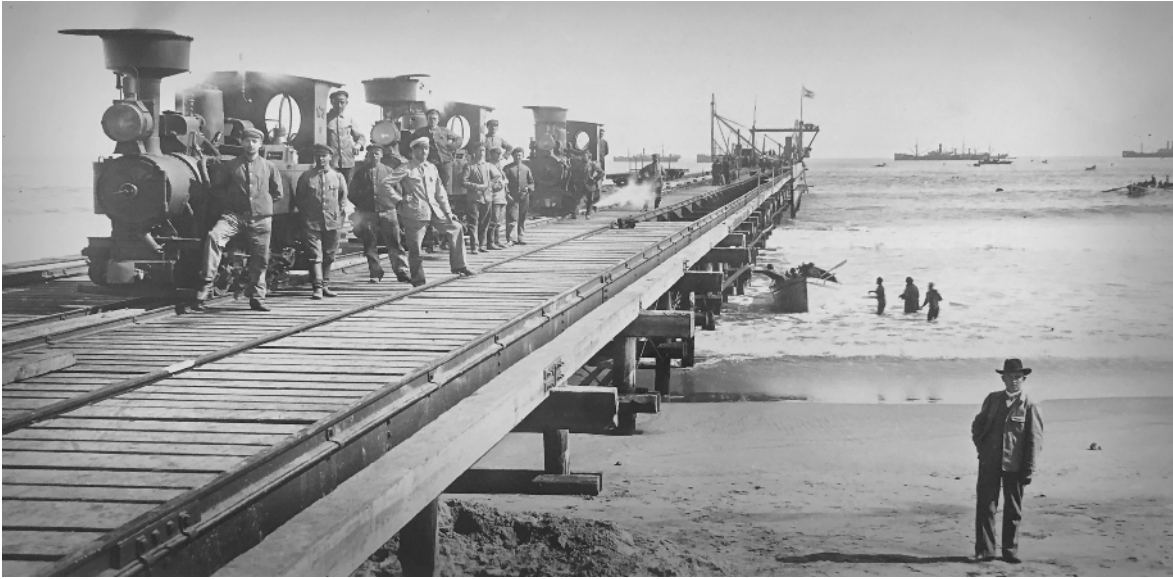
Abb. 33: Die Aufnahme zeigt die verbreiterte Brücke nach den erfolgten Belastungsproben.
