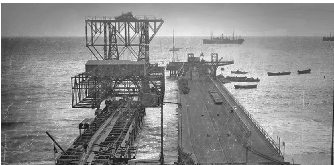
Abb. 42: Knappe Angelegenheit: Die „Jetty“ wurde nur 5 Meter südlich ihres hölzernen Vorgängerbaus errichtet. ©AWGS
