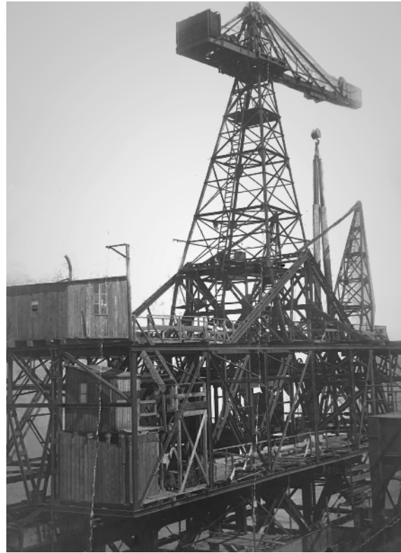
Abb. 43: Das Gerüst der Jetty samt der Bohrkräne. ©AWGS
