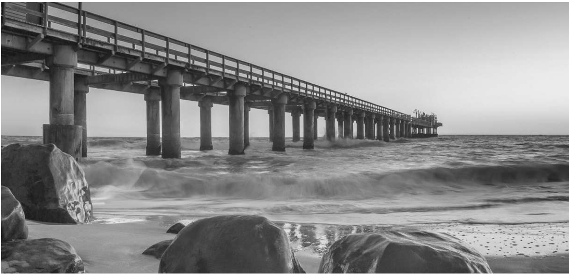
Abb. 56: Auch über 10 Jahre nach Abschluss der Sanierungsarbeiten ist das Bauwerk in einem guten Zustand. © Y. Rödel
