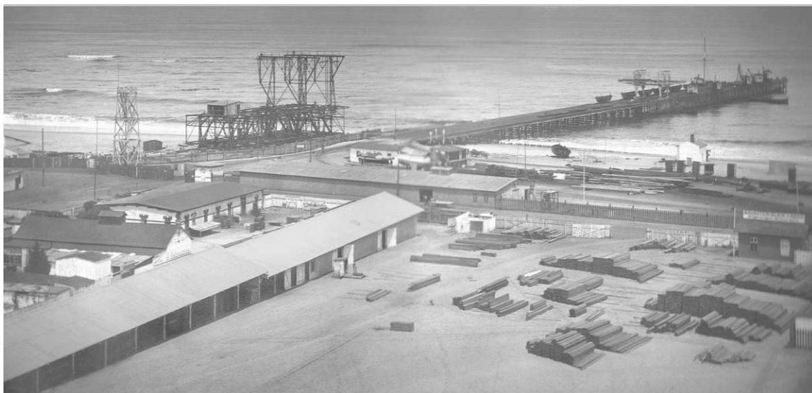
Abb. 40: Die Aufnahme zeigt das Bohrgestell, welches vor Baubeginn Ende 1911 errichtet wurde
