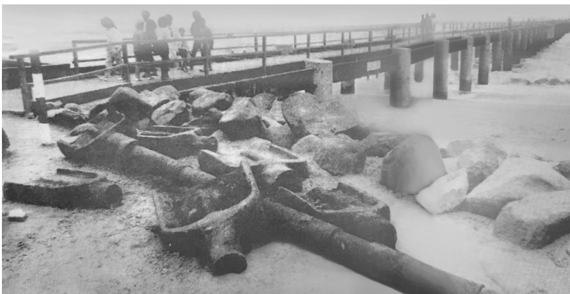
Abb. 53: Interessanter Fund: Während der Sanierung wurden alte Bohrwinden aus der Kolonialzeit geborgen.
