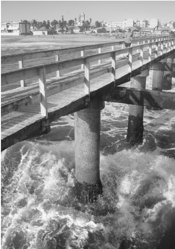
Abb. 60: Die Brücke nach der Sanierung. ©Yoko Rödel
