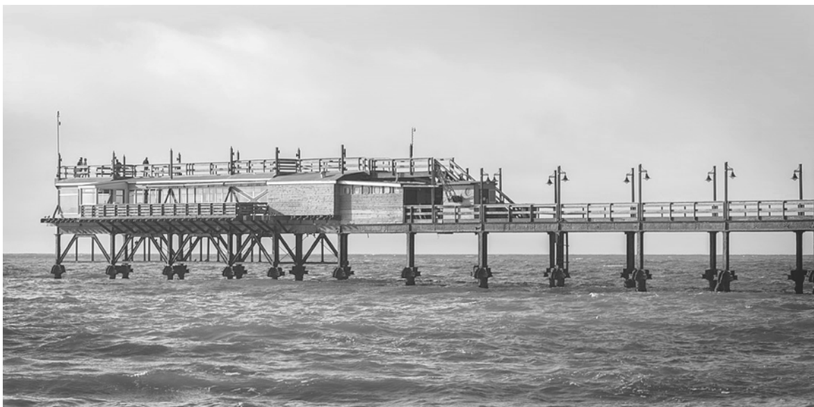
Abb. 59: Das Konstruktionsmaterial des Brückenkopfes zeugt noch heute von einer überragenden Qualität. ©Yoko Rödel
