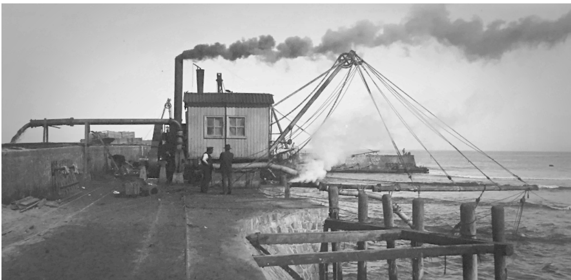
Abb. 26: Ob das was wird? Mit großer Skepsis beobachten Hafenamts-Mitarbeiter die Arbeit des Pumpenbaggers. ©AWGS
