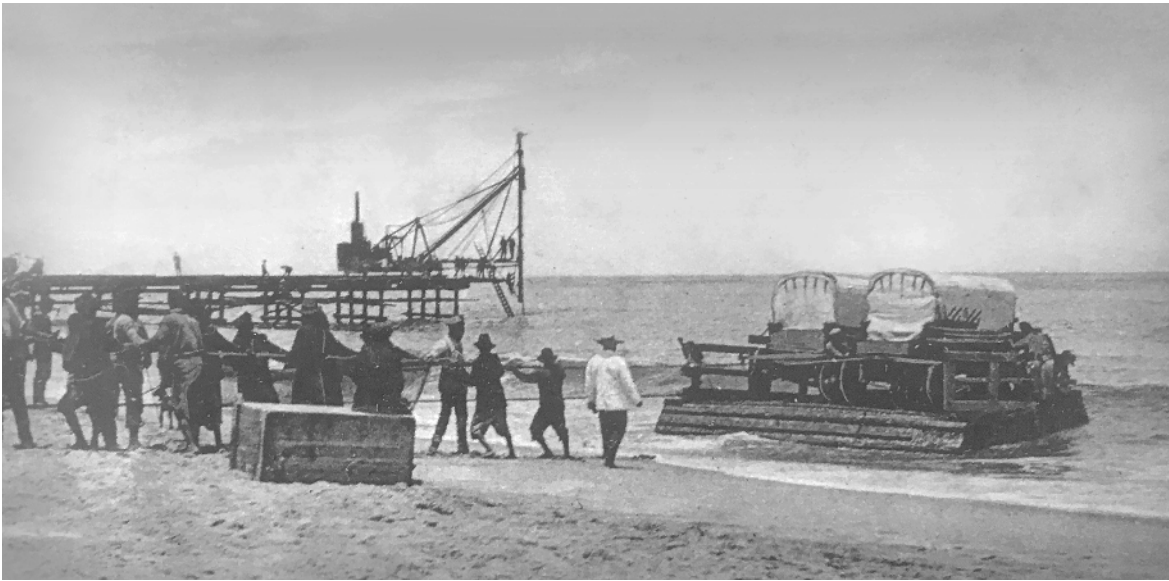
Abb. 31: Der Bohrwurm lies die hölzerne Landungsbrücke binnen kürzester Zeit baufällig werden.
