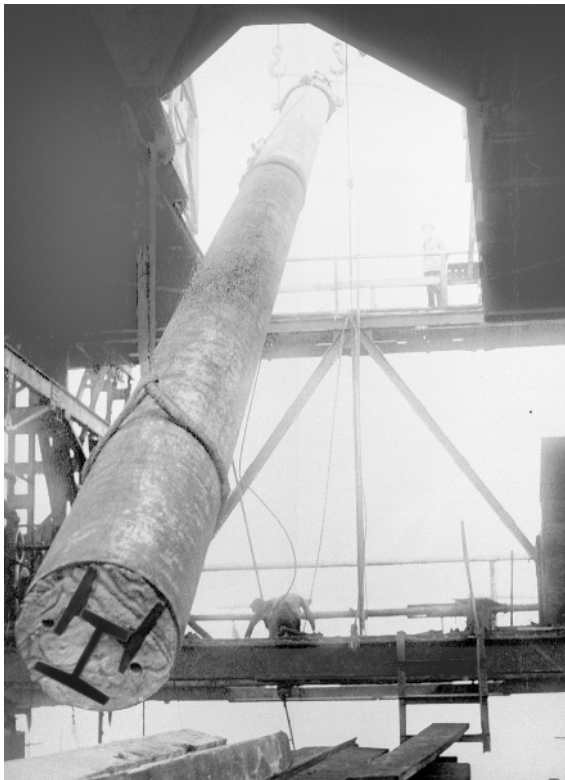
Abb. 44: Der Kern der Pfähle bestand aus zwei I-Profilen. ©AWGS
