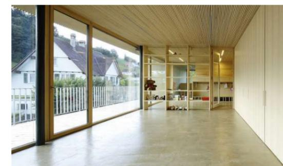
Abb. 07: Durch die raumhohen Fenster wird ein hoher Energieertrag erlangt, der im Stampflehm Boden gespeichert wird.
