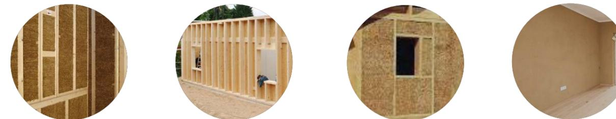
Abb. 08, 09, 10, 11: Die Abbildungen der gewählten Konstruktion: Holzständerwände, welche mit Strohballen ausgefacht und im Inneren mit Lehmputz versehen werden.
