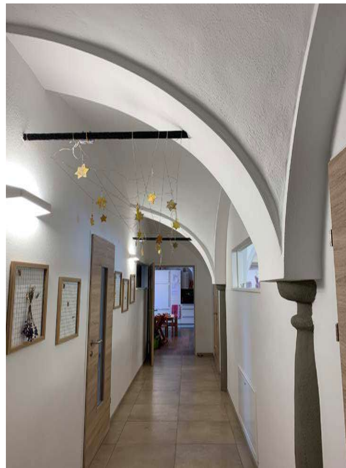
Abb. 3.24 | Gewölbe mit Zugstangen Hardeggerhof, Ramingdorf
