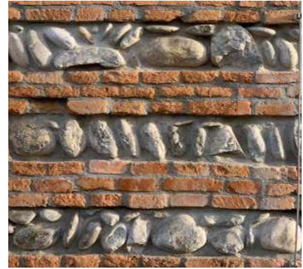
Abb. 1.31 | Streifenmauerwerk
