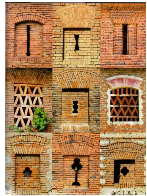
Abb. 1.26 | Variationen an gemauerten Spatzengittern
