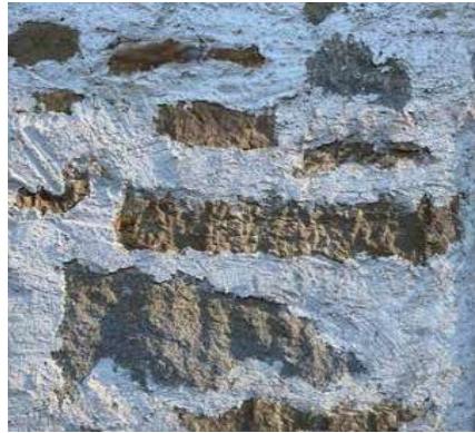
Abb. 1.33 | Steinmauerwerk halb verputzt
