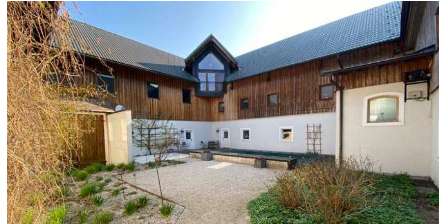
Abb. 4.32 | Innenhof Blick nach Nordosten
