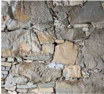
Abb. 1.32 | Sichtsteinmauerwerk
