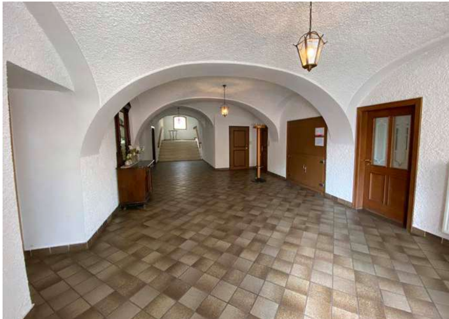
Abb. 4.17 | Gewölbe im Vorhaus
