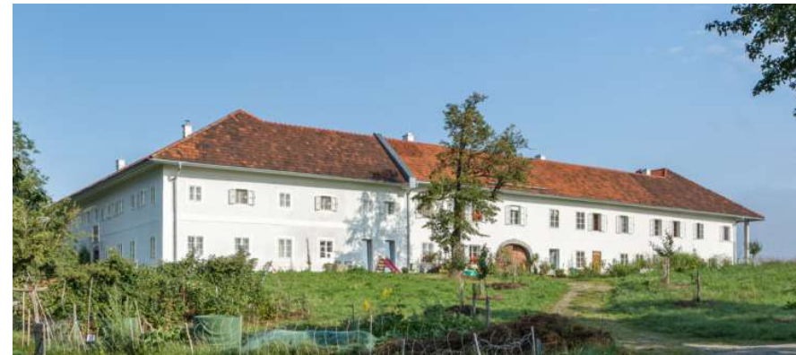
Abb. 3.28 | Dach mit alten Ziegeln, Mayr in der Wim, Garsten
