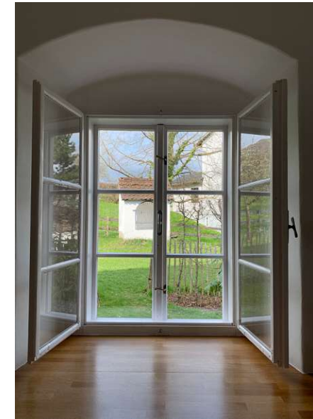
Abb. 3.33 | saniertes Kastenfenster innen
