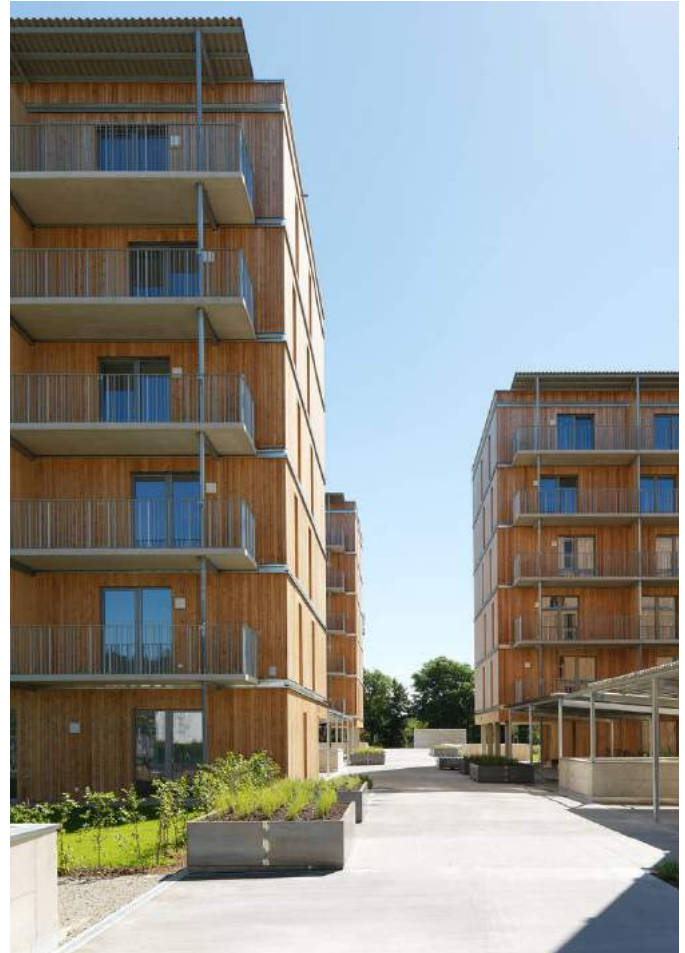
Abb. 4.2. Hummelkaserne, vorgefertigte Fassaden
