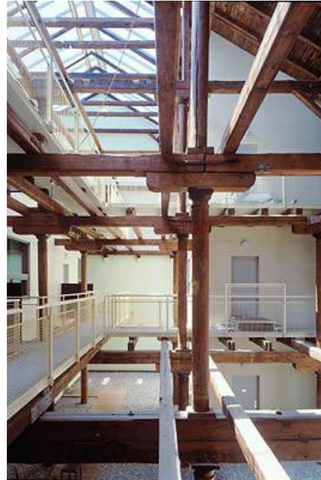
Abb. 2.2. Ehemalige Stadtmühle Erschließungskern
