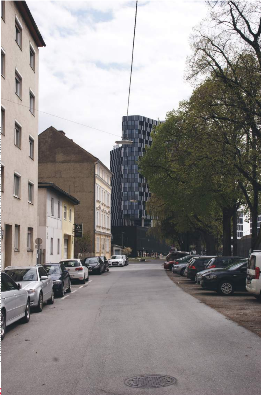
Abb. 7.2. Obere Bahnstraße 61/63, Zugang von Westen mit Styria Center im Hintergrund
