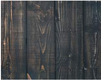
Fassade Außen Stülpchalung Lärche, geflämmt
