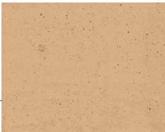
Wand Innen Lehmputz Material von Kelleraushub und Tiefenbohrung
