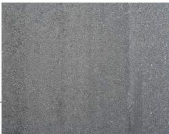
Höfe Bodenbelag Asphalt
