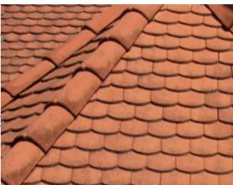
Dachschindeln Terrakotta wiederverwendete Ziegel vom alten Dachstuhl
