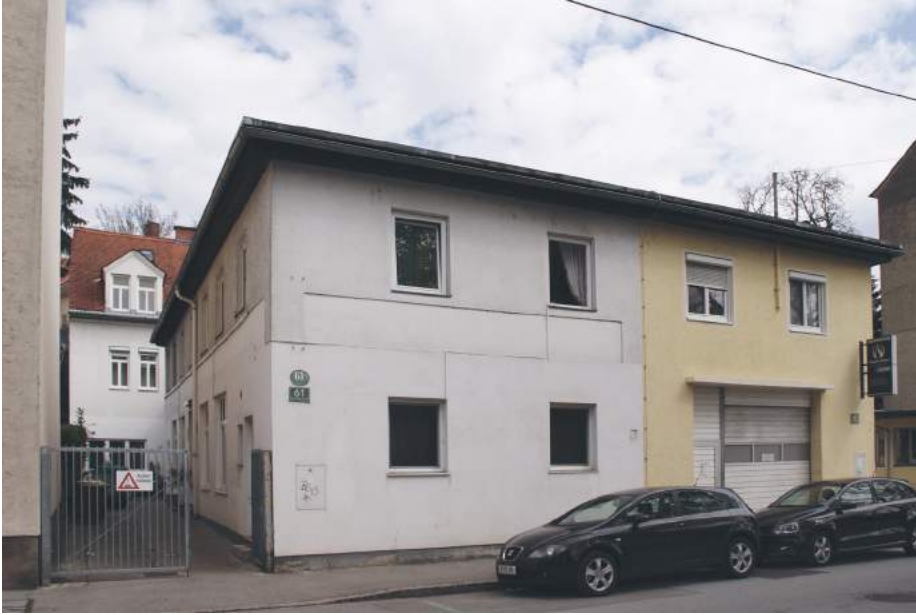
Abb. 7.4. Vorderhaus Obere Bahnstraße 61 und 63, Blick von Süden
