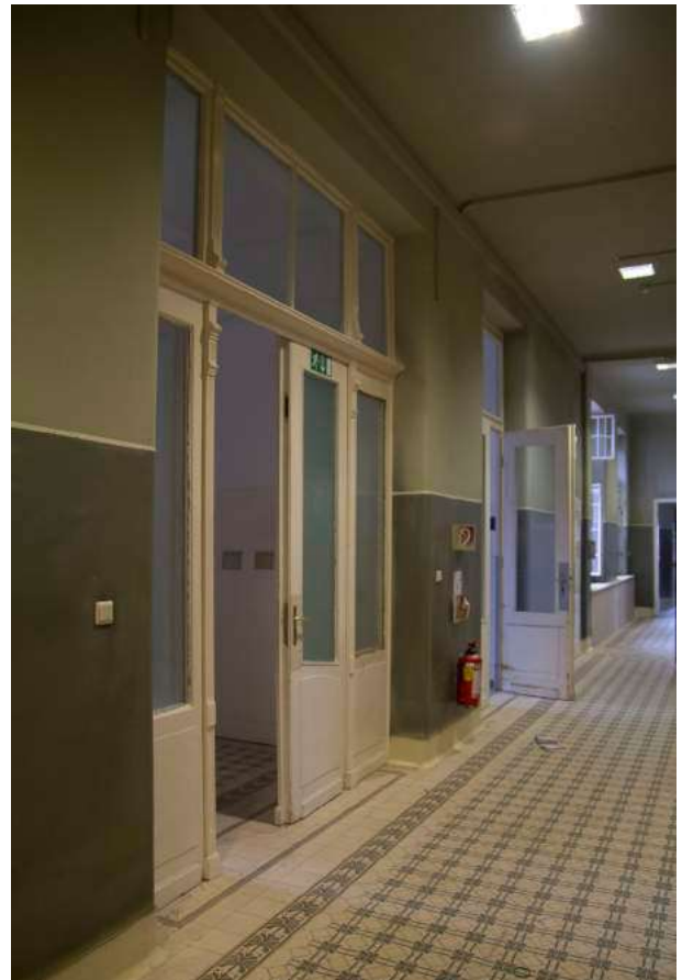
Abb. 55: Gangbereich im 1. Obergeschoß
