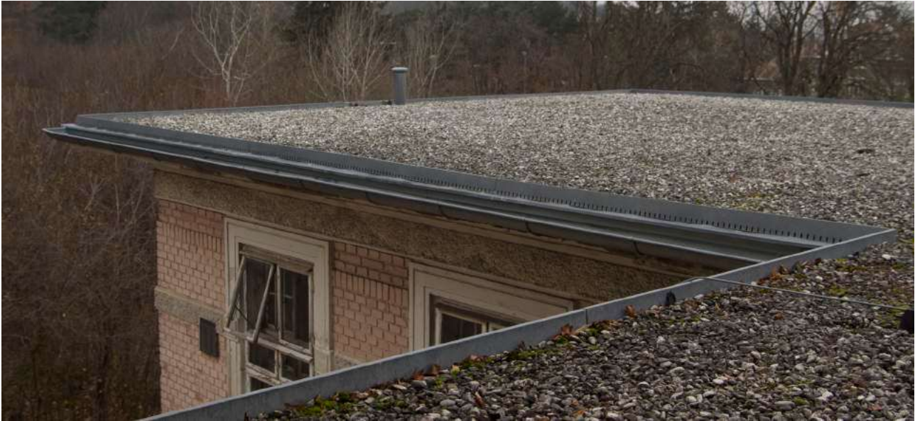
Abb. 42: Gesimse und Dachaufbau des Pavillon 22
