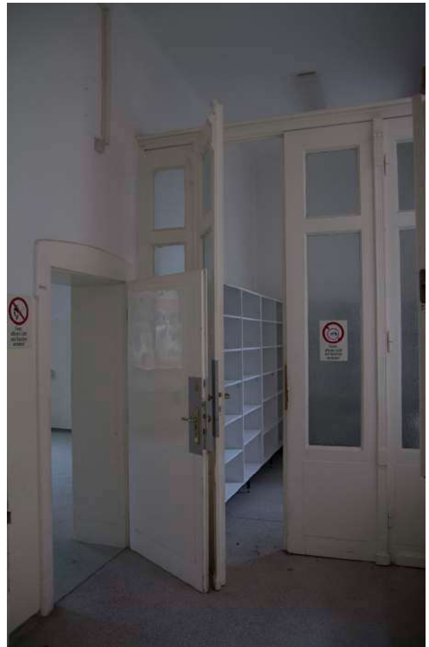
Abb. 53: Türen im ursprünglichen Zustand erhalten
