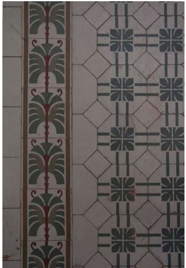
Abb. 59: Mettlacher Platten im Pavillon 22
