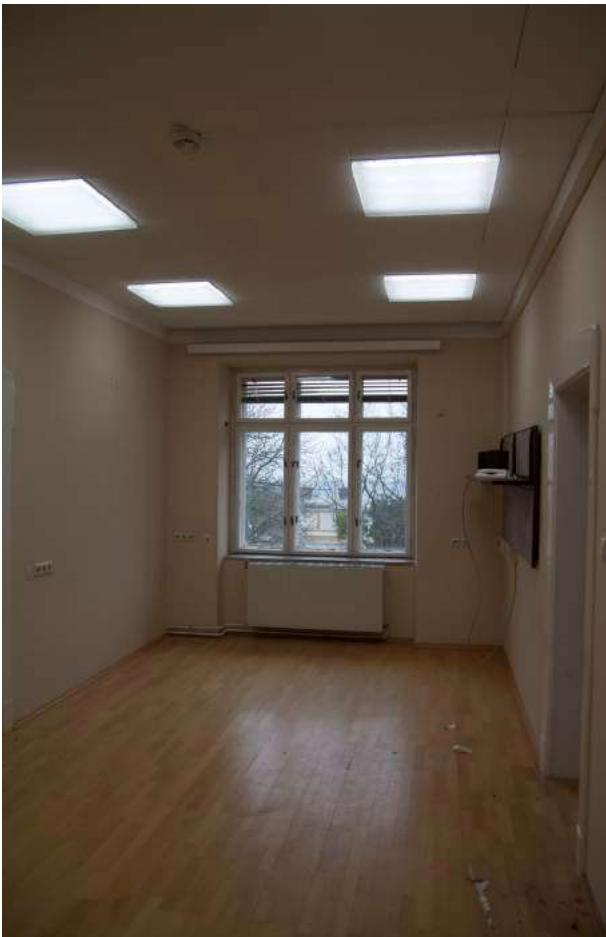
Abb. 56: abgehängte Decken im Dachgeschoß
