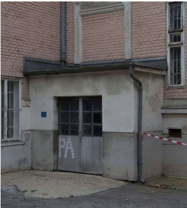
Abb. 44: Windfang im Eingangsbereich des Liftes
