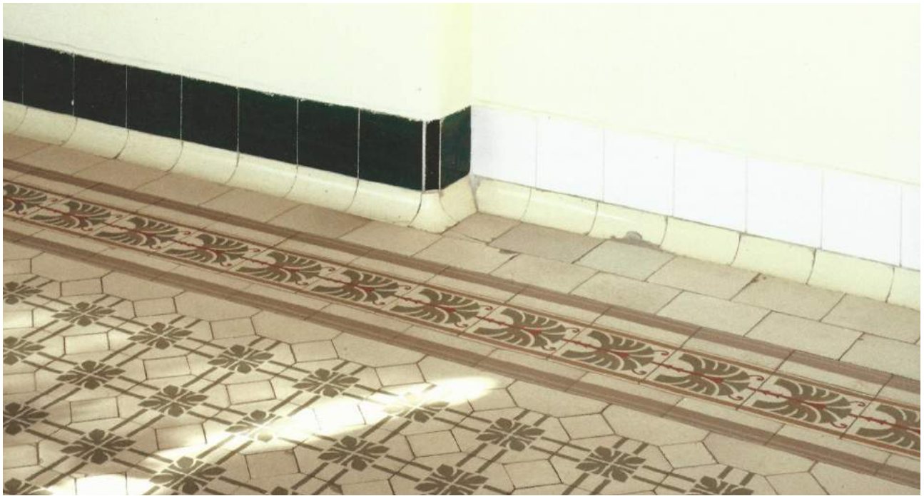
Abb. 39: Mettlacher-Platten in den Pavillons
