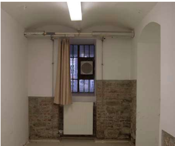
Abb. 37: Ziegelkappendecken im Untergeschoß
