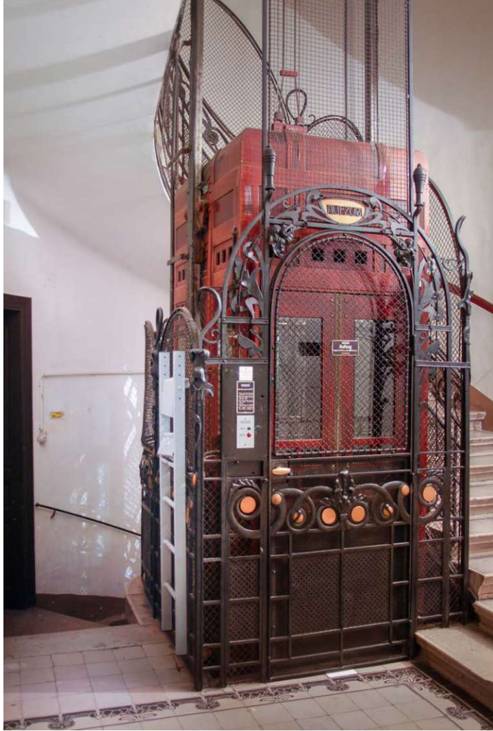
Abb 4.103 1040 Wien, Schikanedergasse, Demontage 2011
