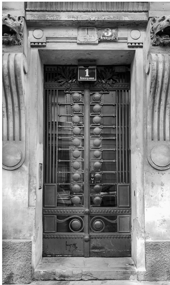
Abb 4.09 1150 Wien, Tor aus Gusseisen, errichtet um 1900
