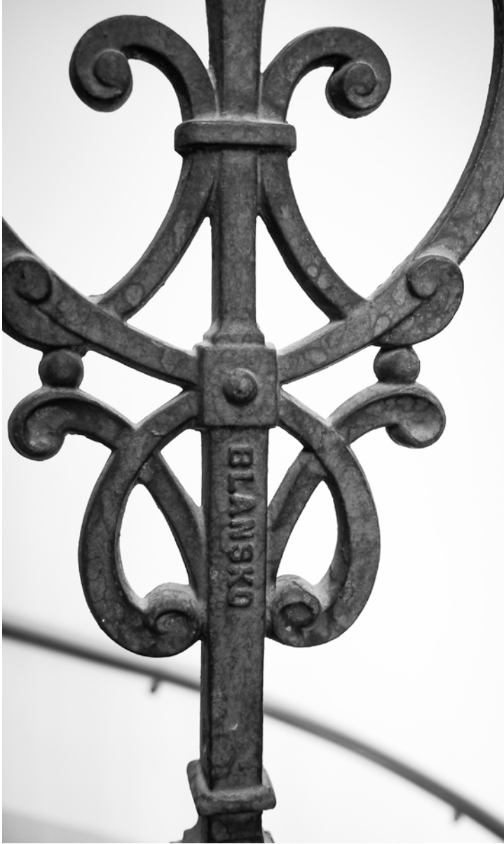
Abb 4.50 1020 Wien, Detail der Geländerstäbe
