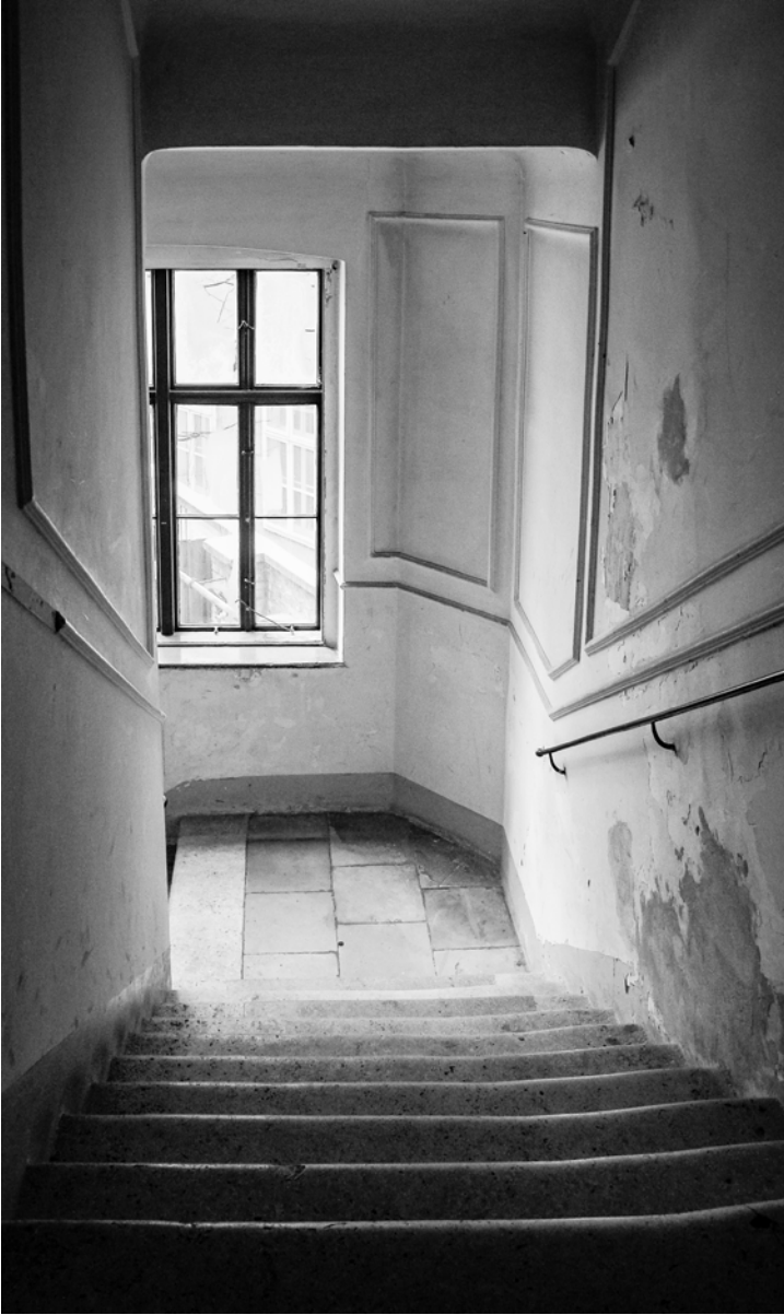
Abb 4.17 1020 Wien, frühgründerzeitliches Wohnhaus, Errichtungsjahr unbekannt
