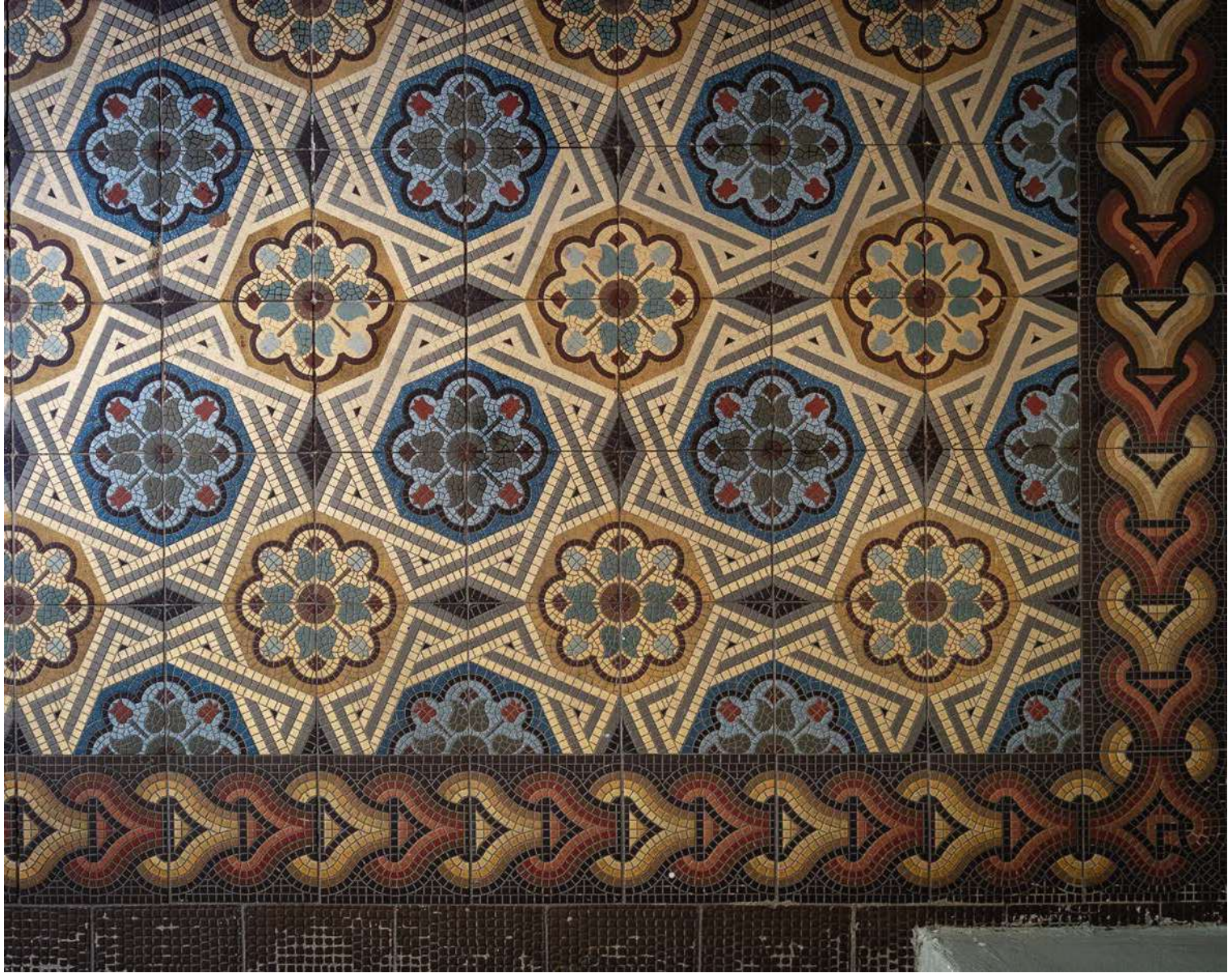
Abb 4.74 1080 Wien, Mosaikplattenbelag, vermutlich von der Fabrik Wienerberger, errichtet 1898
