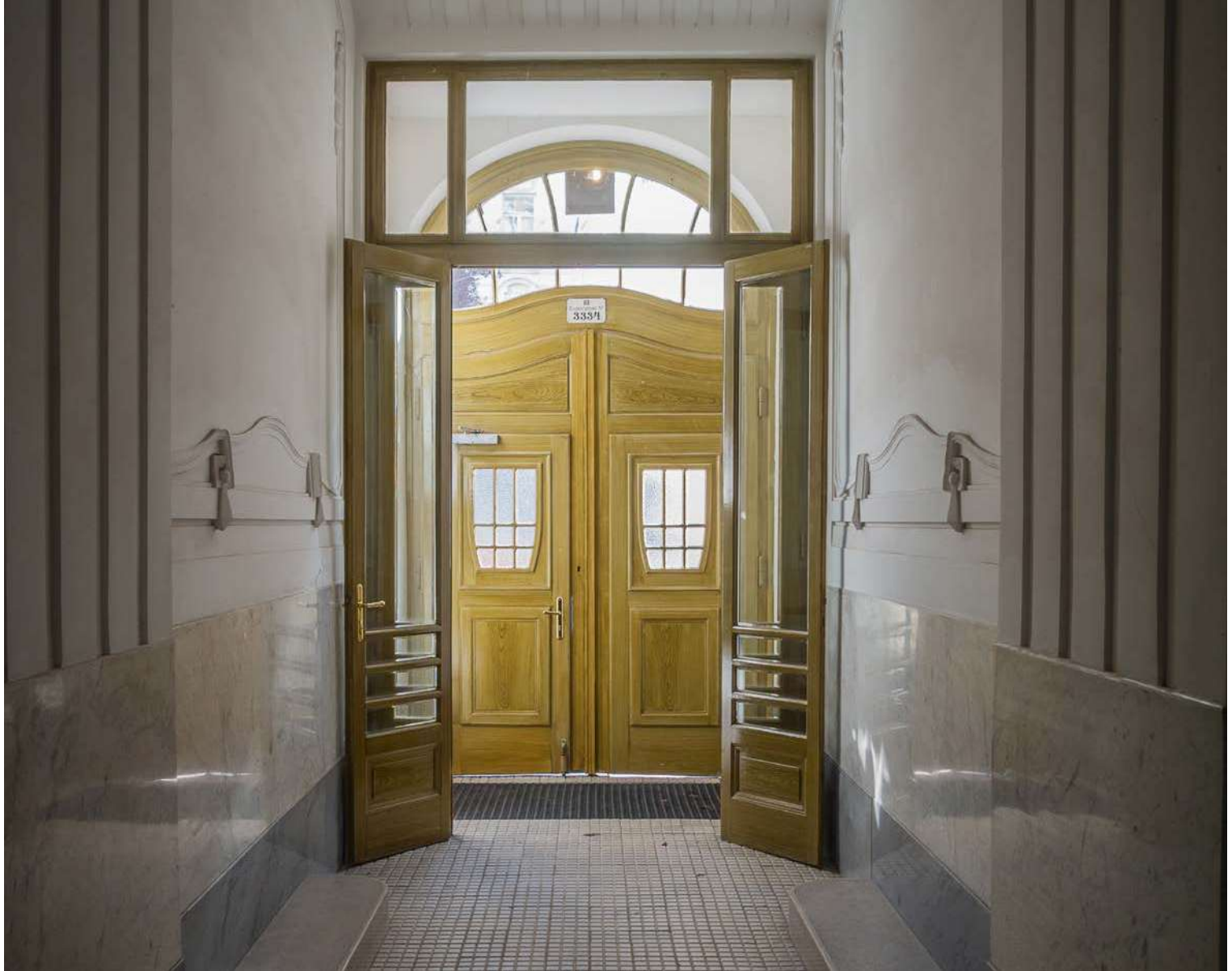
Abb 4.10 1030 Wien, Vestibül mit „Windfang“, errichtet 1906
