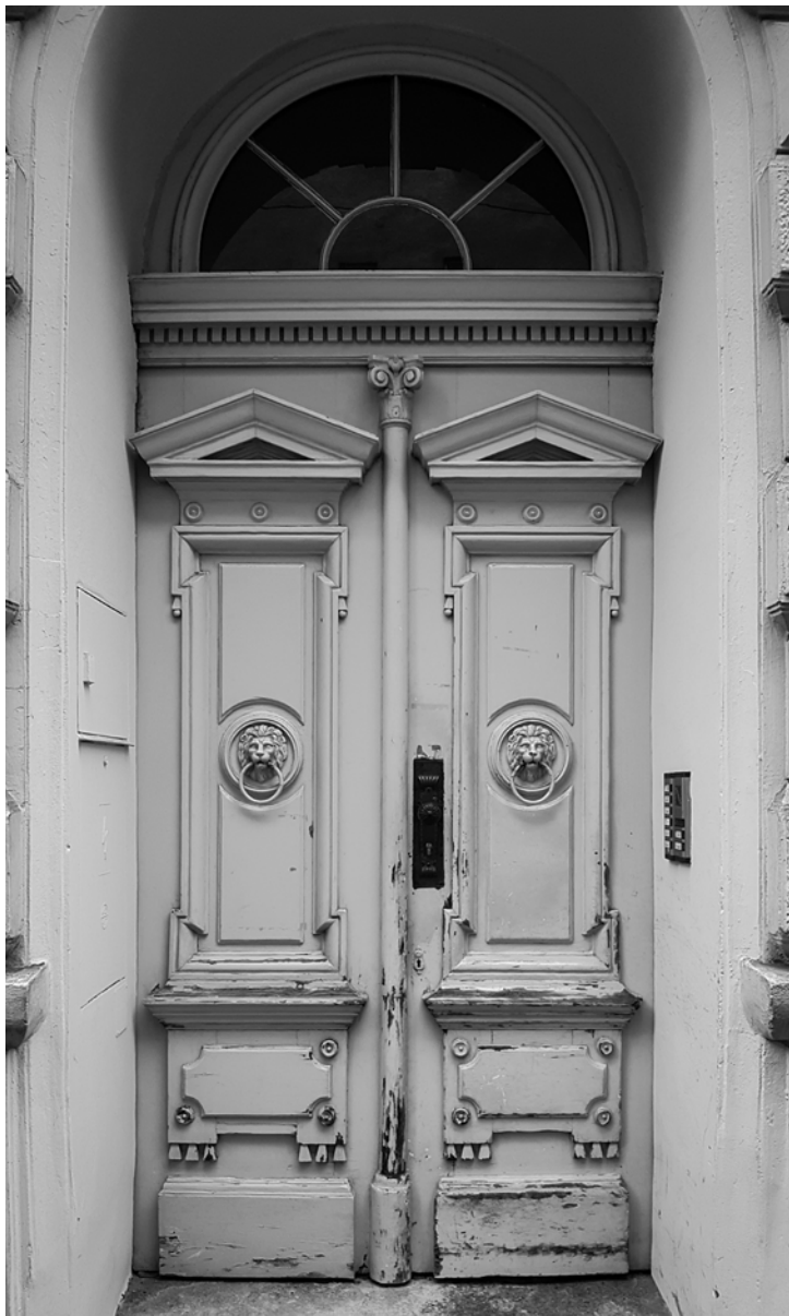
Abb 4.06 1020 Wien, Eingangstor aus Holz mit Türklopfer, errichtet 1882
