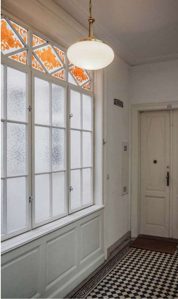
Abb 4.62 1030 Wien, Jugendstilfenster mit gegliederter Oberlichte, errichtet 1910
