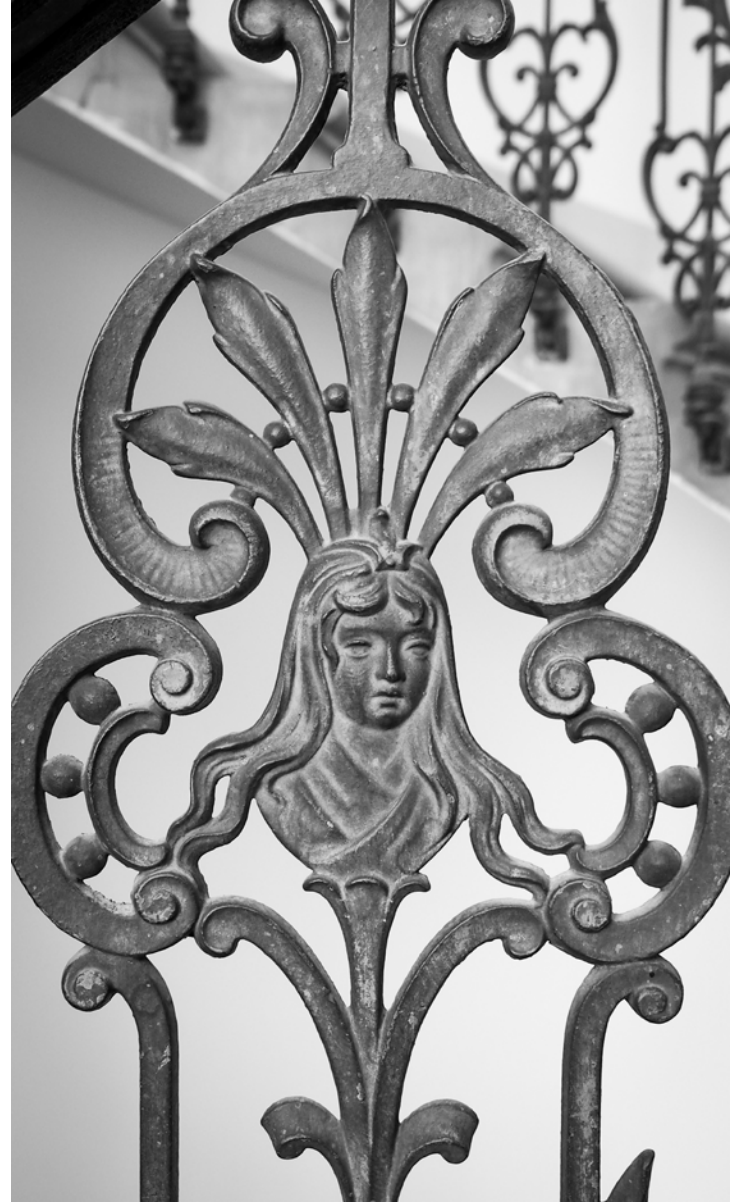
Abb 4.49 1020 Wien, Detail der Geländerstäbe
