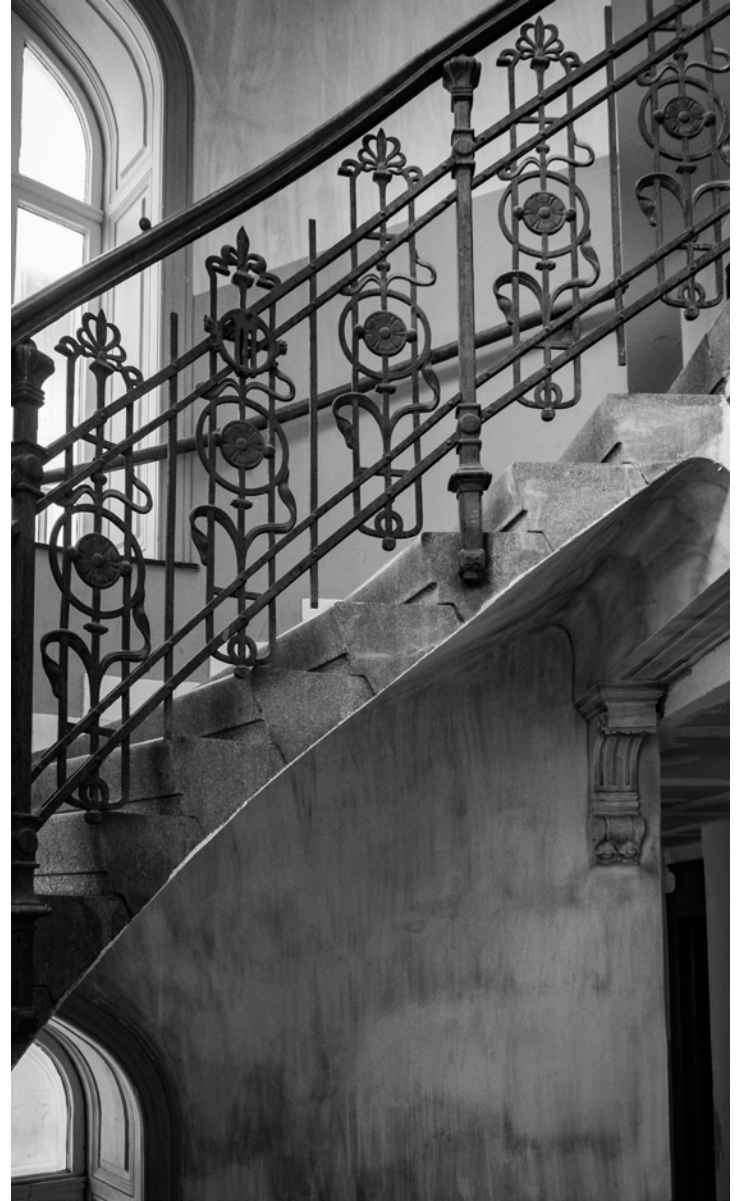
Abb 4.15 1160 Wien, freitragende Stiege (vermutlich Kunststein)
