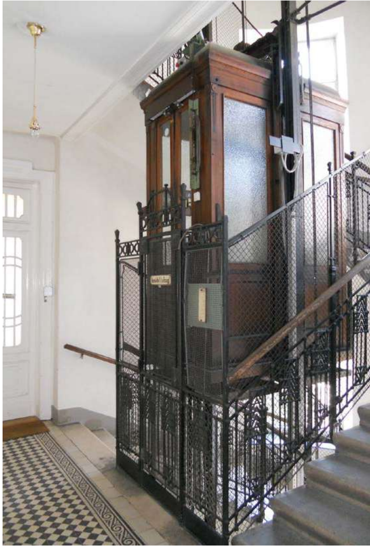
Abb 4.101 1030 Wien, Keilgasse, Demontage 2018
