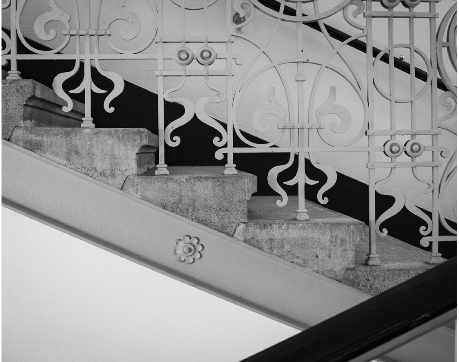
Abb 4.21 1020 Wien, Stufen auf Wangenträger, Errichtungsjahr 1905
