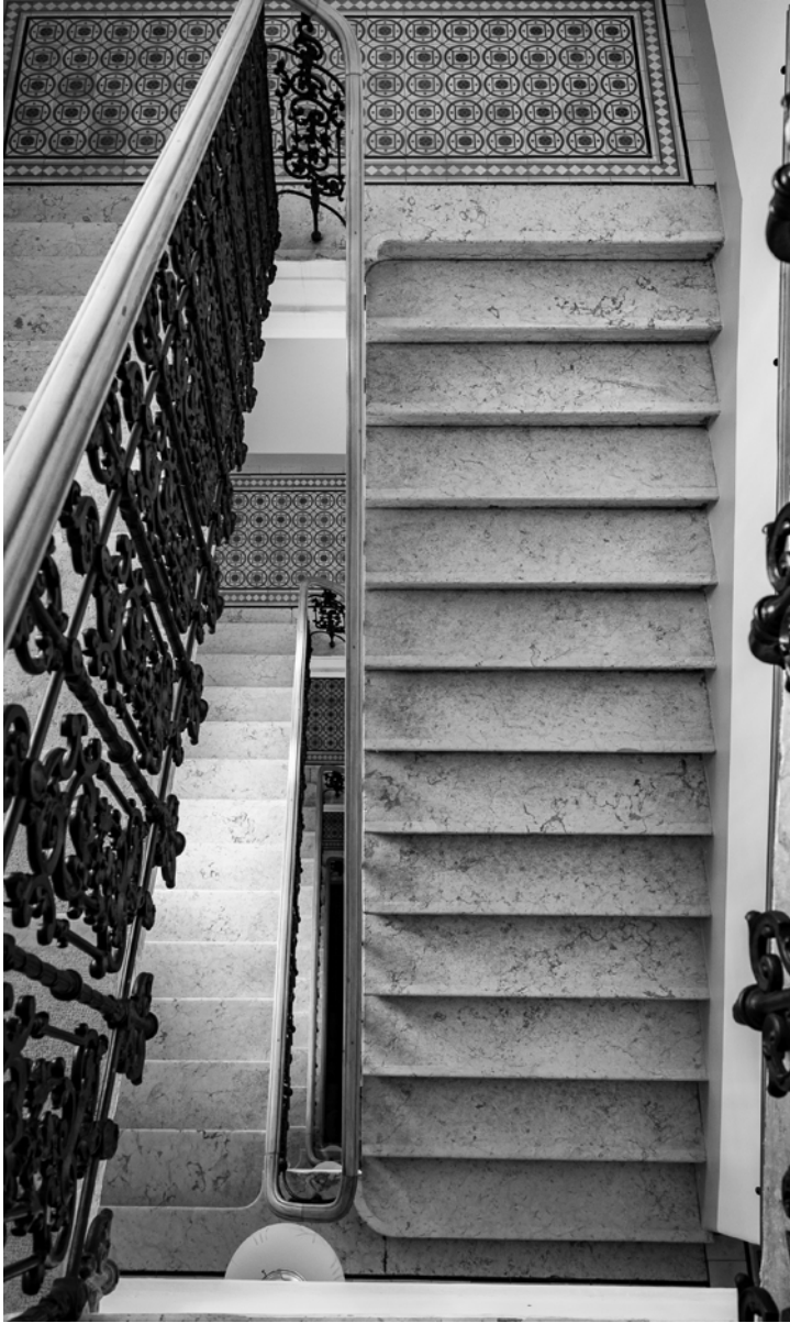
Abb 4.30 1080 Wien, gerade, freitragenden, zweiarmige Stiege, 1898
