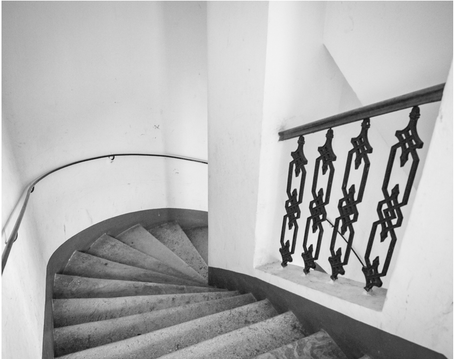
Abb 4.19 1020 Wien, durchbrochene Spindelmauer, Errichtungsjahr unbekannt
