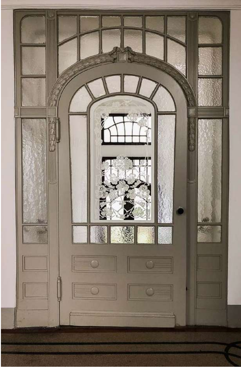
Abb 4.11 1130 Wien, Vestibül mit Windfang, errichtet 1903
