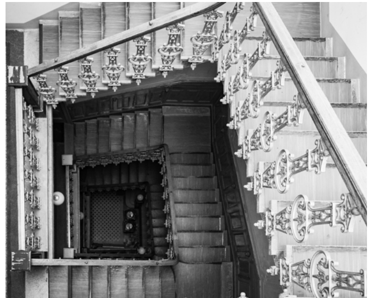
Abb 4.26 1020 Wien, nachträglicher Aufzugseinbau, 1908
