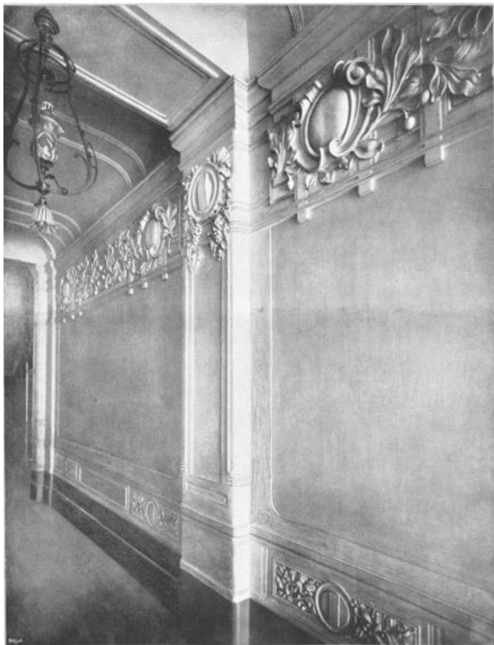
Abb 4.108 1150 Wien, Vestibül Sechshauser Straße, 1904/1905
