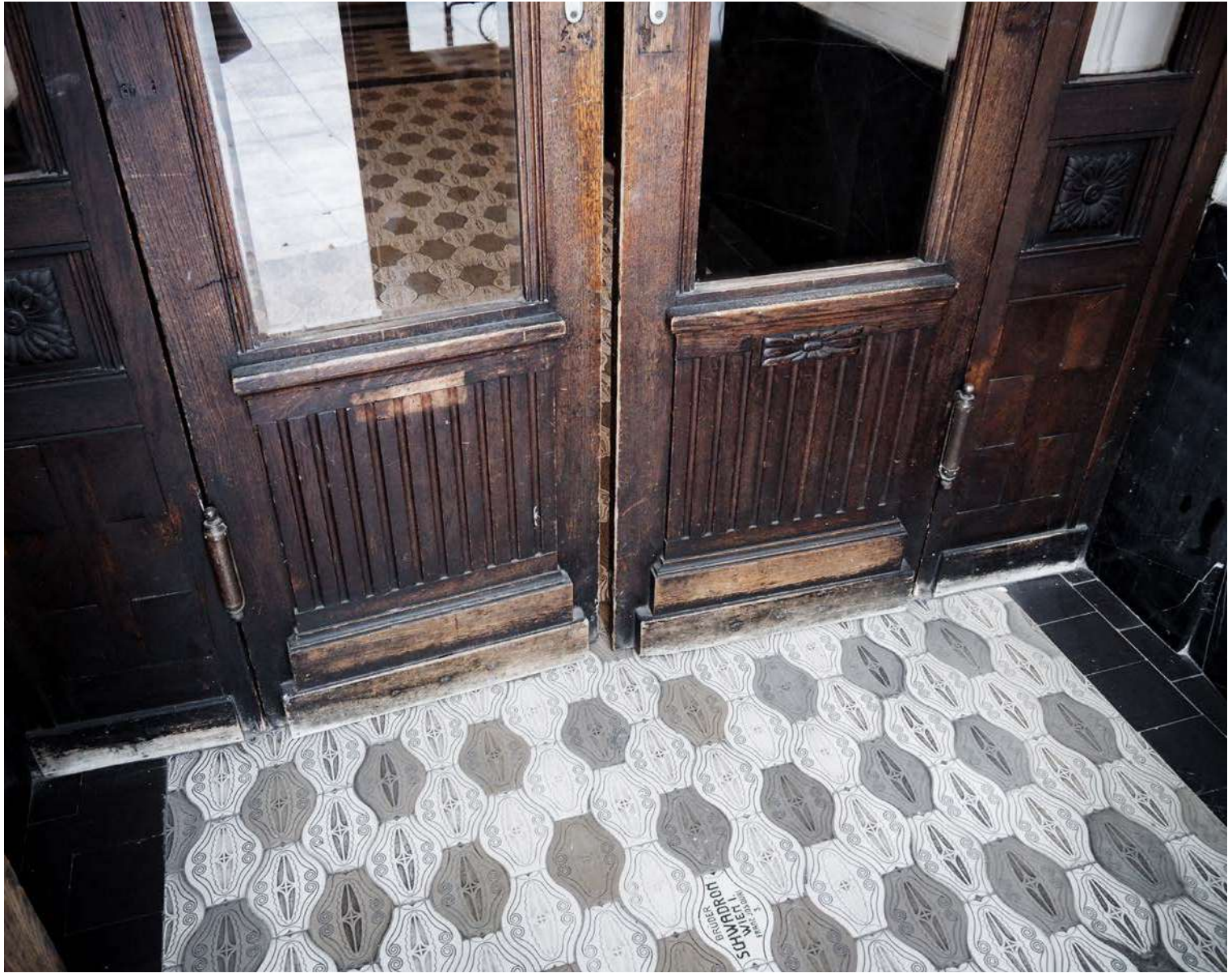
Abb 4.82 li + re: 1090 Wien, Bodenfliesen, Brüder Schwadron, errichtet 1912
