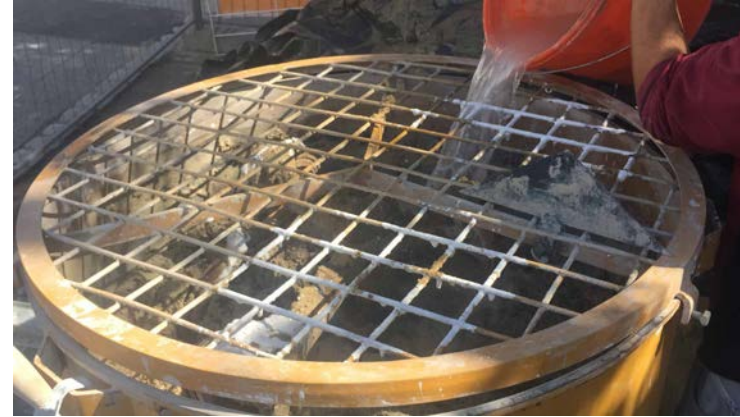
Abb. 257: Herstellung des Kalkputzes auf der Baustelle aus Löschkalk, Sand und Wasser.
