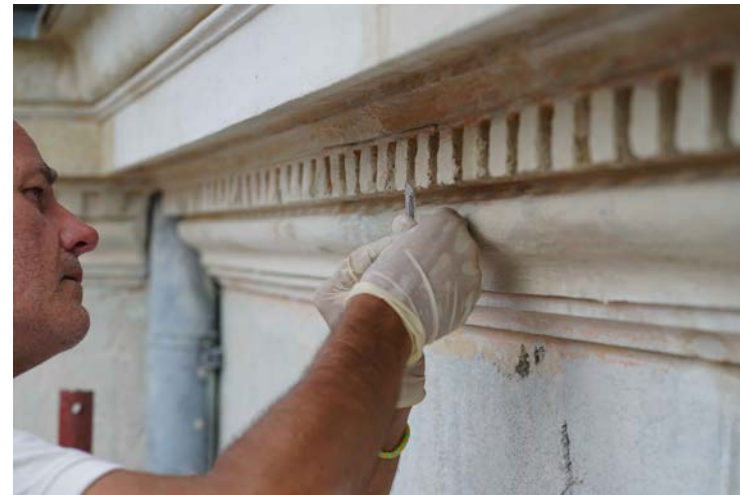
Abb. 258: Ausbesserung des Abschlussgesimses mit Kalkputz und Skalpell.
