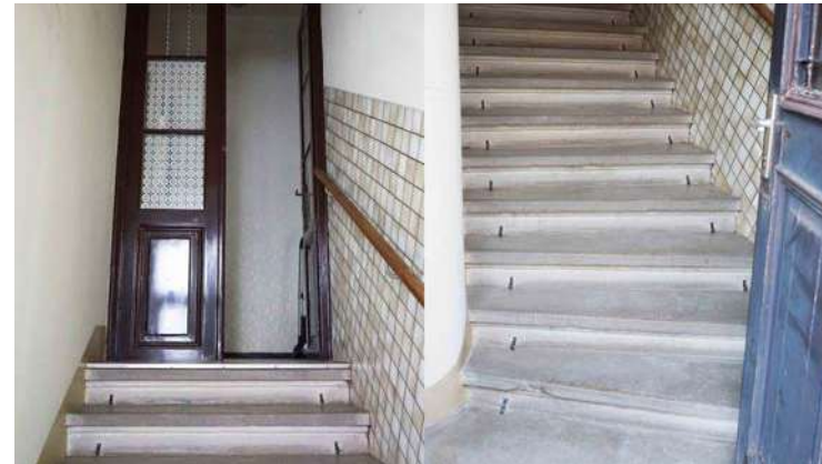
Abb. 232: Stiegenhaus, Blick vom Stiegenpodest Richtung OG.
