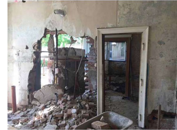
Abb. 268: Abbruch der Zwischenwände im Untergeschoß gartenseitig.
