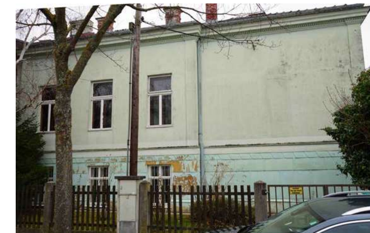
Abb. 215: Links: Putzteile mit historischer Quadrierung im unteren Fassadenbereich, straßenseitig.
