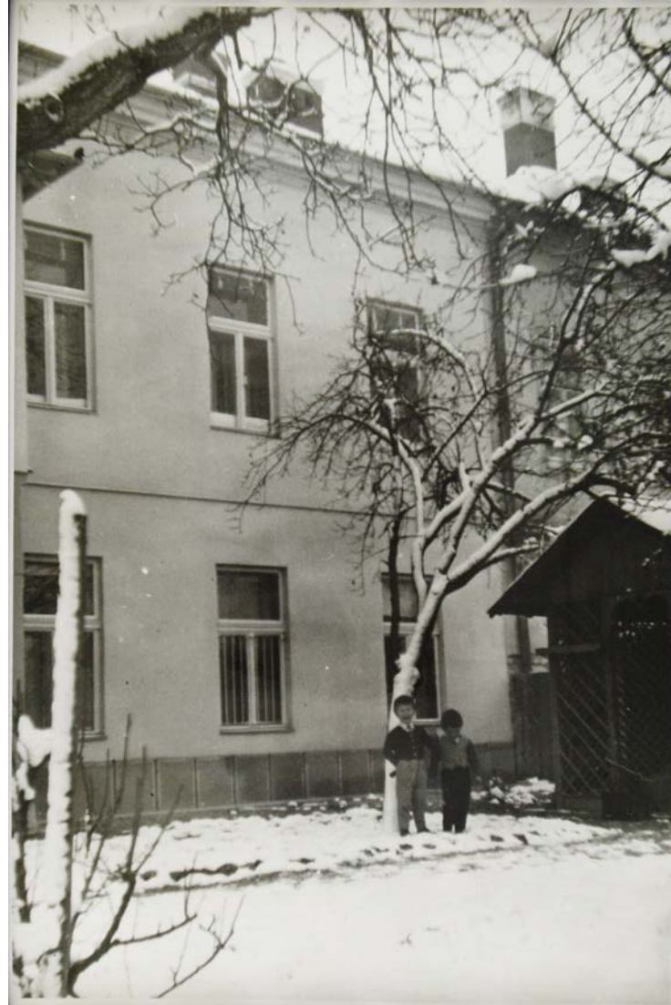
Abb. 201: Rechts oben: Rolf und Walter Schuhmeister vor der Veranda im Garten, nach der Fassadensanierung.
