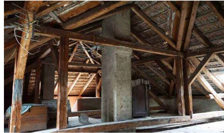
Abb. 231: Dachboden, Blick in Richtung Stiegenaufgang.
