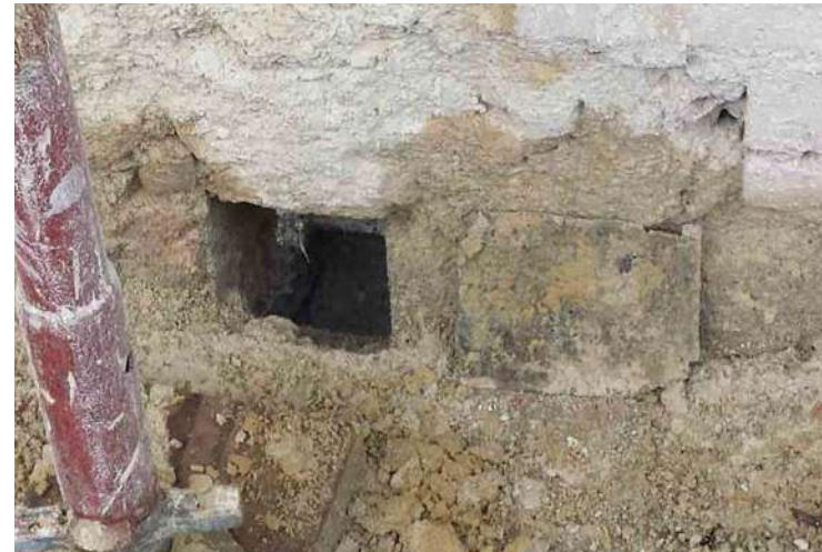
Abb. 238: Lüftungsloch an der straßenseitigen Außen- fassade.
