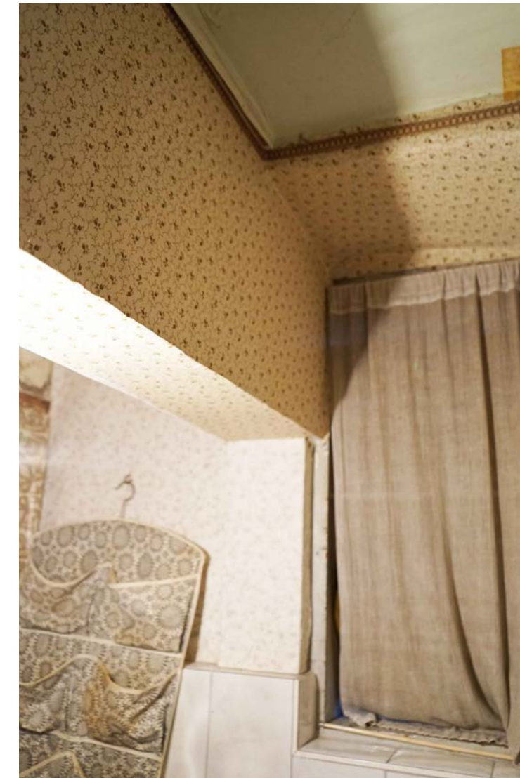
Abb. 323: links oben: Bad/ WC, Blick Richtung Vorraum und Decke, Wand c.
