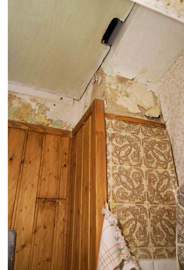
Abb. 326: links: Blick in die Dusche, Wand c.
