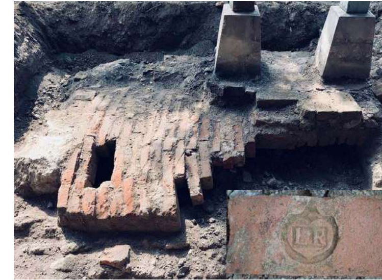
Abb. 234: Gewölbe unter der Veranda, mit Ziegeldetail.
