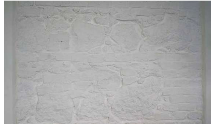
Abb. 266: Geweißelte, nicht verputzte Wand im Untergeschoß, Stein-Ziegelsichtigkeit bleibt erhalten.
