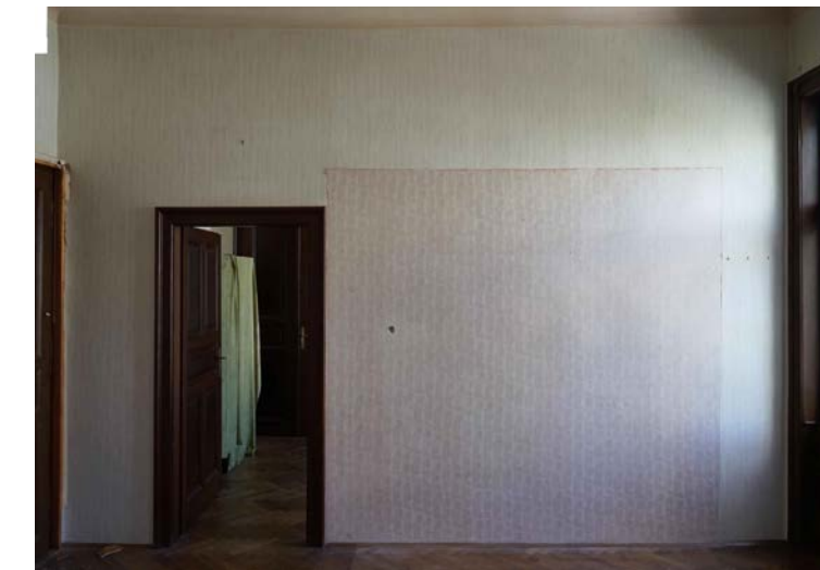
Abb. 352: Wand zum straßenseitigen Kabinett/Wand b.
