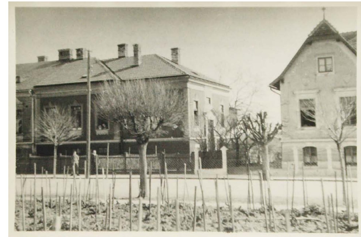
Abb. 197: Ansicht Germergasse 38 und 40 vom gegenüberliegenden Grundstück aus, 1939.
