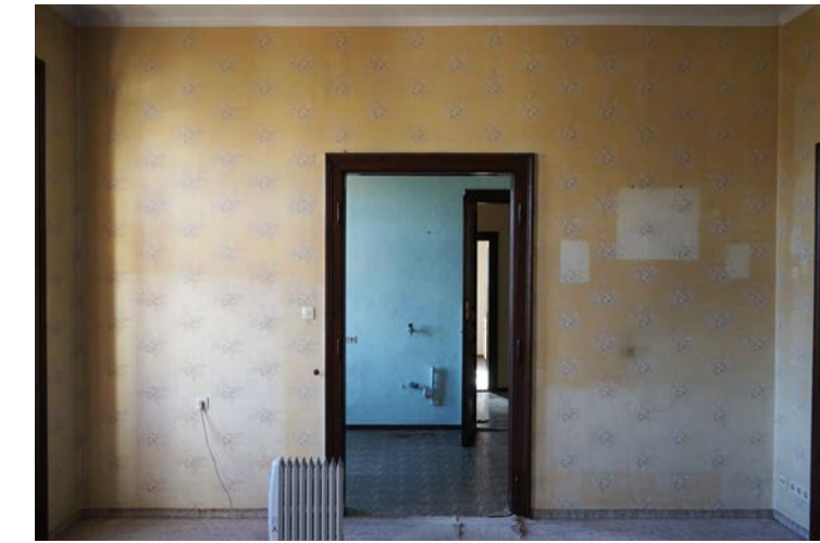
Abb. 357: links: Wandansicht Wand a, in Richtung Garten.
