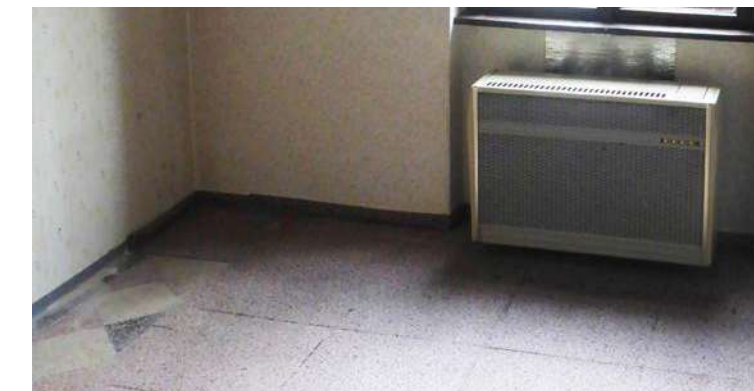
Abb. 371: Detail Fußboden zwischen Wand a und b, mit Teppichfliesen auf Terrazzofliesen.
