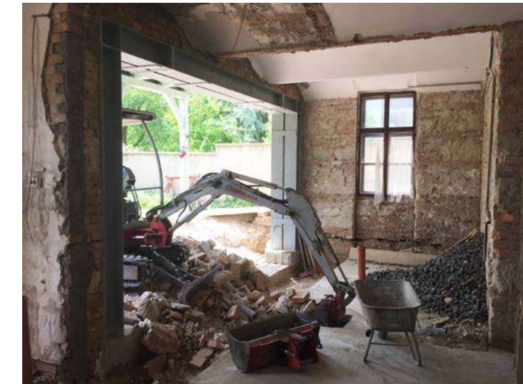
Abb. 269: Links: Herstellung des Durchbruchs und des Stahlrahmens in der Außenwand.
