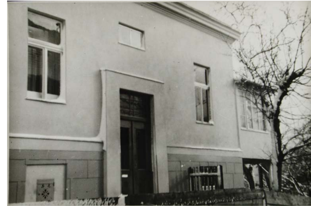
Abb. 204: Seitenansicht mit Hauseingang, Februar 1960.
