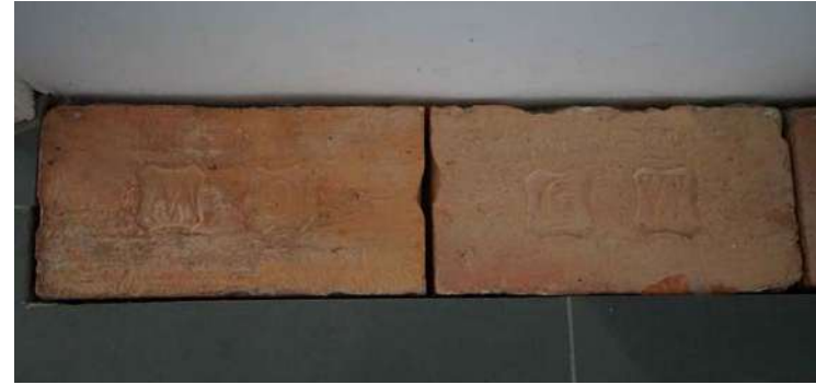
Abb. 271: Diffusionsoffener Randstreifen mit Ziegeln der abgebrochenen Zwischenwände geschlossen.
