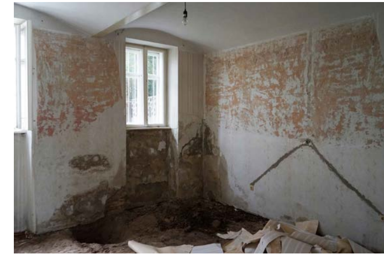
Abb. 309: links: Blick nach innen zur Mittelwand/Wand a und b.
