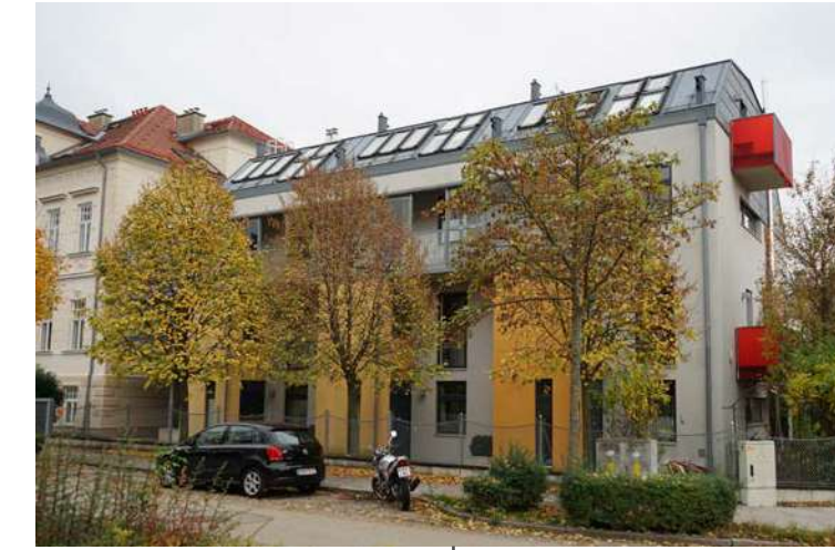
Abb. 155: links: Haus Germergasse 45 sowie Einfahrt zu dem Einfamilienhaus 43a.
