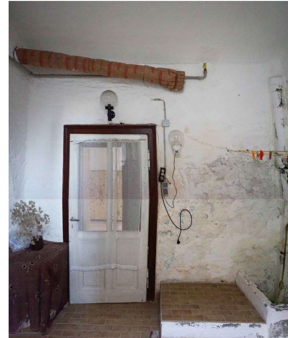
Abb. 329: Waschküche, Blick Richtung Vorraum, Wand d.
