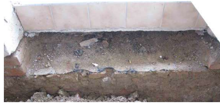
Abb. 237: Trennlage im Außenmauerwerk, garten- seitig, am Stufenabsatz bei der Gartentür.
